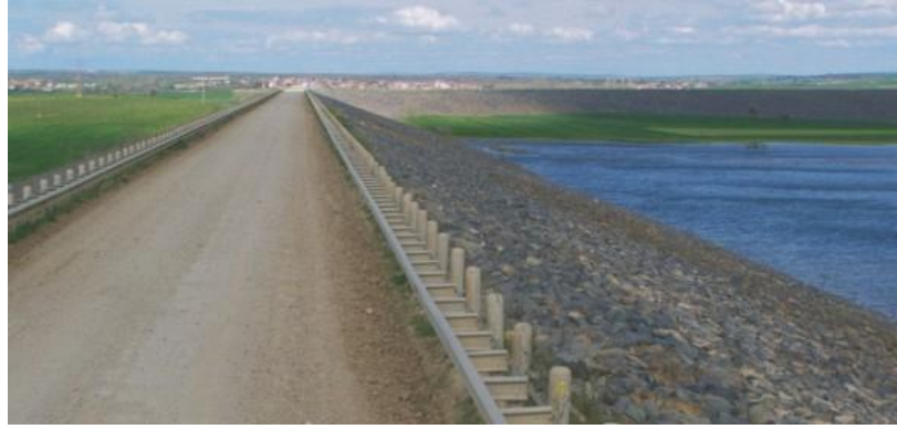
Şekil 10: Hamzadere Barajından Bir Görünüm (TMB, 2012).
