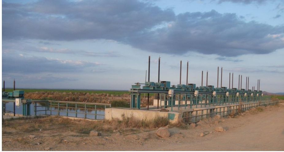
Şekil 9: Gala Gölü Ayağının Meriç Irmağı ile Birleşme Noktasındaki 10 Gözlü Menfez
