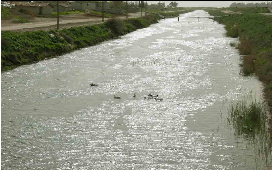
Fotoğraf 7: Muratpaşa Kanalı'nın Aktaş Köyü yakınlarından görünümü (Mart-2008)
