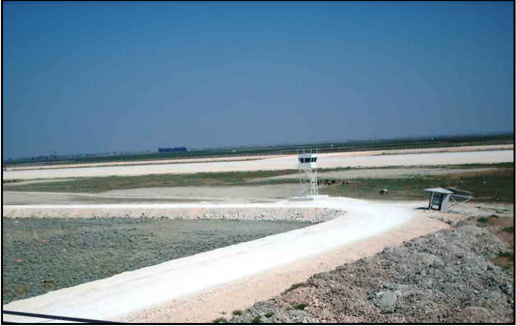
Fotoğraf 23: Eski Amik Gölü tabanında devam eden Hatay Havaalanı inşaatı (Ağustos-2007)
