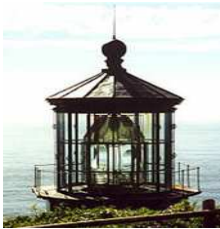
Şekil 2.27 Fresnel lensin deniz fenerinde kullanımı
