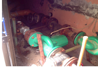
Şekil 4.17 Başaranlar-II Sitesinin Bina Altı Uygulaması.
