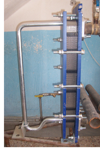
Şekil 5.10 Bazı Binaların Bina Altı Eşanjör Sistemlerinin Resmi.
