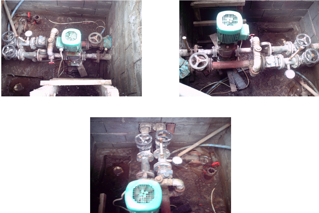
Şekil 4.19 Santrifüj Pompaya Ait Resimler.
