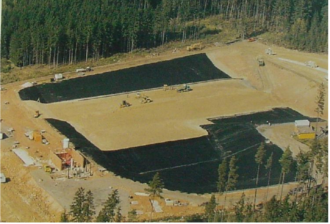
Şekil 3.3 Serilen jeomembranların üstten görünüşü [18].
