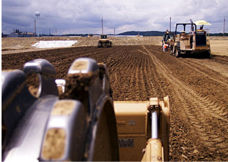
Şekil 3.2 Zeminin sıkıştırılmasına bir örnek [18].
