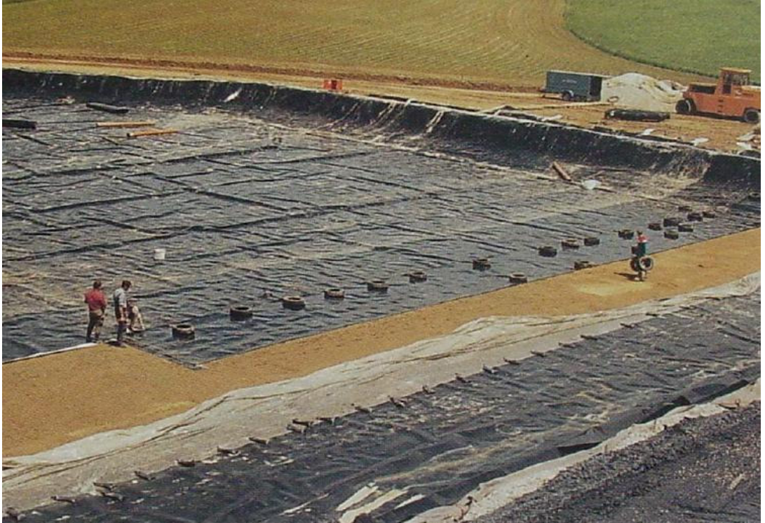
Şekil 3.4 Jeomembranların serimine bir örnek [18].
