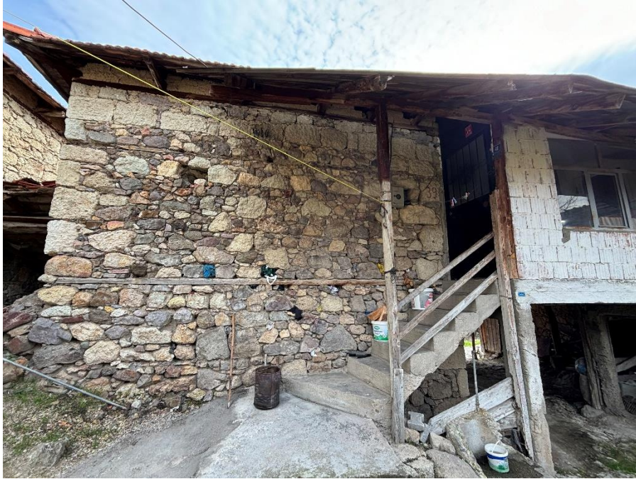
Şekil 4.55: İbrahim Gülsüm evi, yatay hatılda ahşap malzeme kullanımı (Kişisel Arşiv, 2024).
