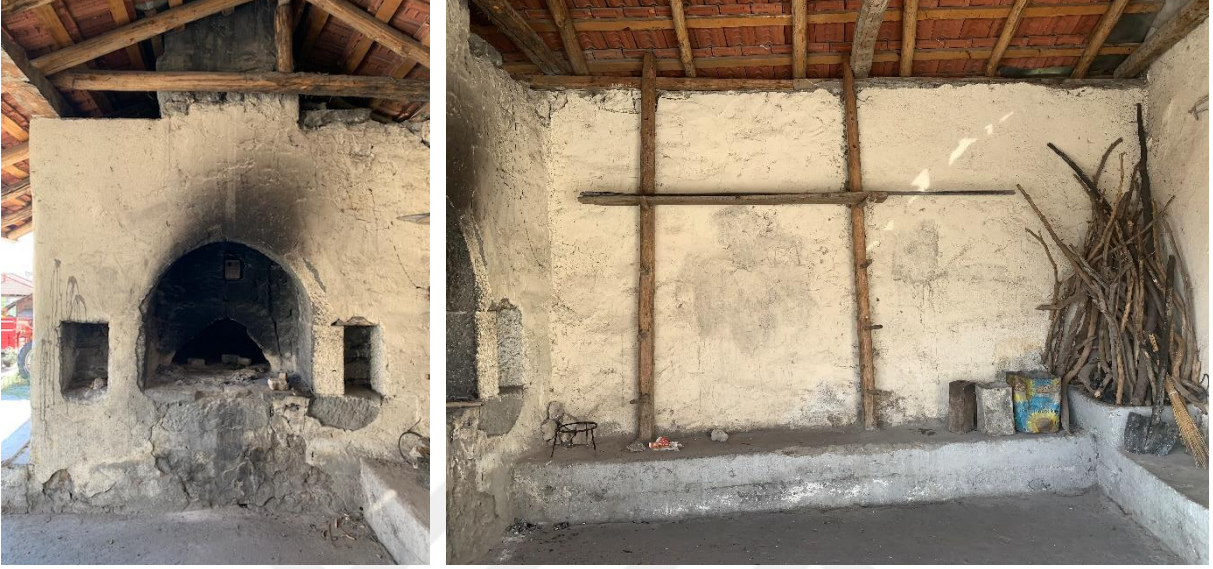
Şekil 4.10: 118 Ada 17 parselde kayıtlı fırın (Kişisel Arşiv, 2023).
