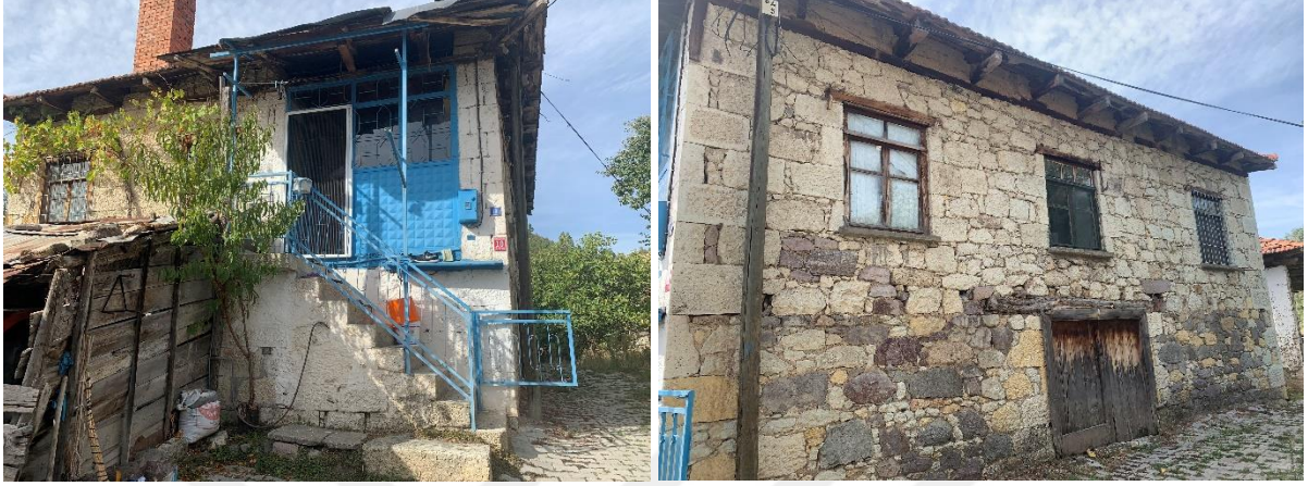
Şekil 4.42: 117 ada 9 parselde kayıtlı Mevlüt Korkut evi, giriş kapısı değiştirilen konutun ahşap çift kanatlı dam kapısının özgünlüğü korunmuş (Kişisel Arşiv, 2024).
