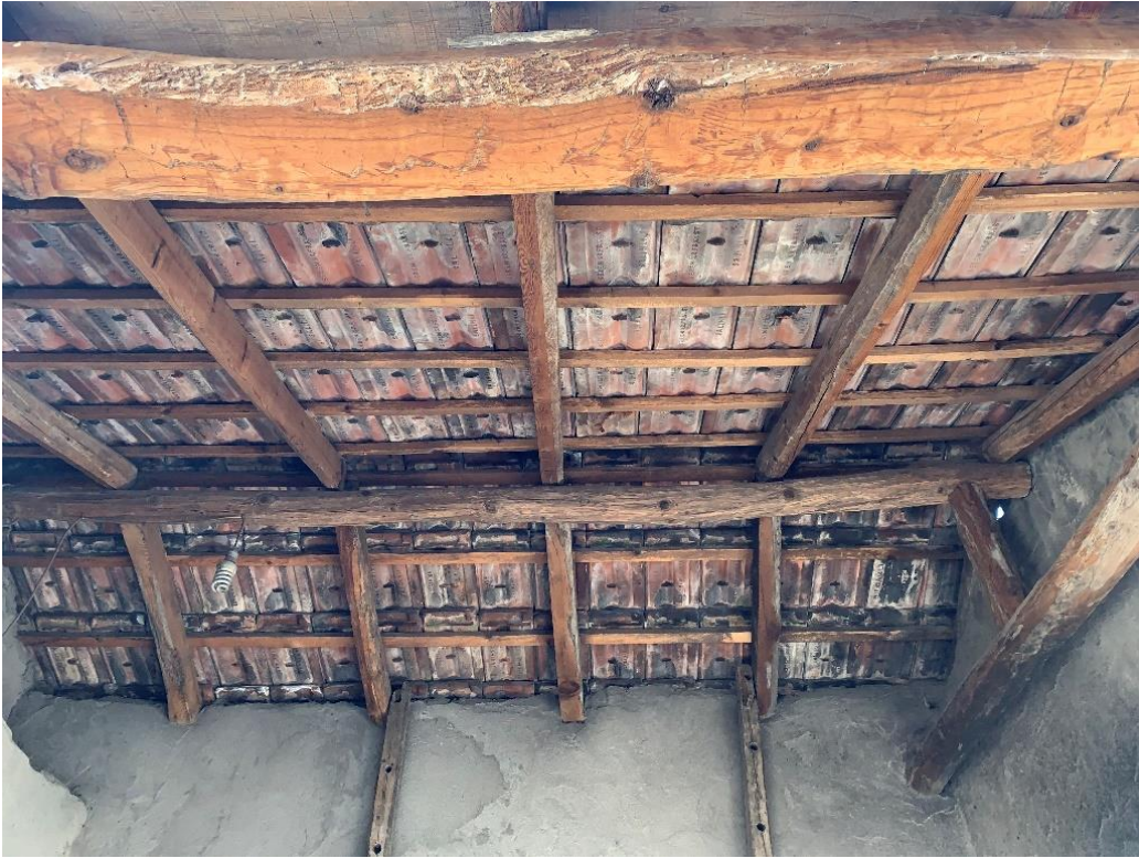
Şekil 4.11: Ahşap iskeletli, kiremit kaplamalı fırın çatısı (Kişisel Arşiv, 2023).
