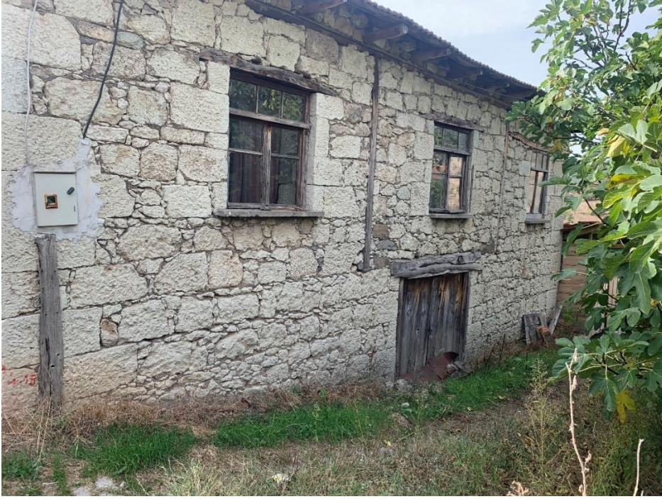
Şekil 4.46: 117 ada 3 parselde kayıtlı Mehmet Ay evi, tepe pencereli doğrama örneği (Kişisel Arşiv, 2024).
