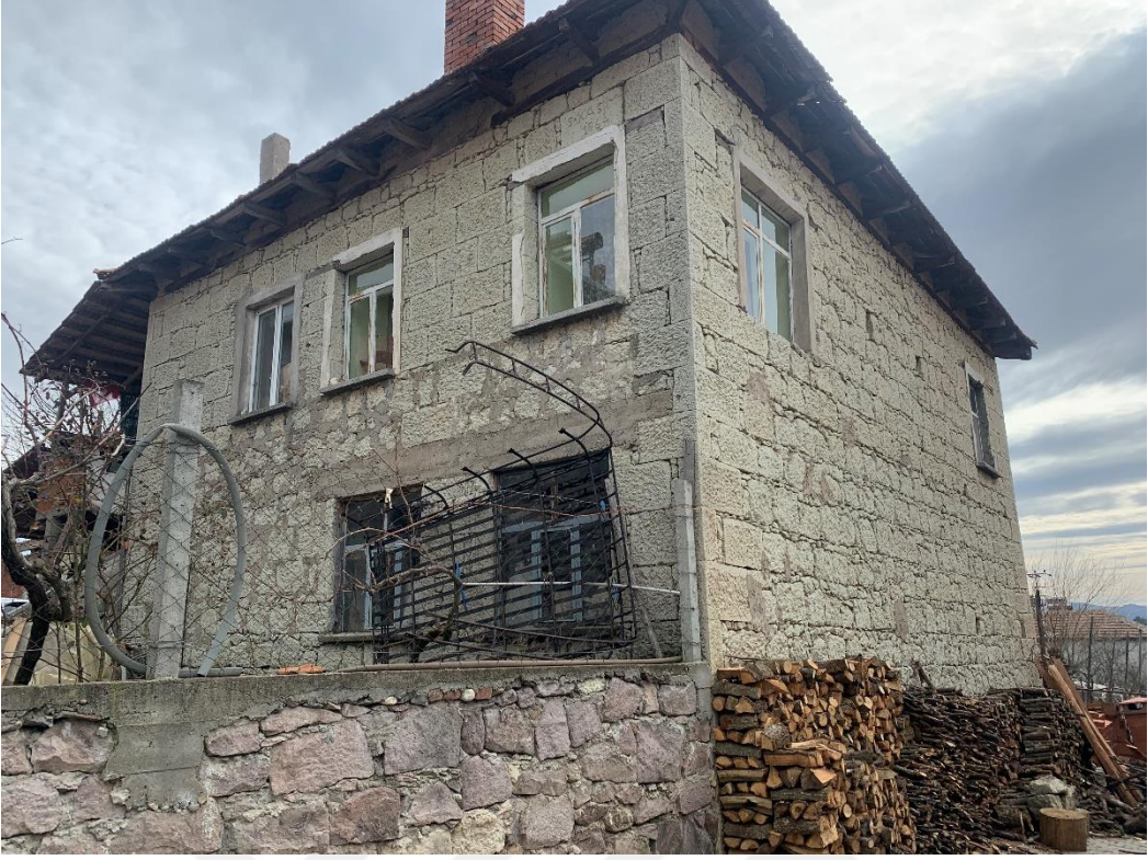
Şekil 4.71: Sağlam yapı örneği (Kişisel Arşiv, 2023).
