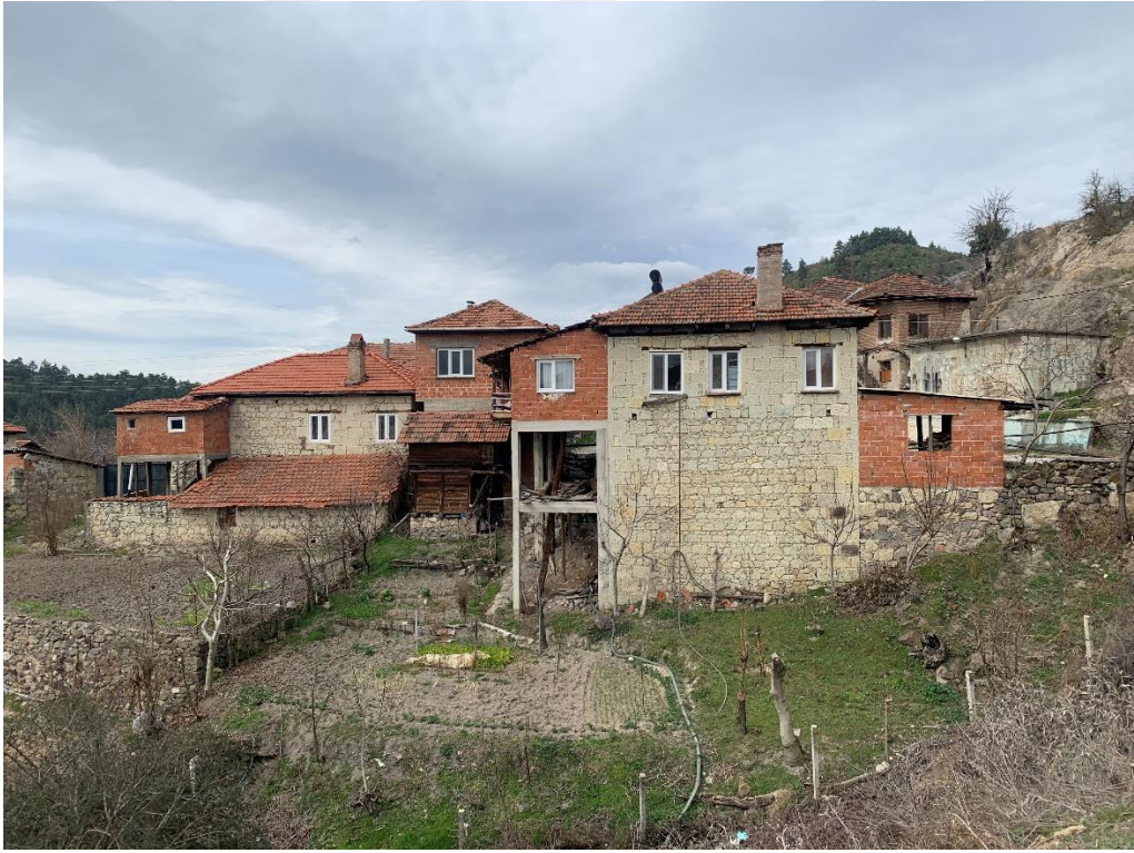
Şekil 4.59: Betonarme strüktür üzerinde sonradan eklenen hacim örnekleri (Kişisel Arşiv, 2024).
