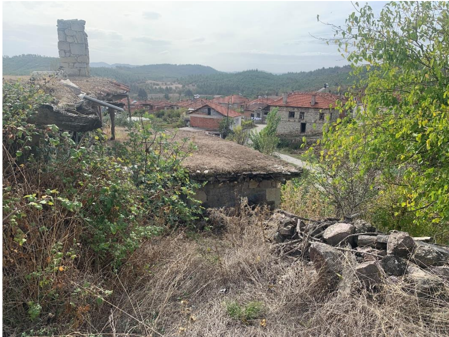
Şekil 4.56: 133 ada 2-3 parselde kayıtlı Mehmet Deniz evi, özgünlüğünü koruyan toprak çatı (Kişisel Arşiv, 2023).
