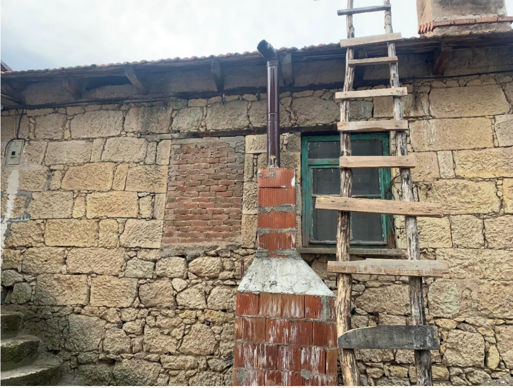
Şekil 4.47: Kapatılan pencere örnekleri (Kişisel Arşiv, 2024).
