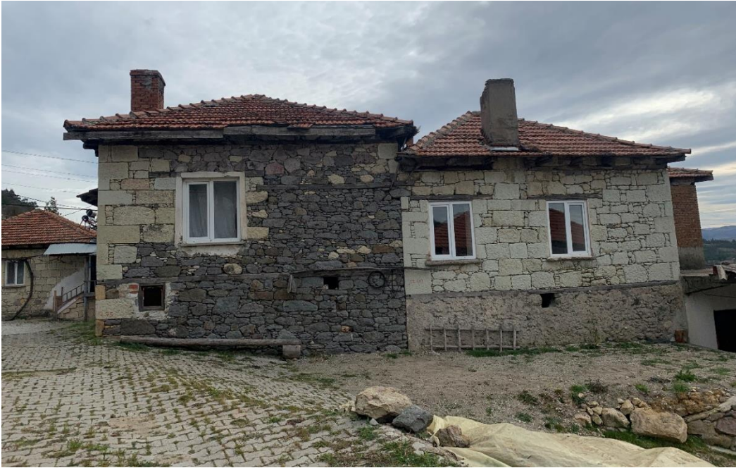
Şekil 4.48: Özgün ahşap doğramanın pvc doğrama ile değiştirildiği konut örneği (Kişisel Arşiv, 2024).
