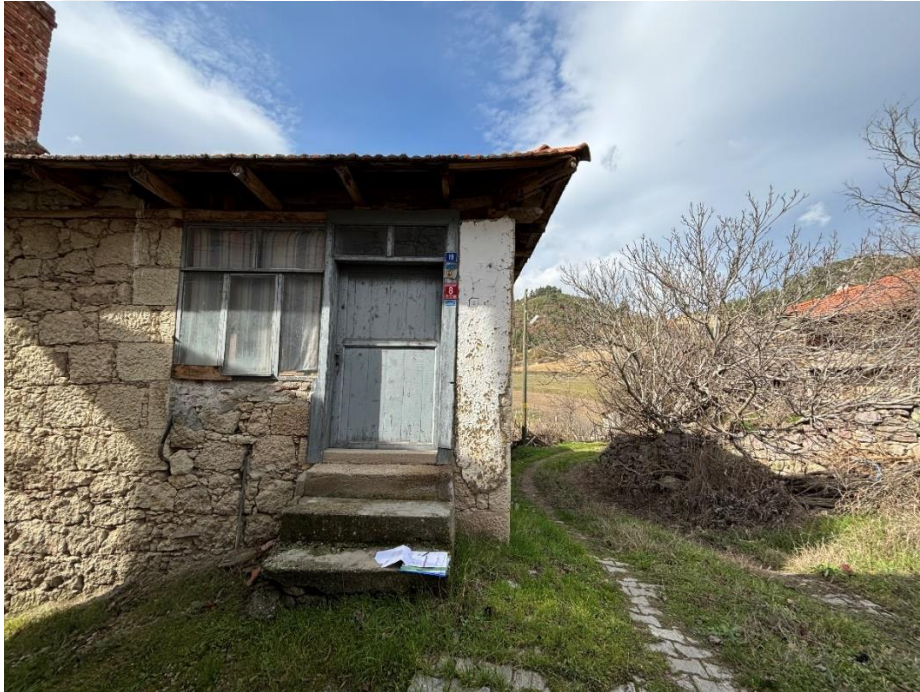
Şekil 4.41: 117 ada 3 parselde kayıtlı Mehmet Ay evi, özgünlüğü korunmuş tek kanatlı ahşap giriş kapısı örneği (Kişisel Arşiv, 2024).
