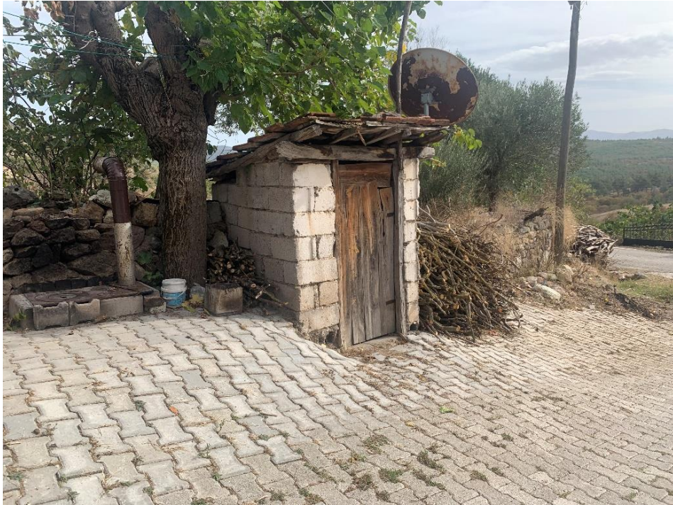
Şekil 4.39: 128 ada 3 parselde kayıtlı konut dışında çözülmüş tuvalet (Kişisel Arşiv, 2023).
