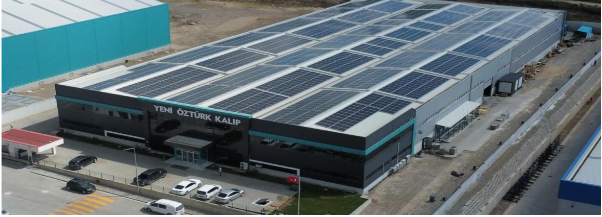
Şekil 2.2: Saha çalışması yapılan endüstriyel tesisin görünümü.
