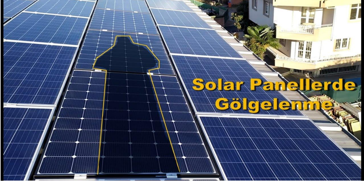
Şekil 1.8: Gölgelemeye bağlı verim değişimi.
