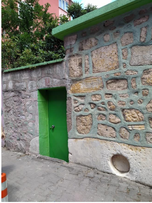
Fotoğraf 19: Töm Dede Türbesi ve Duvarında Bulunan Delik
