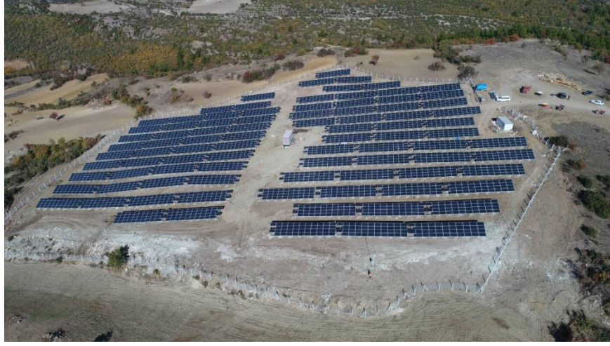
Şekil 3.13: Bigadiç İlçesi Okçular mahallesinde yer alan GES.
