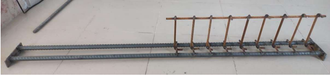
Şekil 2.4: I enkesitli kiriş için imalatı tamamlanmış donatı düzeni.
