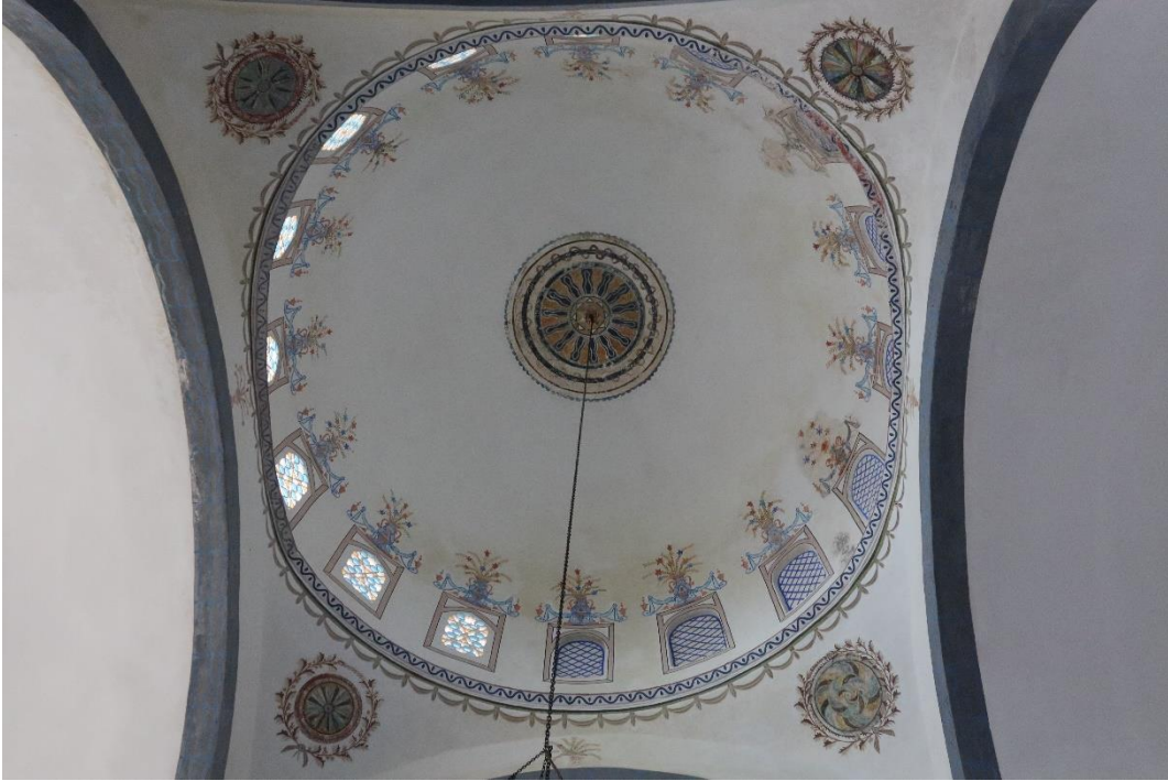
Şekil 6.2: Gazi Süleyman Paşa Camii'nin kubbesi (Kişisel arşiv).
