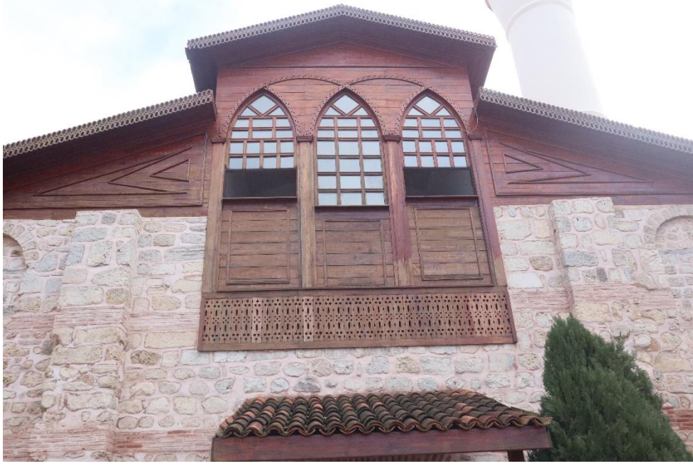
Şekil 6.6: Gazi Süleyman Paşa Camii'nde batı tarafındaki galerinin üzerini örten ahşap konstrüksiyon (Kişisel arşiv).
