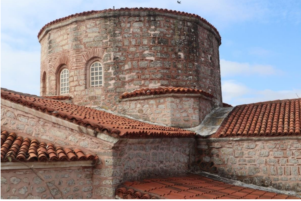
Şekil 6.1: Gazi Süleyman Paşa Camii'nin kubbe kasmağı (Kişisel arşiv).
