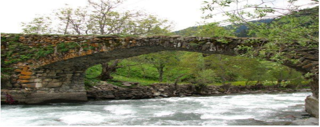
Şekil 21. Meydancık Kemer Köprüsü
