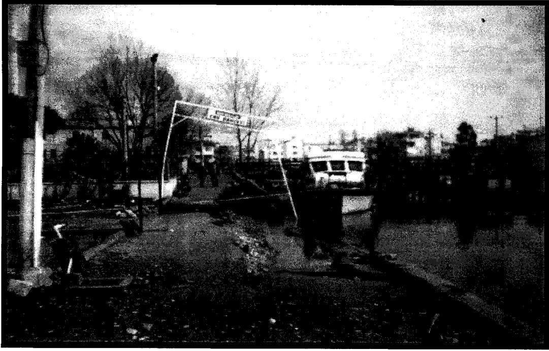
Şekil 4.12 Zeytinli Deresi Taşkın Sonrası Görünümü (Aralık 2001)
