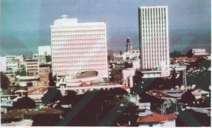
Şekil 2.1 Banco Central De Nicaragua ve Banco De America Binaları
