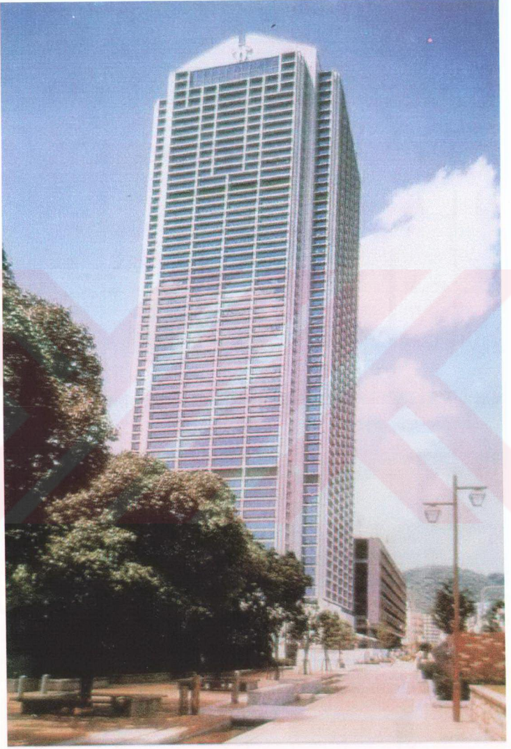
Şekil 1.1 Kobe Belediye Binası ( 17 Ocak 1995 Kobe Depremi, M=7.2 )
