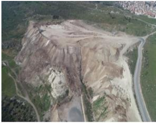
Altieylül Hafriyat Toprağı Döküm Sahası
