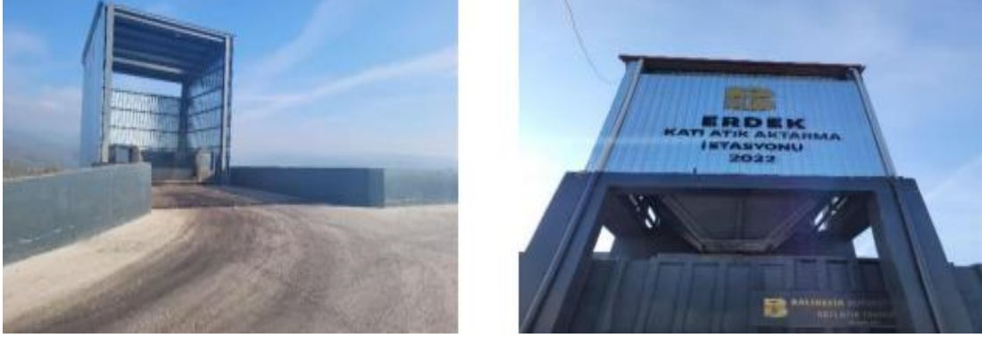
Sekil 15. Erdek Katı Atık İstasyonu
