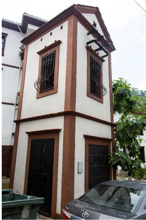
Şekil 4.10: Tarihi Trafo Yapısı
