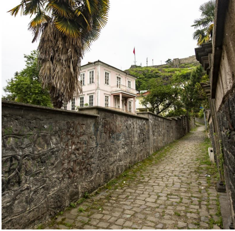
Şekil 5.2: Dik sokak bahçe duvarları
