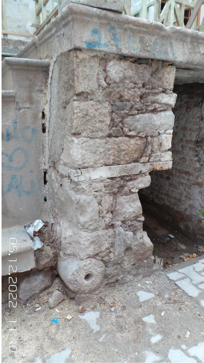
Şekil 4.17: 8490/4 ada/parselde restorasyon halindeki yapıdan devşirme ve moloz taş örnekleri.
