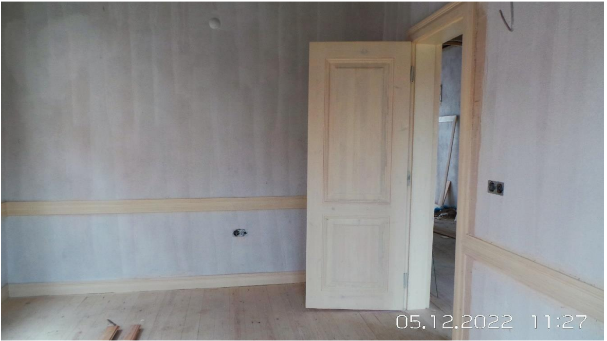
Şekil 4.49: Çalışma alanındaki restorasyon halindeki yapılardan ahşap kapı, ahşap süpürgelik, ahşap sandalyelik ve ahşap döşeme kaplamasına dair bir fotoğraf.
