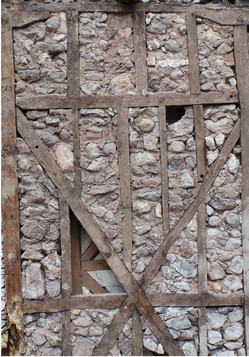
Şekil 4.18: 8490/4 ada/parselde restorasyon halindeki yapıdan taş dolgu ve toprak harç örnekleri.
