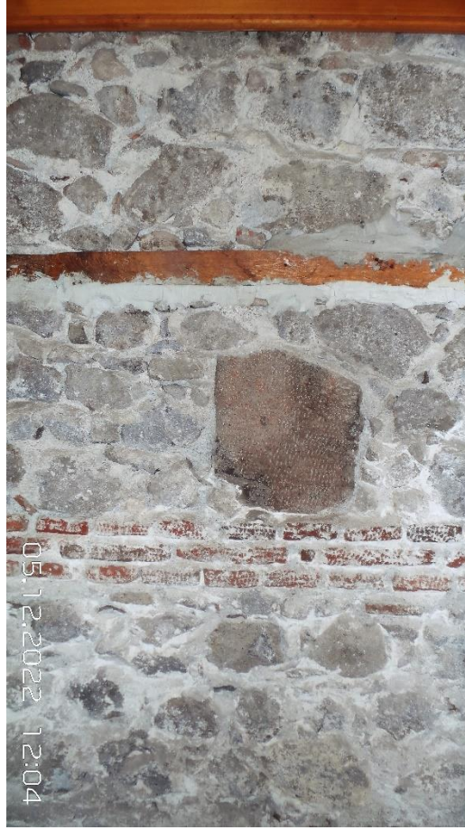
Şekil 4.42: 8458/11 Ada/parseldeki konutun bodrum katından temel duvarlarında kullanılan yapı malzemeleri karması fotoğrafı.
