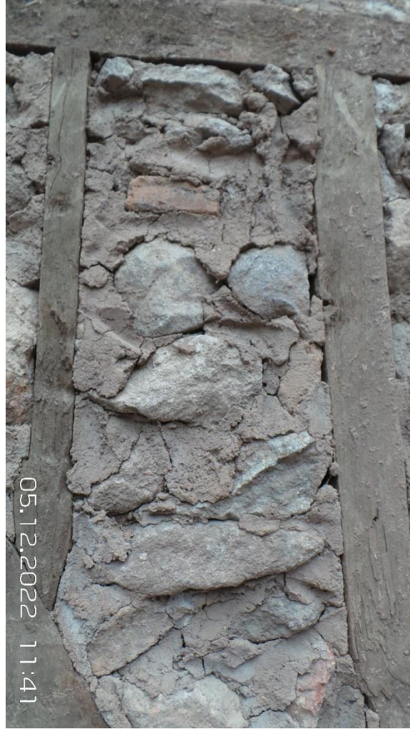
Şekil 4.43: 8490/4 Ada/parselde restorasyon halindeki yapıdan toprak harç örnekleri.
