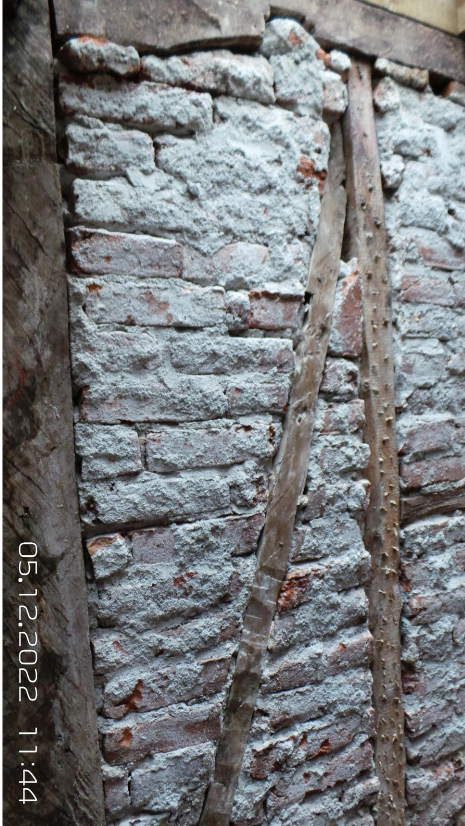
Şekil 4.19: 8490/4 ada/parselde restorasyon halindeki yapıdan tuğla dolgu örnekleri.
