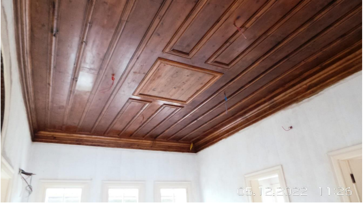
Şekil 4.48: Çalışma alanındaki restorasyon halindeki yapılardan ahşap tavan işlemlerine ait bir fotoğraf.
