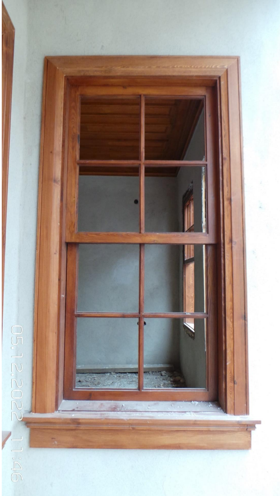
Şekil 4.47: Çalışma alanındaki restorasyon halindeki yapılardan ahşap giyotin pencere tipine örnek bir fotoğraf.
