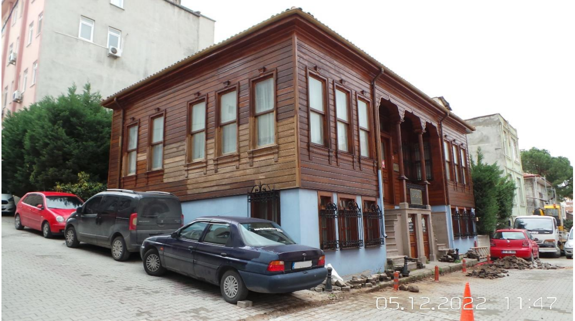
Şekil 4.36: 8485/7 Ada-parseldeki konutun ahşap cephe kaplamaları.
