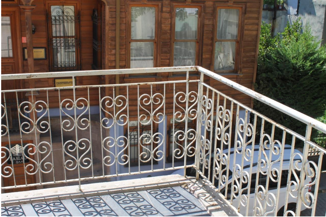
Şekil 6.220: 10 numaralı yapı 2. kat fotoğrafı.
