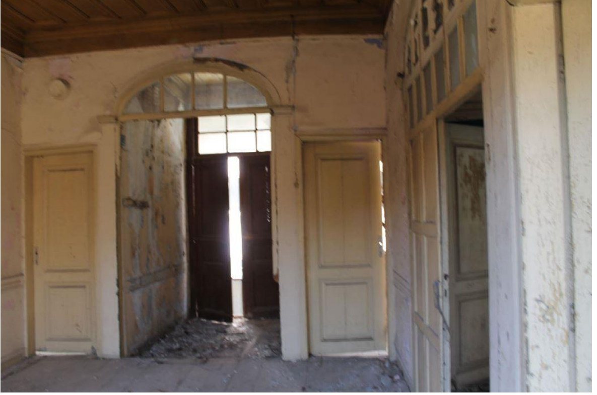
Şekil 6.101: 4 numaralı yapı 1. kat fotoğrafı.
