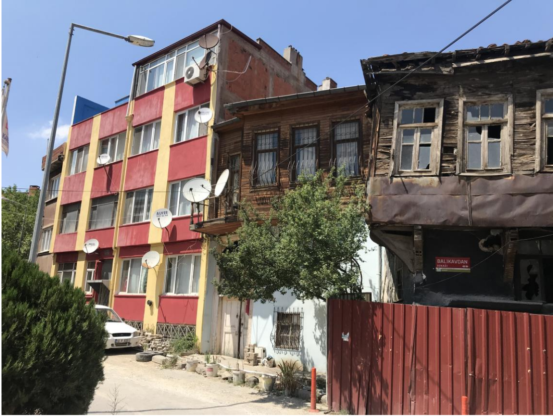
Şekil 4.32: 26 numaralı tescilli yapı-8672 ada 39 parsel-dış görünüş.
