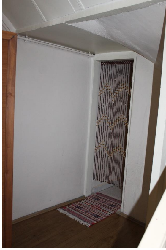
Şekil 6.175: 8 numaralı yapı bodrum kat fotoğraf.
