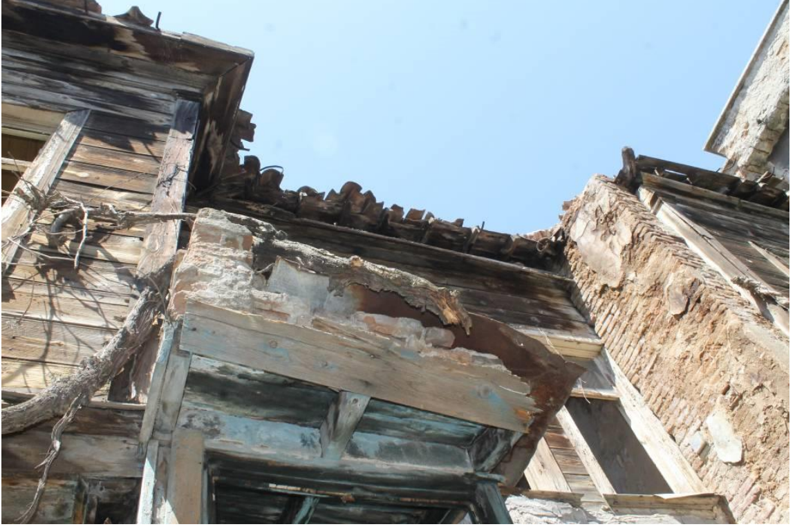
Şekil 6.94: 4 numaralı yapı arka cephe fotoğrafı.
