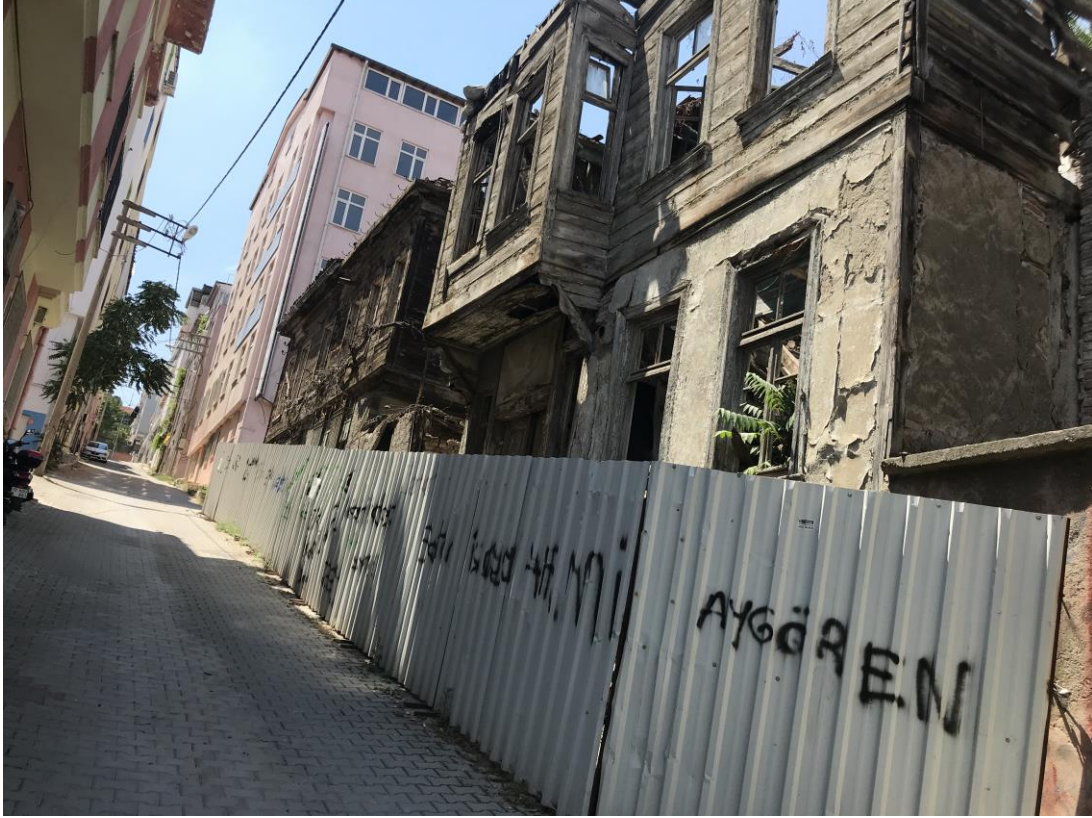
Şekil 6.135: 5 numaralı yapı ön cephe fotoğrafı.
