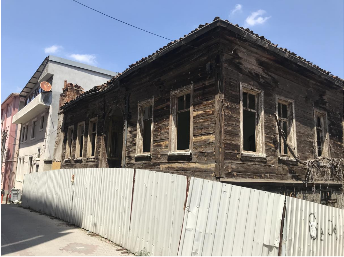
Şekil 6.89: 4 numaralı yapı ön cephe fotoğrafı.
