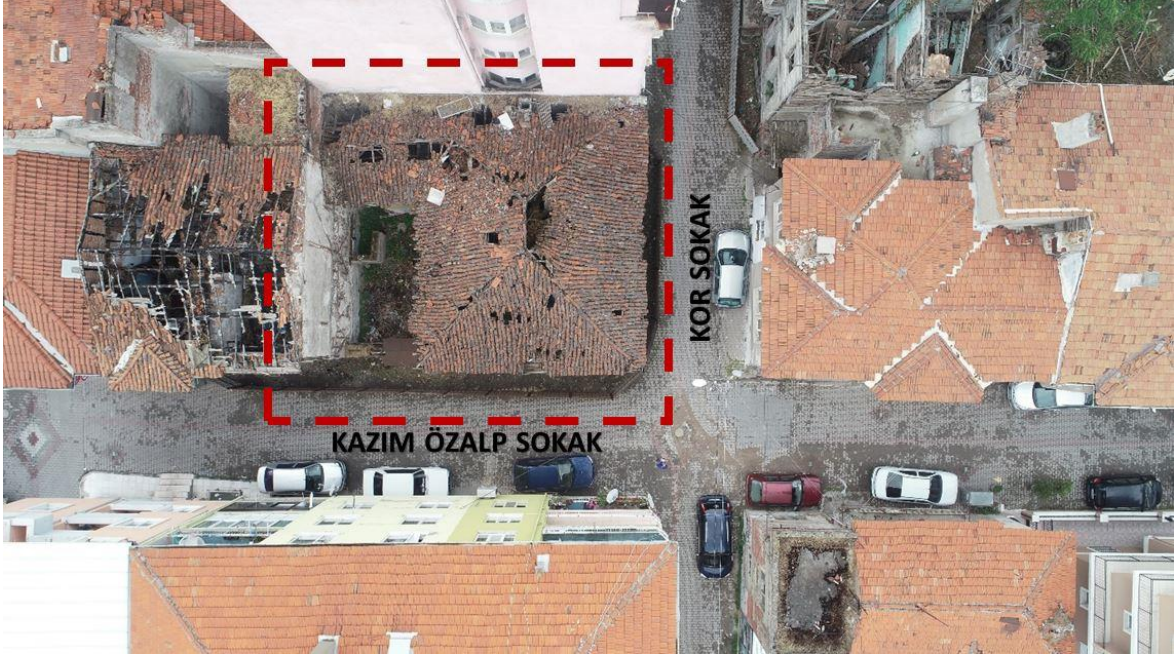
Şekil 6.33: Yapının drone fotoğrafı.
