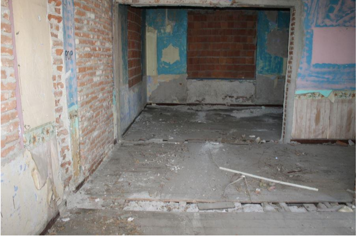
Şekil 6.286: 14 numaralı yapı 1. kat fotoğrafı.
