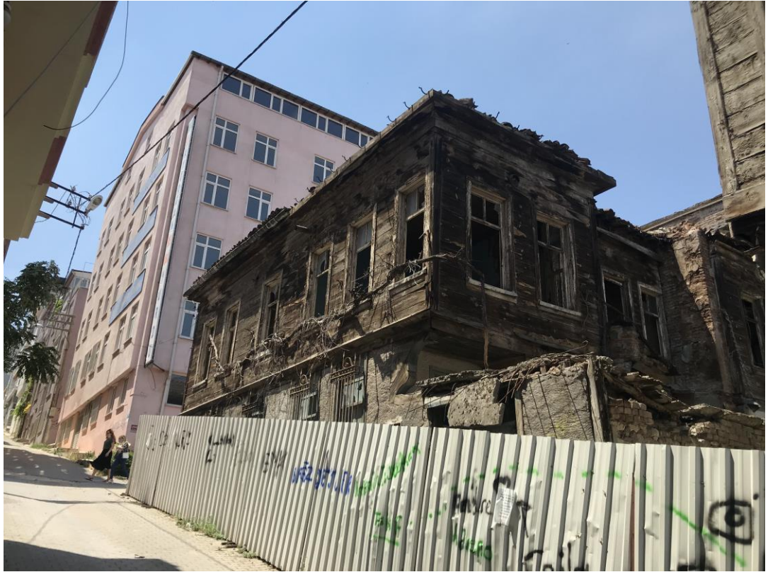
Şekil 6.91: 4 numaralı yapı sağ yan ve arka cephe fotoğrafı.
