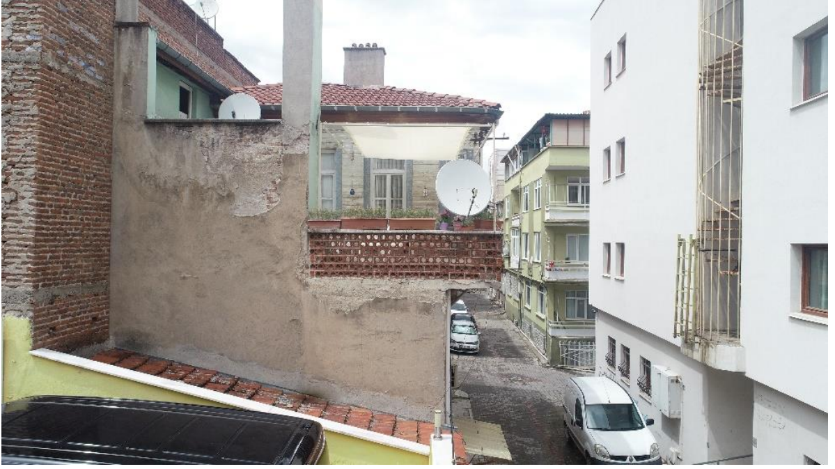
Şekil 6.173: 8 numaralı yapı arka cephe fotoğrafı.
