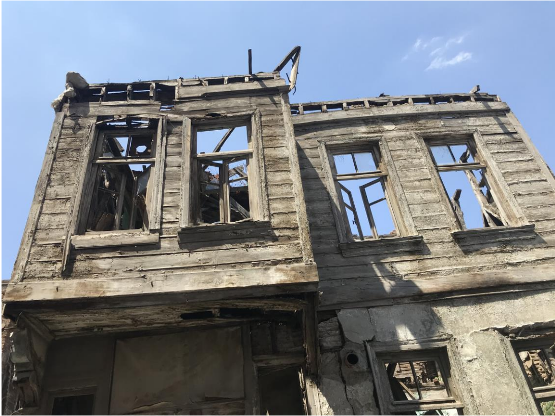
Şekil 6.136: 5 numaralı yapı ön cephe üst kat fotoğrafı.
