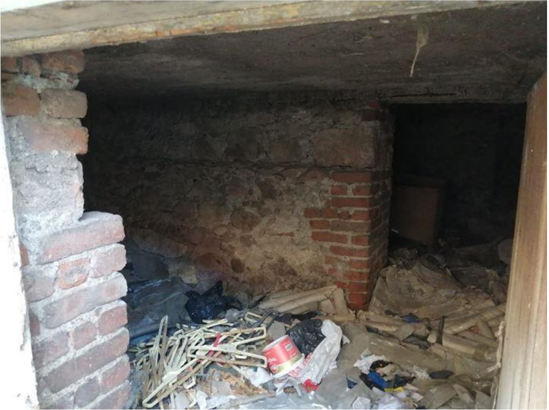
Şekil 6.322: 17 numaralı yapı bodrum kat fotoğrafı.
