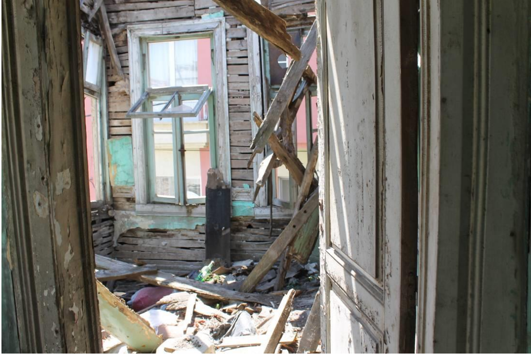
Şekil 6.143: 5 numaralı yapı 1. kat fotoğrafı.
