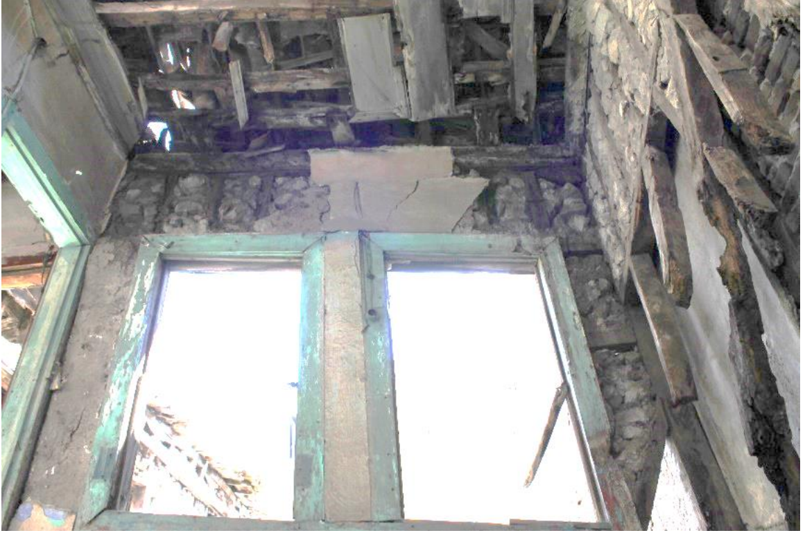
Şekil 6.58: 3 numaralı yapı 1. kat fotoğraf.
