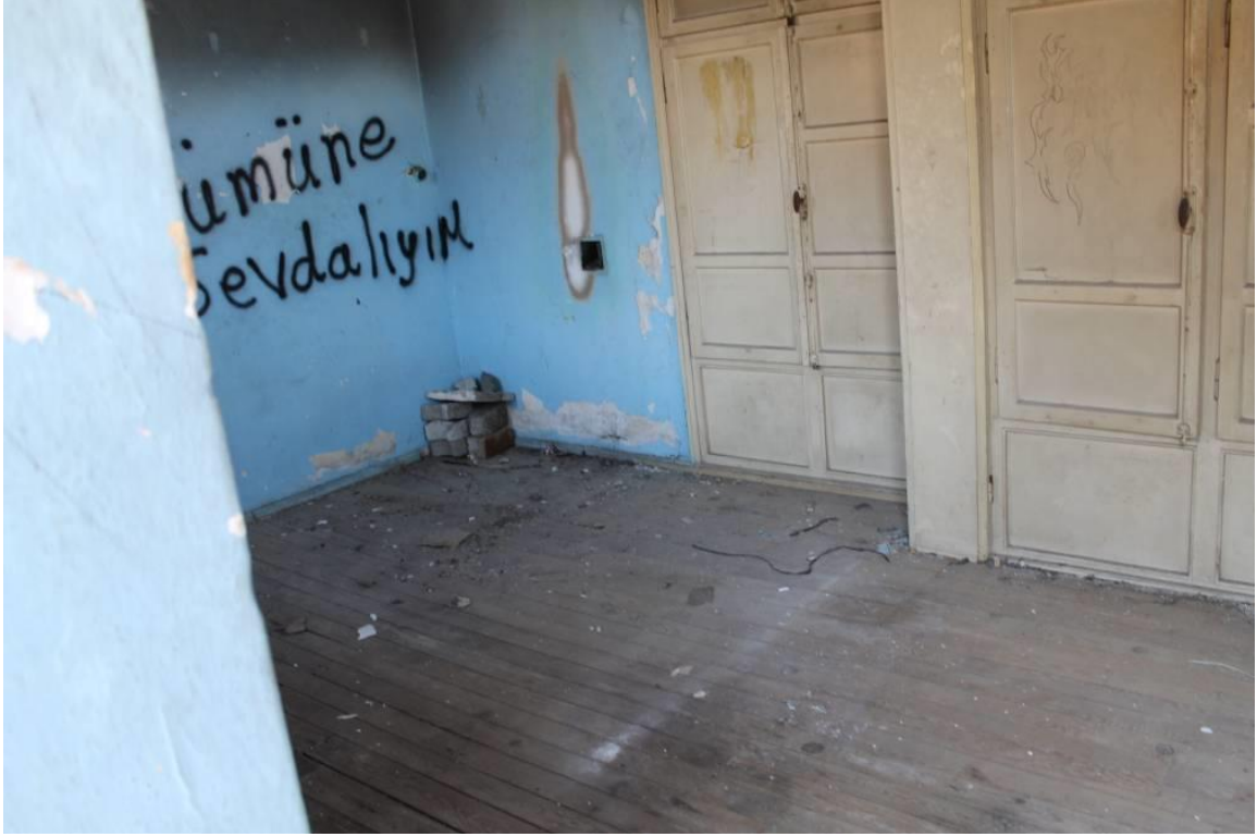
Şekil 6.97: 4 numaralı yapı zemin kat fotoğraf.
