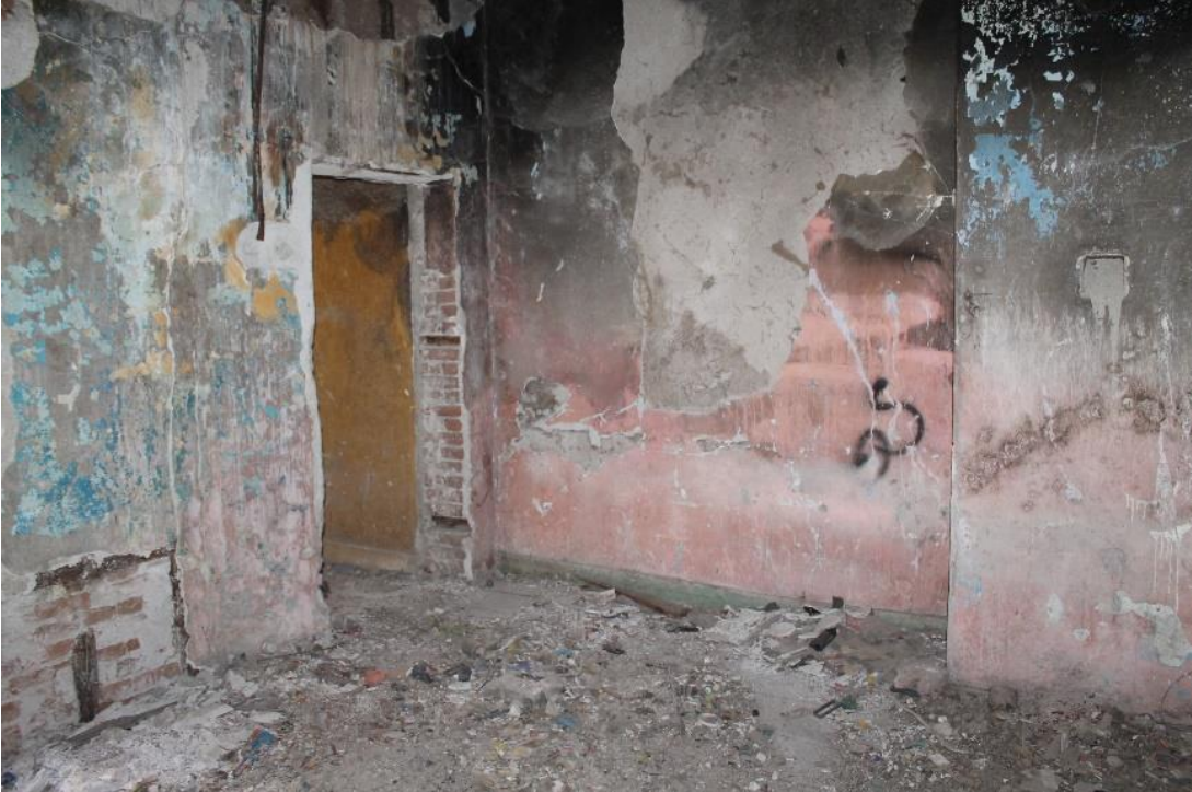
Şekil 6.20: 2 numaralı yapı zemin kat fotoğrafı.
