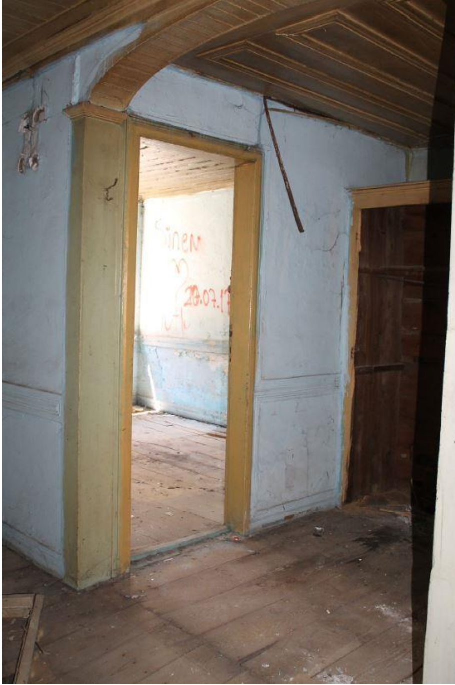
Şekil 6.100: 4 numaralı yapı zemin kat fotoğrafı.
