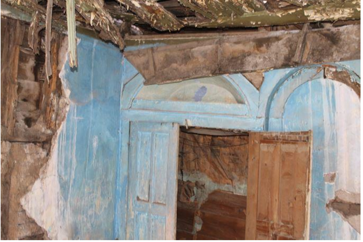
Şekil 6.417: 25 numaralı yapı 1. kat fotoğrafı.
