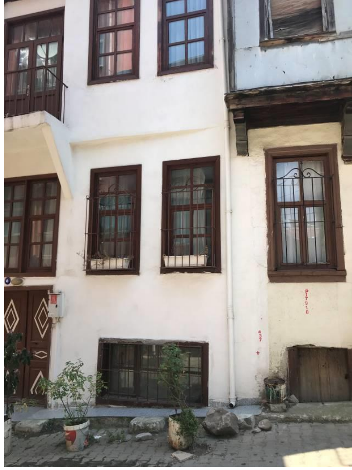
Şekil 6.358: 20 numaralı yapı ön cephe fotoğrafı.
