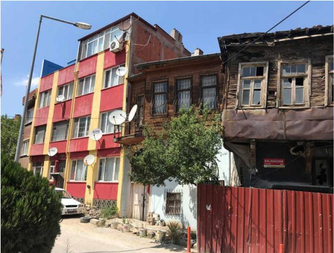
Şekil 6.412: 25 numaralı yapı ön cephe fotoğrafı.
