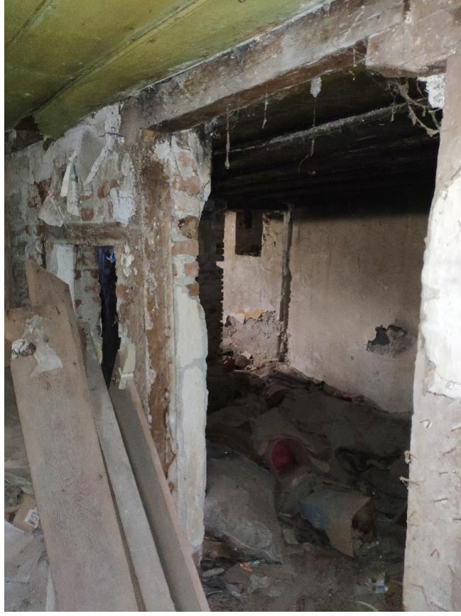
Şekil 6.17: 2 numaralı yapı bodrum kat fotoğrafı.
