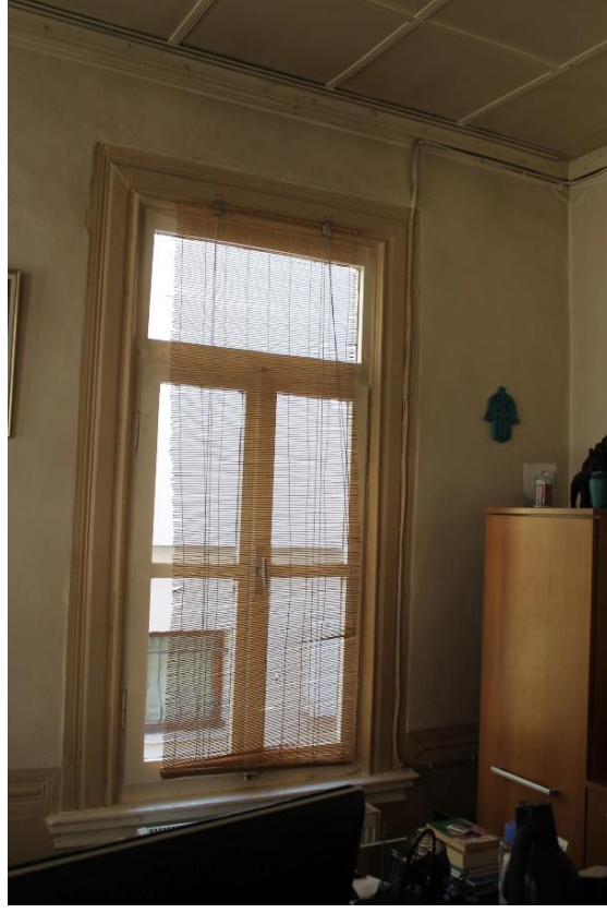
Şekil 6.177: 8 numaralı yapı zemin kat fotoğrafı.
