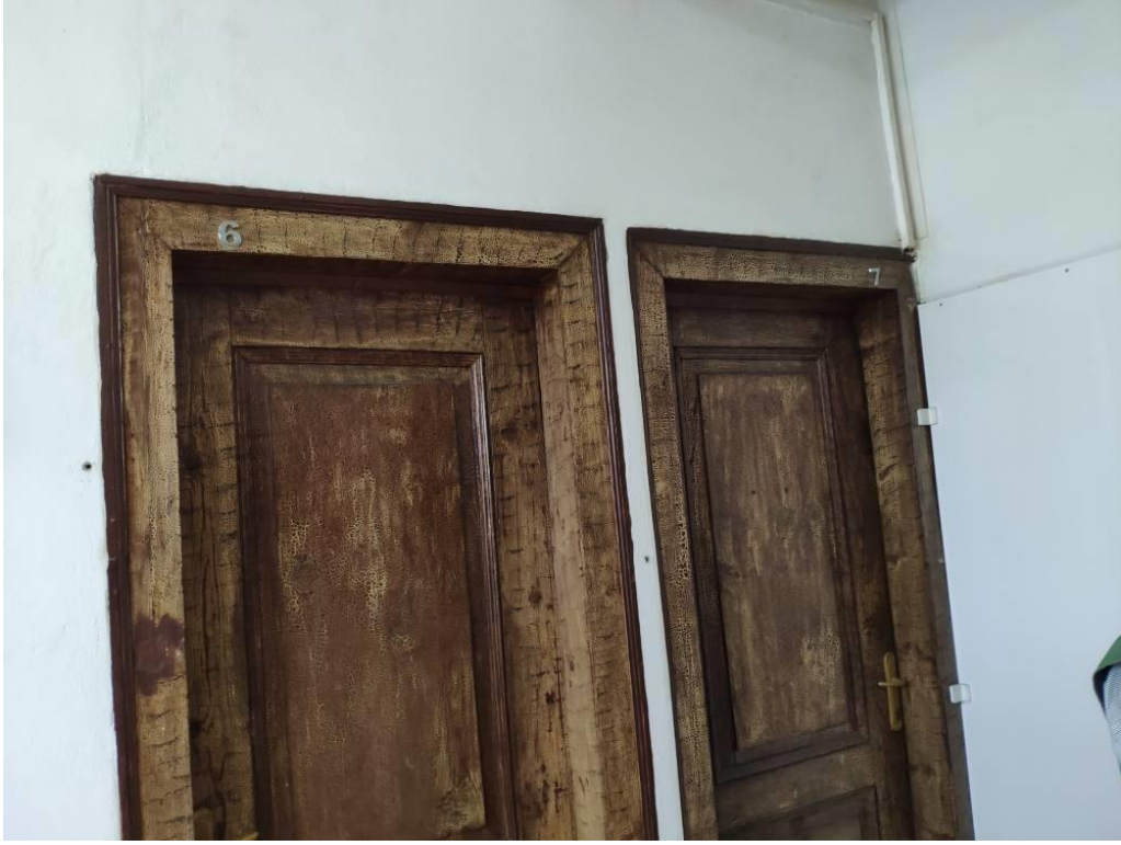
Şekil 6.366: 20 numaralı yapı 2. kat fotoğrafı.
