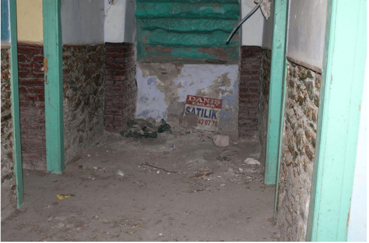
Şekil 6.280: 14 numaralı yapı bodrum kat fotoğrafı.
