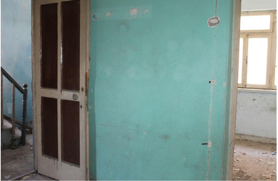
Şekil 6.324: 17 numaralı yapı zemin kat fotoğrafı.
