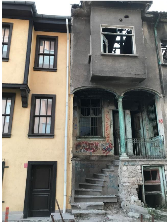
Şekil 6.14: 2 numaralı yapı ön cephe fotoğrafı.
