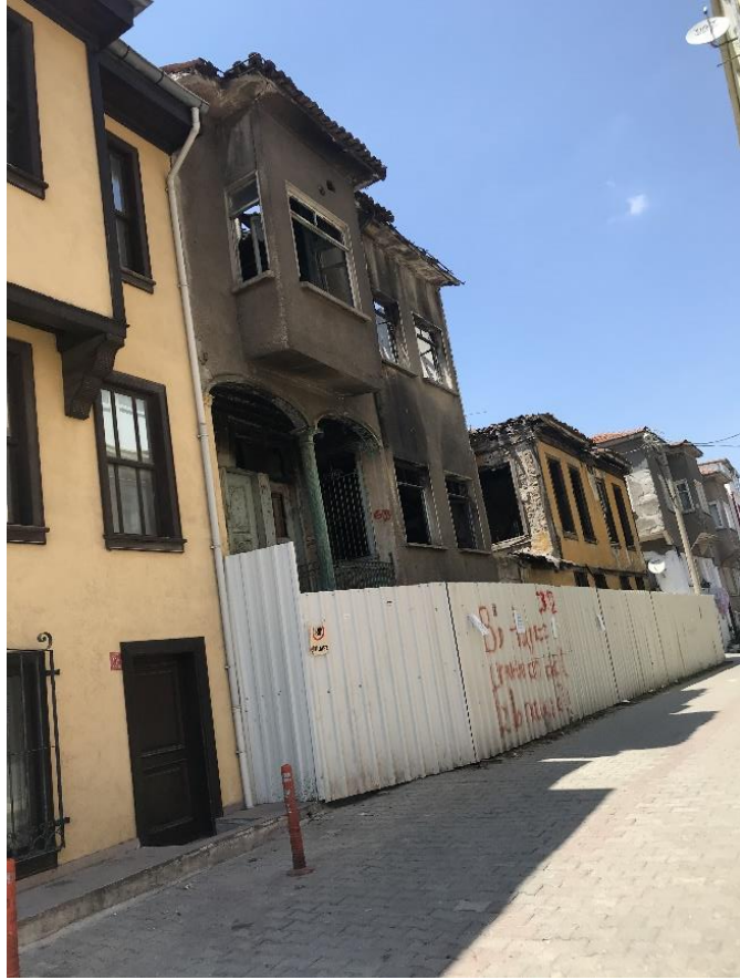
Şekil 6.13: 2 numaralı yapı ön cephe fotoğrafı.
