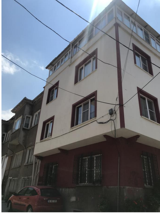
Şekil 4.35: Tescilsiz yapı örneği dış görünüş.
