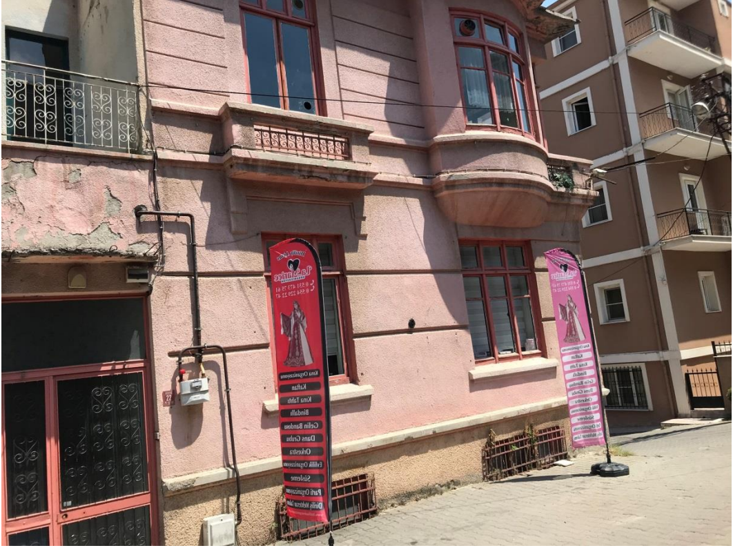
Şekil 6.211: 10 numaralı yapı ön cephe fotoğrafı.
