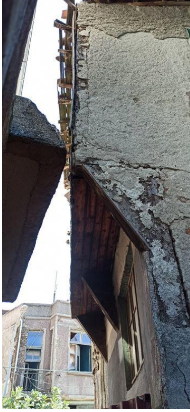
Şekil 6.413: 25 numaralı yapı arka cephe fotoğrafı.
