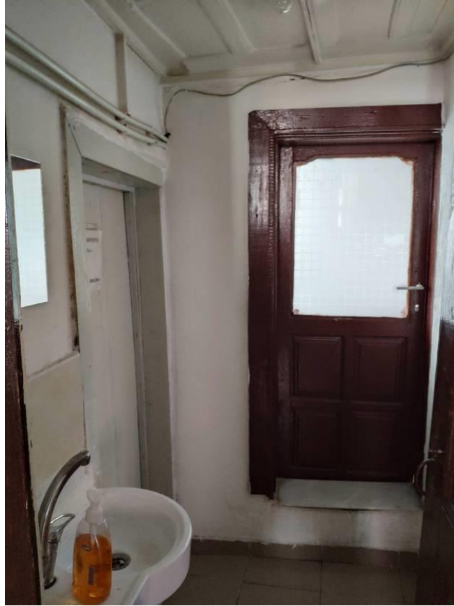
Şekil 6.365: 20 numaralı yapı 1. kat fotoğraf.
