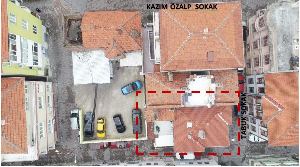
Şekil 6.159: Yapının drone fotoğrafı.
