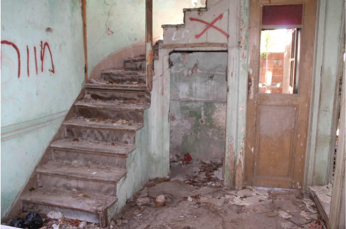
Şekil 6.140: 5 numaralı yapı zemin kat fotoğrafı.
