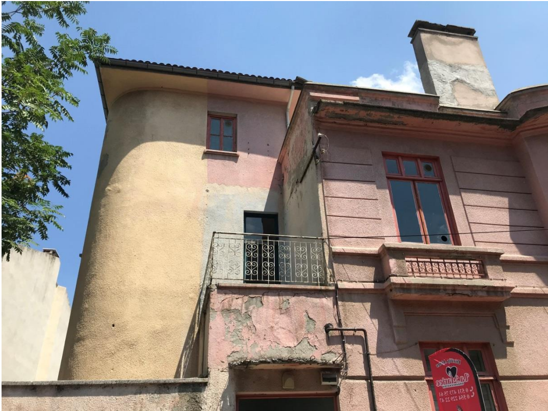
Şekil 6.212: 10 numaralı yapı ön cephe fotoğrafı.
