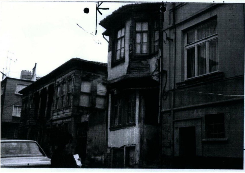
Şekil 6.241: 12 numaralı yapının arşiv fotoğrafı (Balıkesir Kültür Varlıklarını Koruma Bölge Kurulu Müdürlüğü arşivi).
