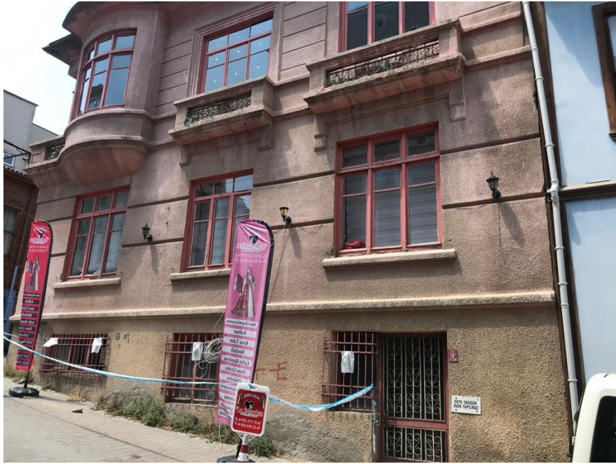
Şekil 6.210: 10 numaralı yapı sağ yan cephe fotoğrafı.
