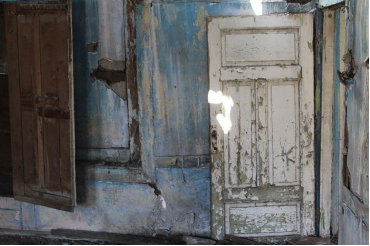
Şekil 6.418: 25 numaralı yapı 1. kat fotoğrafı.
