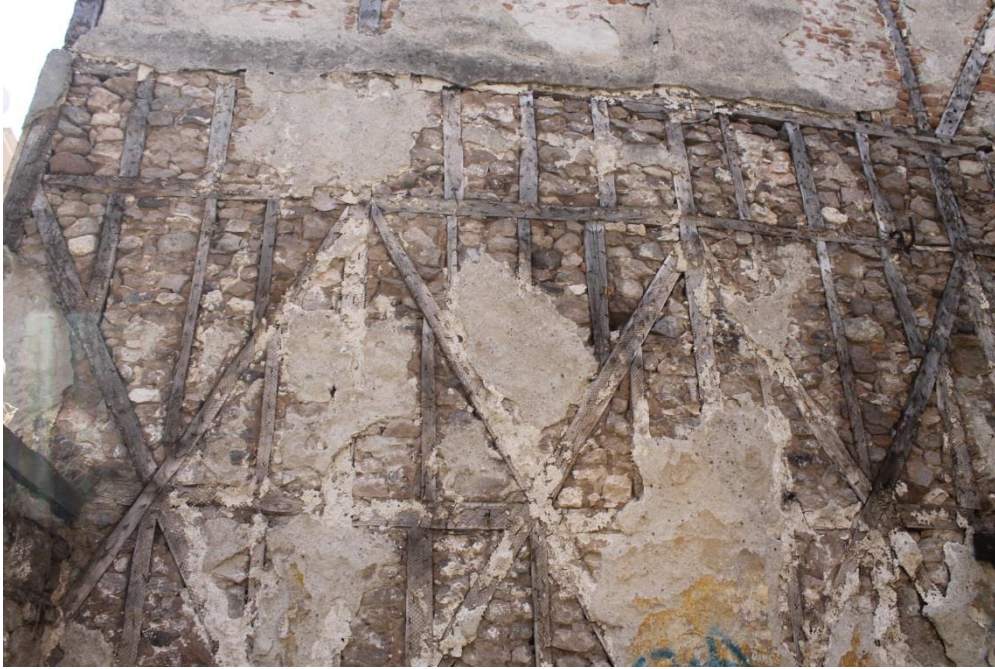
Şekil 6.16: 2 numaralı yapı arka cephe fotoğrafı.
