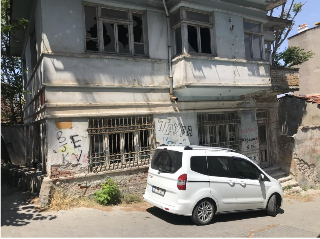
Şekil 6.317: 17 numaralı yapı ön cephe fotoğrafı.
