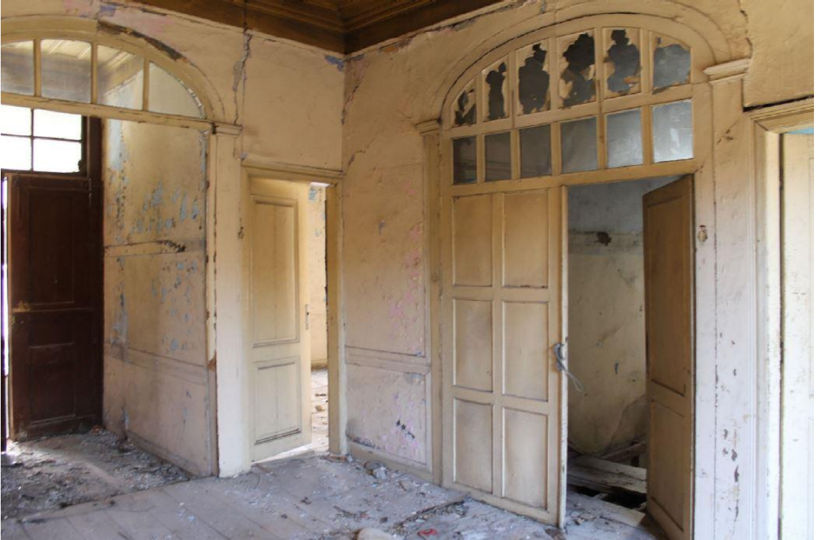
Şekil 6.102: 4 numaralı yapı 1. kat fotoğrafı.
