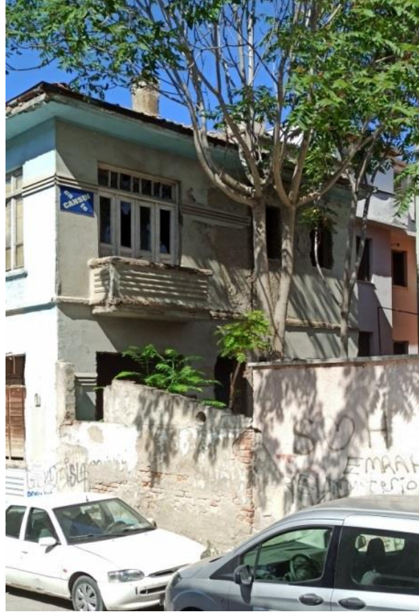
Şekil 6.278: 14 numaralı yapı sağ yan cephe fotoğrafı.
