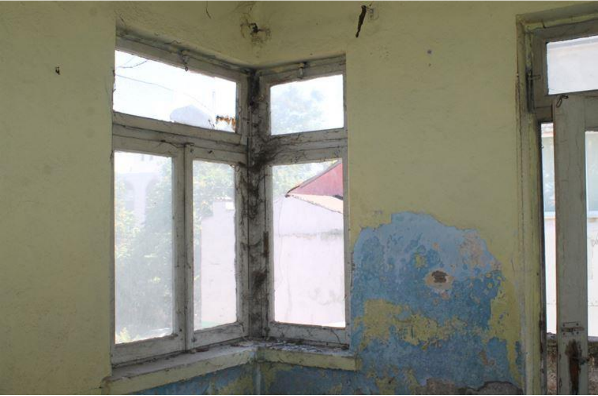
Şekil 6.326: 17 numaralı yapı 1. kat fotoğraf.
