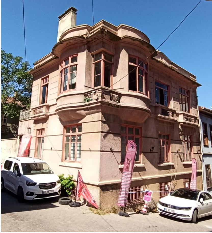
Şekil 6.209: 10 numaralı yapı ön ve sağ yan cephe fotoğrafı.
