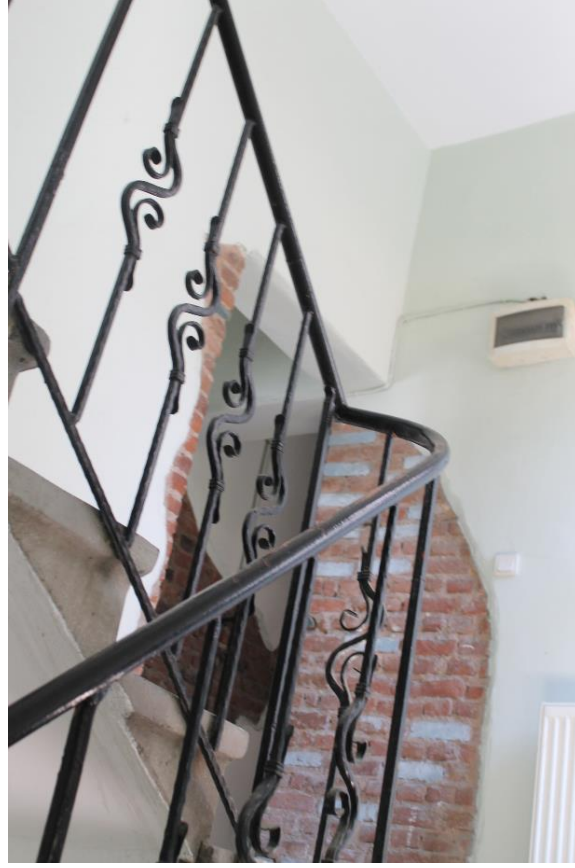
Şekil 6.219: 10 numaralı yapı 1. kat merdiven fotoğrafı.
