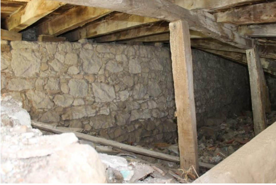
Şekil 6.139: 5 numaralı yapı bodrum kat fotoğrafı.
