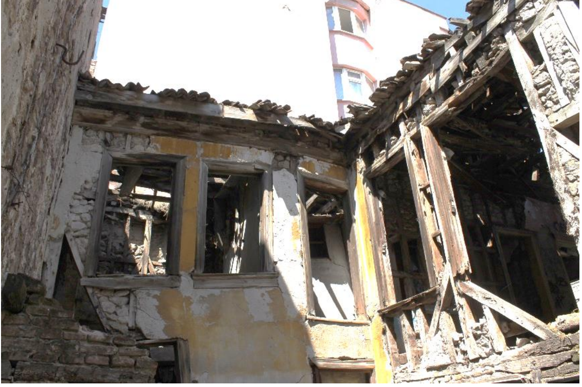
Şekil 6.53: 3 numaralı yapı avlu cephesi fotoğrafı.
