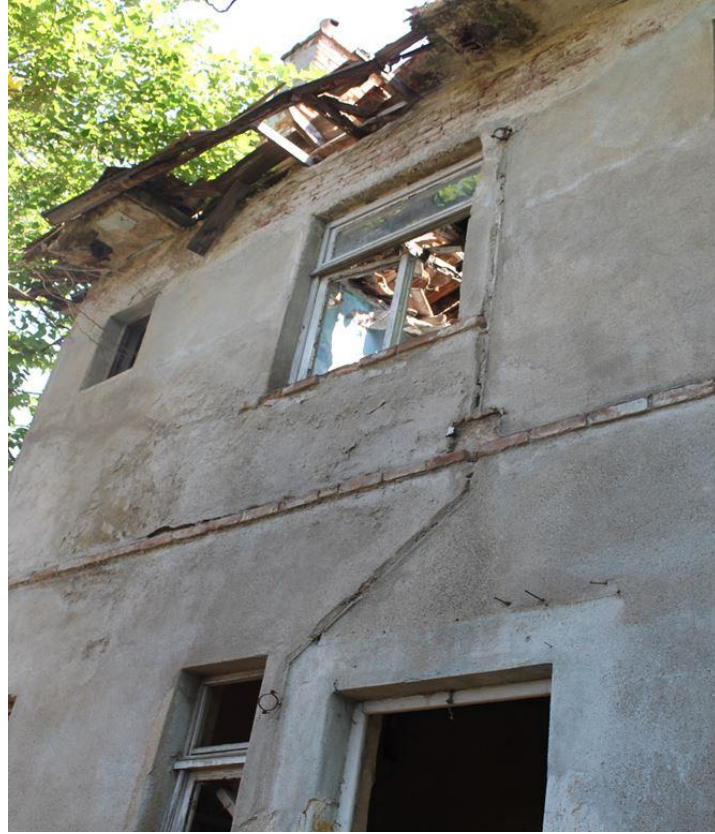
Şekil 6.320: 17 numaralı yapı arka cephe fotoğrafı.
