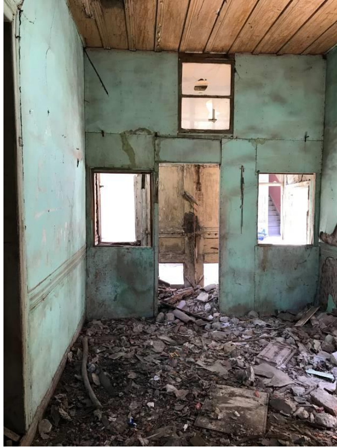
Şekil 6.141: 5 numaralı yapı zemin kat fotoğraf.
