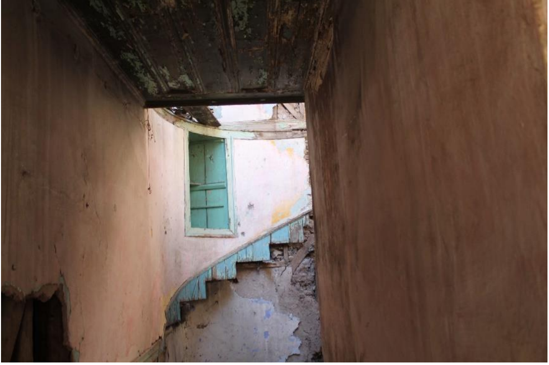
Şekil 6.19: 2 numaralı yapı zemin kat fotoğrafı.
