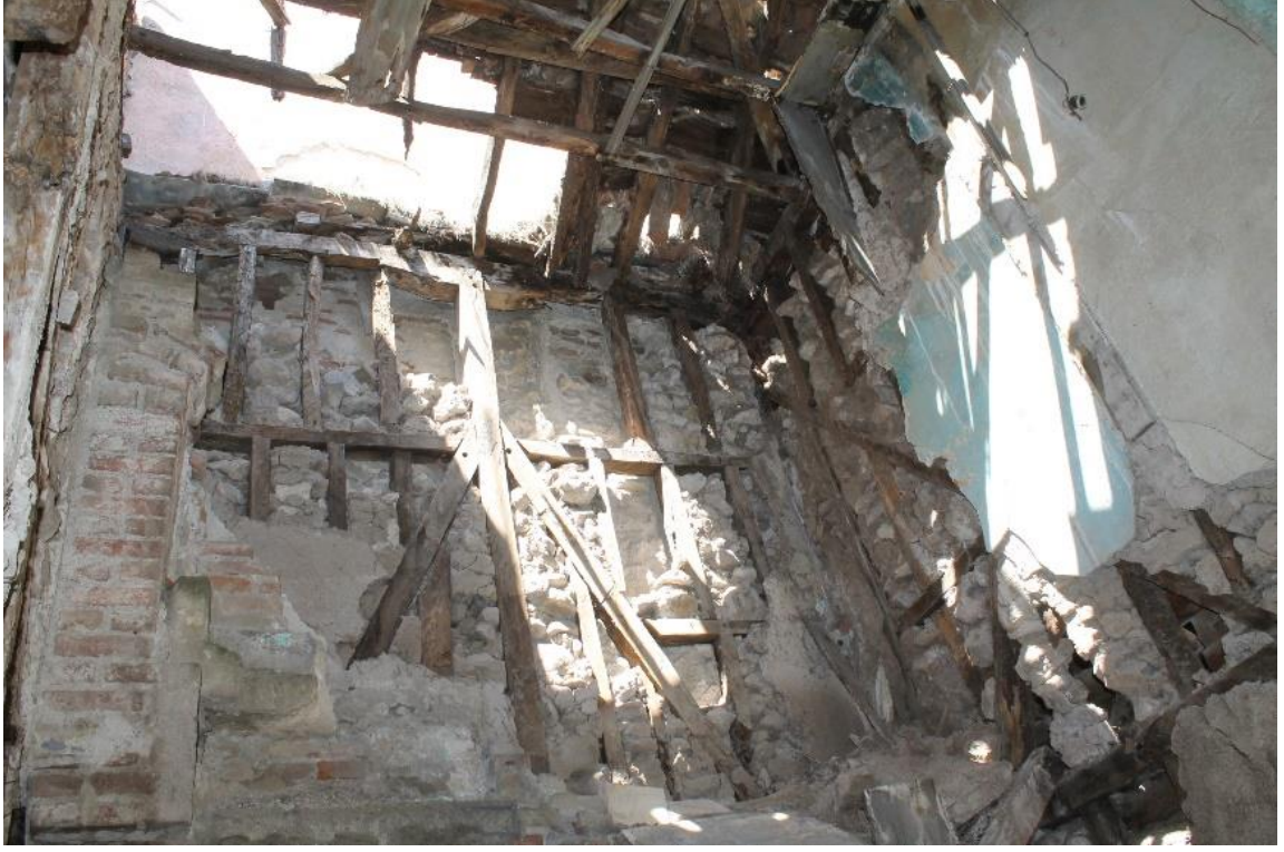
Şekil 6.59: 3 numaralı yapı 1. kat fotoğrafı.
