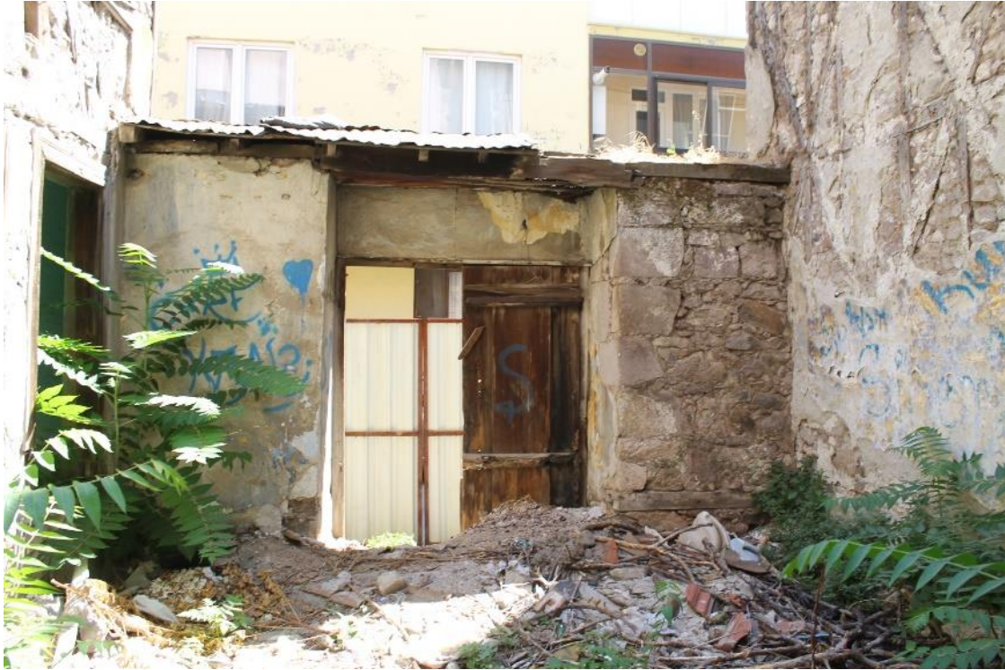
Şekil 6.52: 3 numaralı yapı avlu duvarı içten fotoğrafı.
