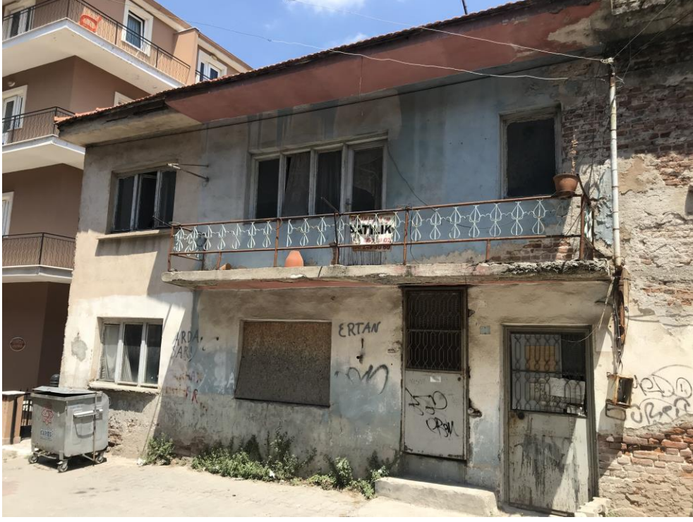
Şekil 4.34: Tescilsiz yapı örneği dış görünüş.
