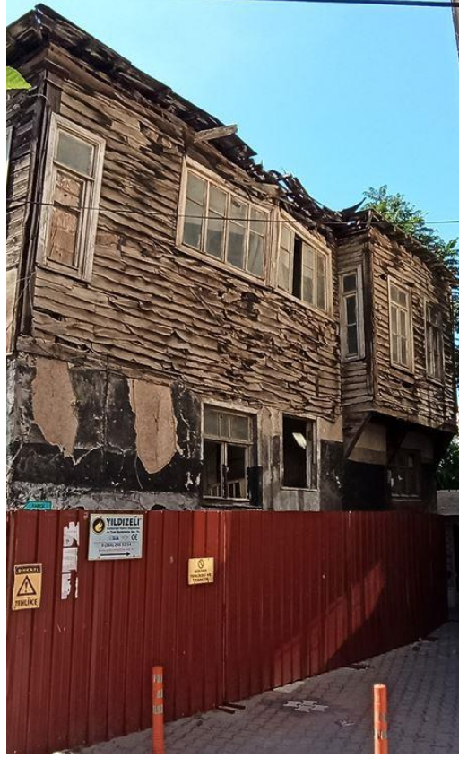
Şekil 6.411: 25 numaralı yapı sağ yan cephe fotoğrafı.
