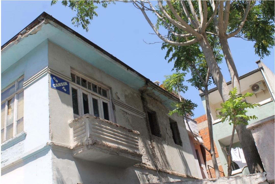
Şekil 6.279: 14 numaralı yapı sağ yan cephe fotoğrafı.
