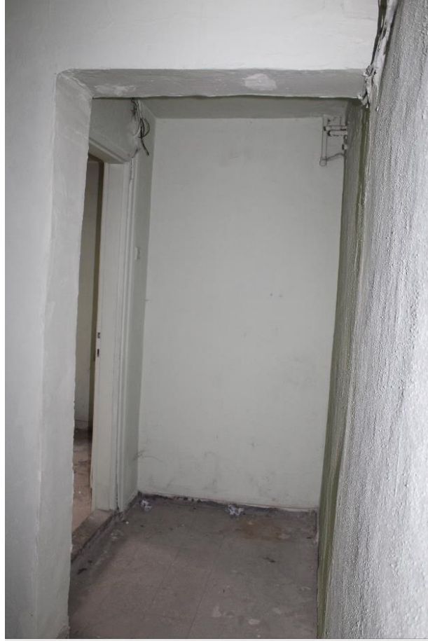
Şekil 6.214: 10 numaralı yapı bodrum kat fotoğrafı.
