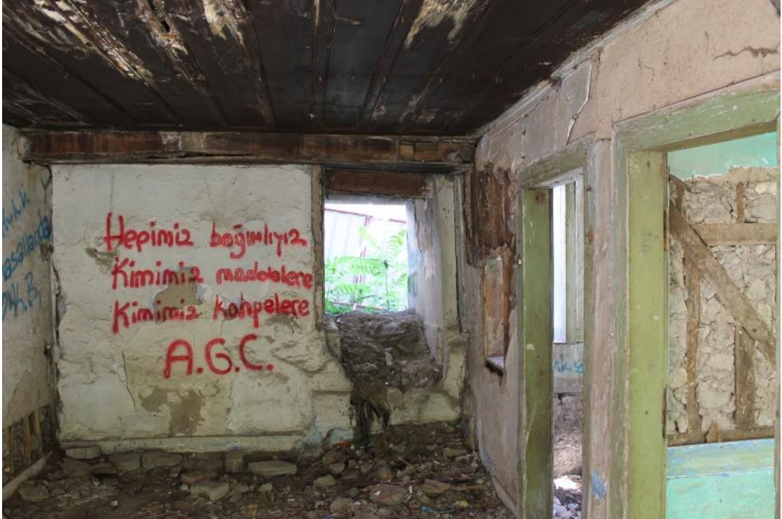
Şekil 6.54: 3 numaralı yapı zemin kat fotoğrafı.
