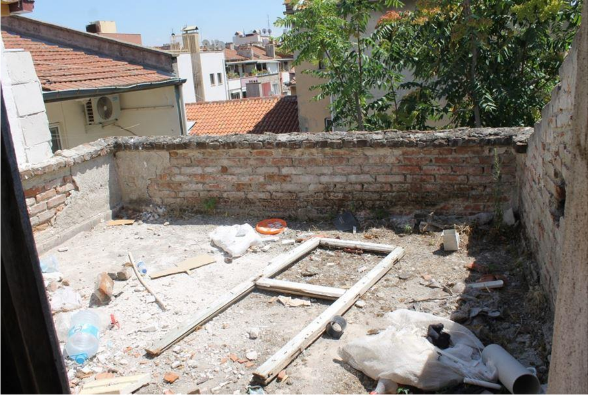
Şekil 6.289: 14 numaralı yapı teras fotoğrafı.
