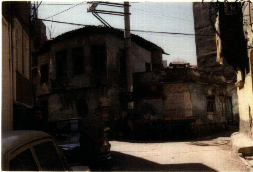
Şekil 6.385: 24 numaralı yapının arşiv fotoğrafı (Balıkesir Kültür Varlıklarını Koruma Bölge Kurulu Müdürlüğü arşivi).
