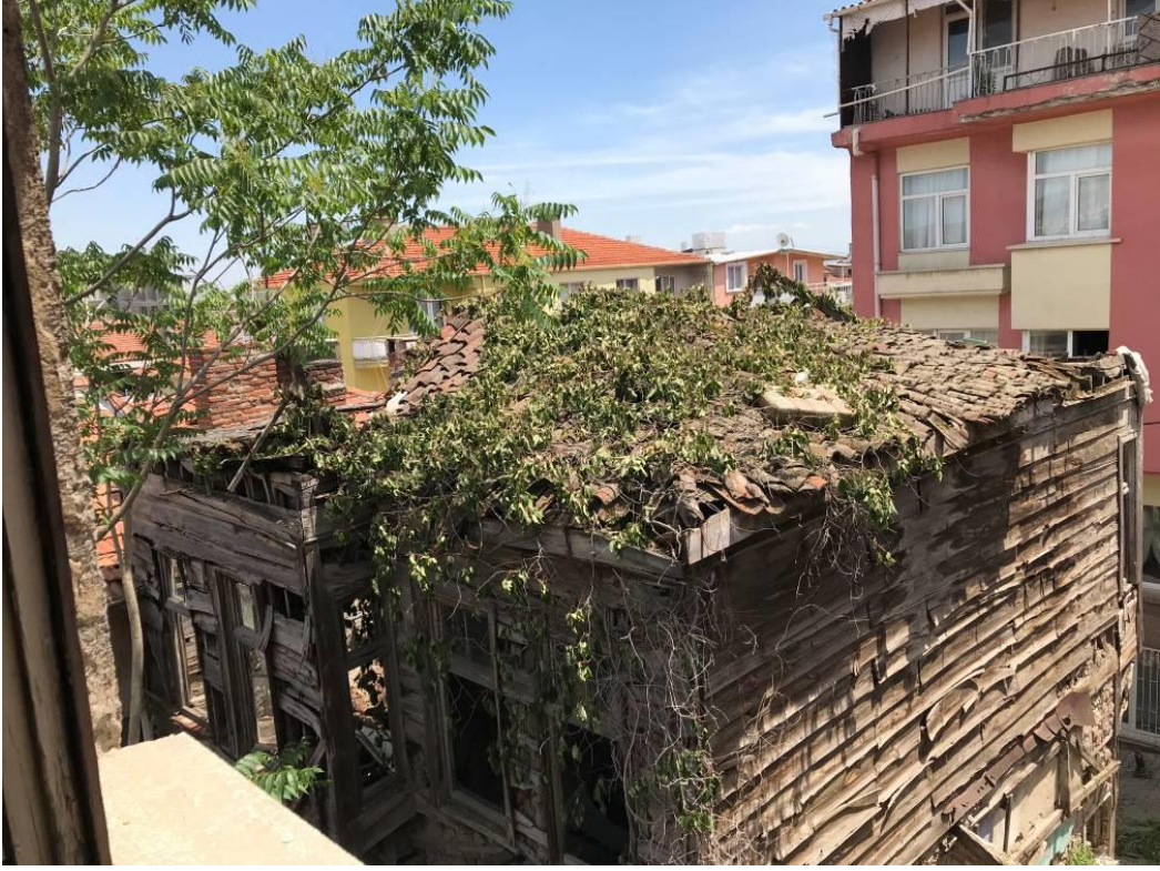
Şekil 6.137: 5 numaralı yapı sol yan ve arka cephe fotoğrafı.
