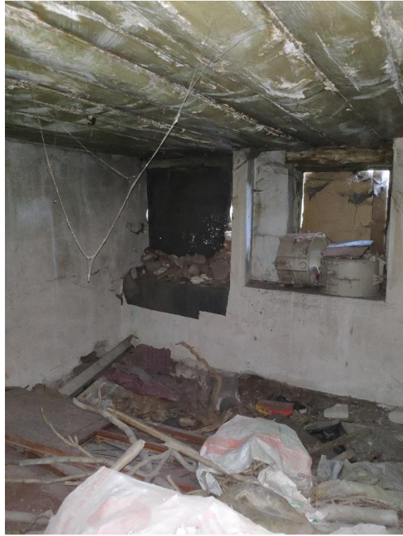
Şekil 6.18: 2 numaralı yapı zemin kat fotoğrafı.
