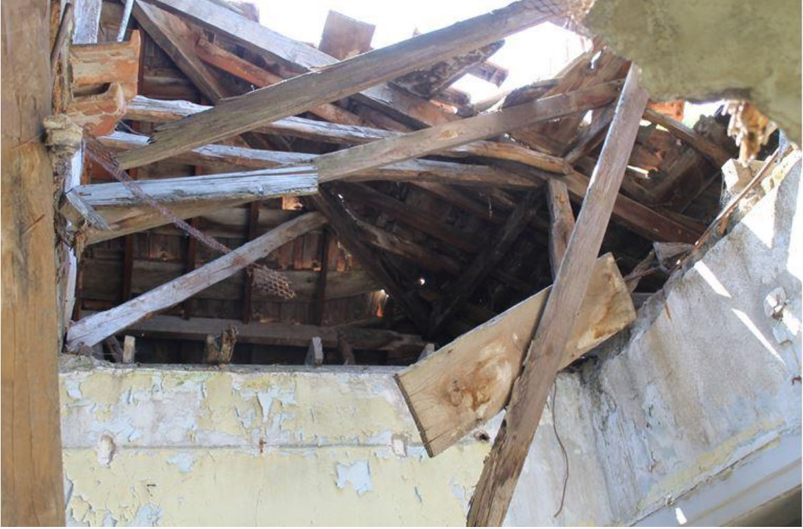
Şekil 6.327: 17 numaralı yapı 1. kat fotoğrafı.
