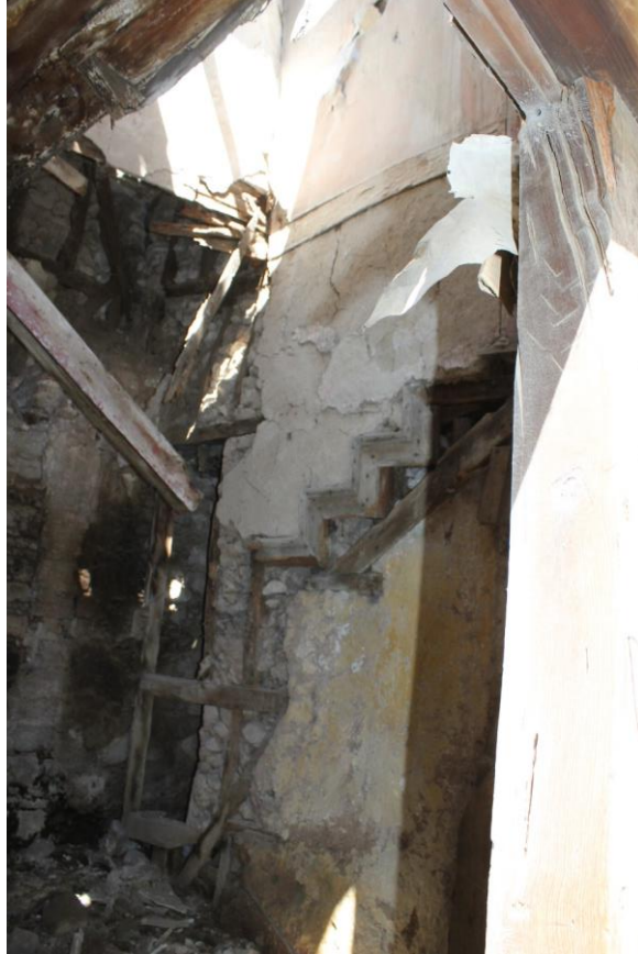
Şekil 6.56: 3 numaralı yapı zemin kat merdiven kovası fotoğrafı.
