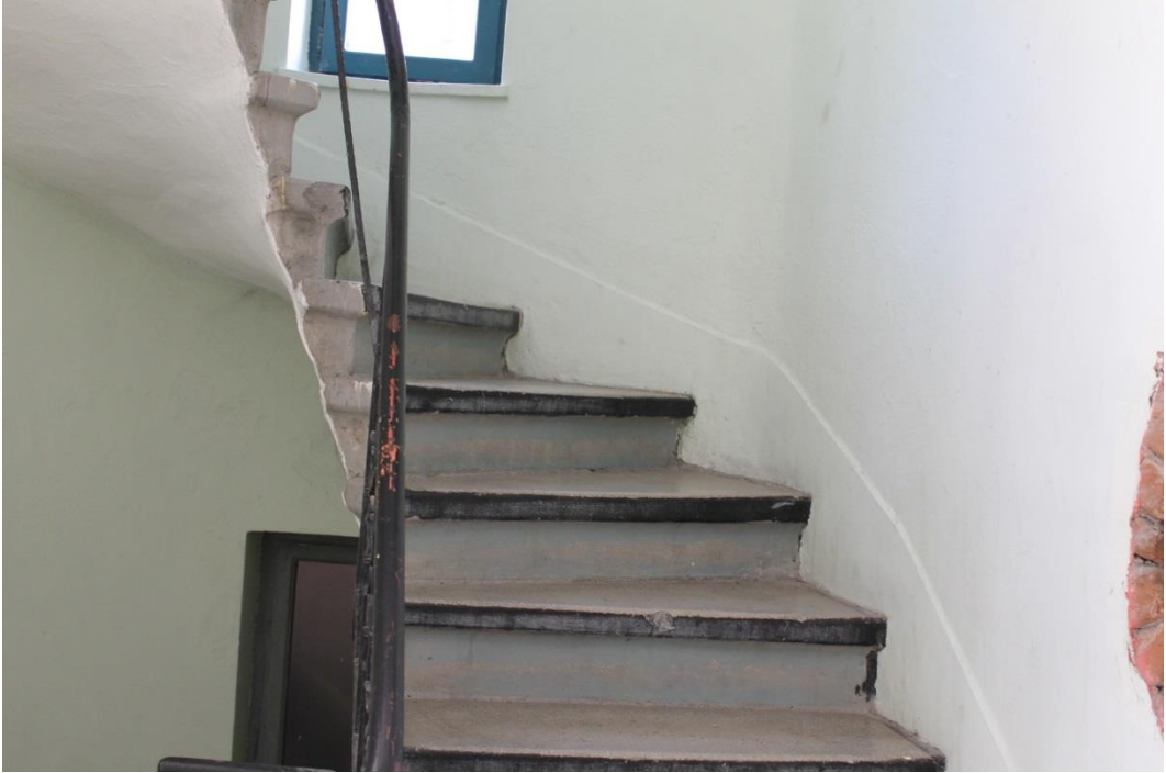
Şekil 6.216: 10 numaralı yapı zemin kat merdiven fotoğrafı.
