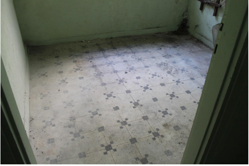
Şekil 6.213: 10 numaralı yapı bodrum kat fotoğrafı.
