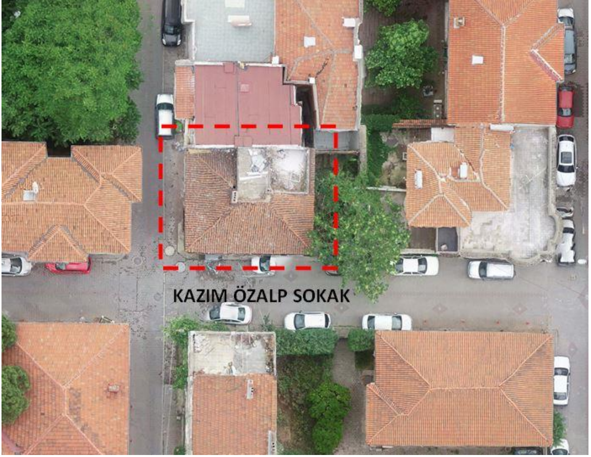
Şekil 6.262: Yapının drone fotoğrafı.
