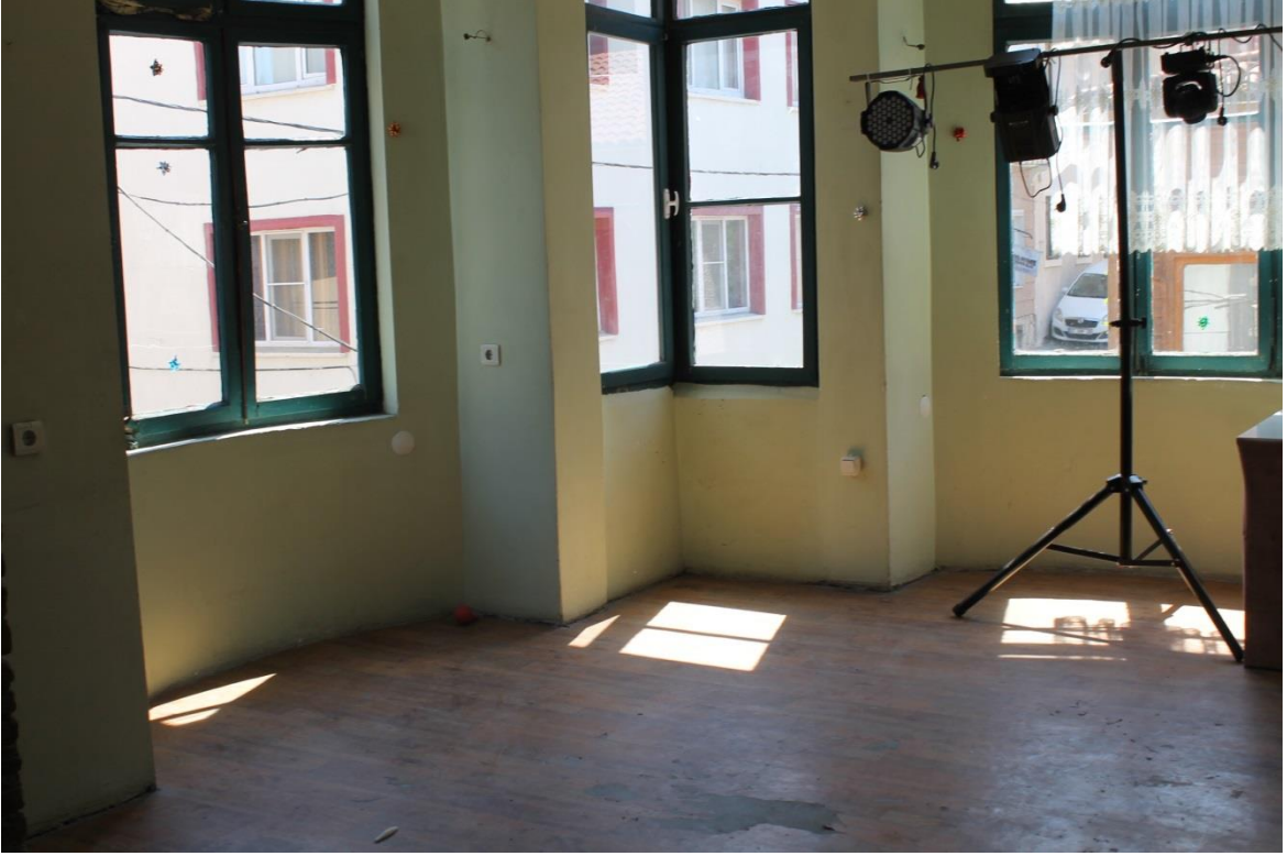
Şekil 6.221: 10 numaralı yapı 2. kat fotoğrafı.
