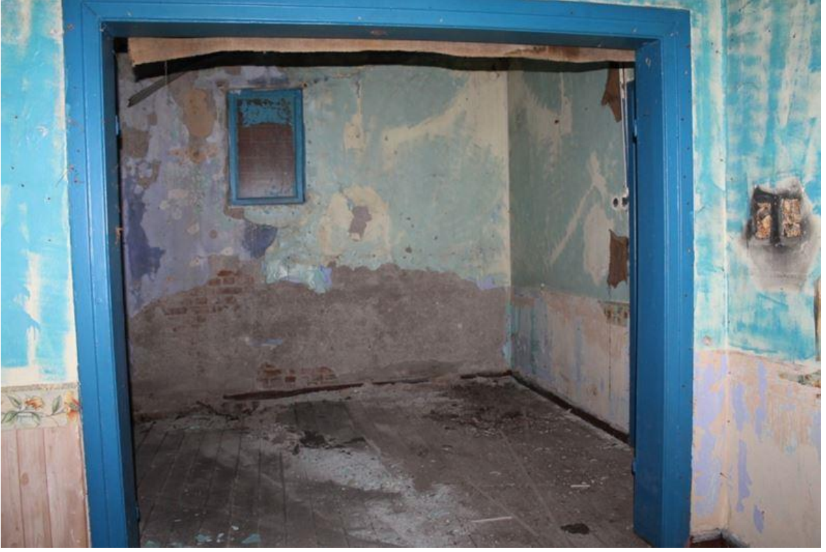
Şekil 6.288: 14 numaralı yapı 1. kat fotoğrafı.
