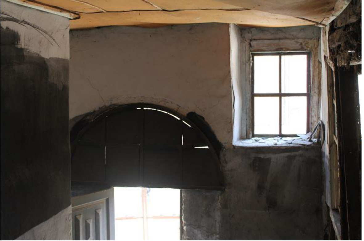
Şekil 6.414: 25 numaralı yapı zemin kat fotoğrafı.
