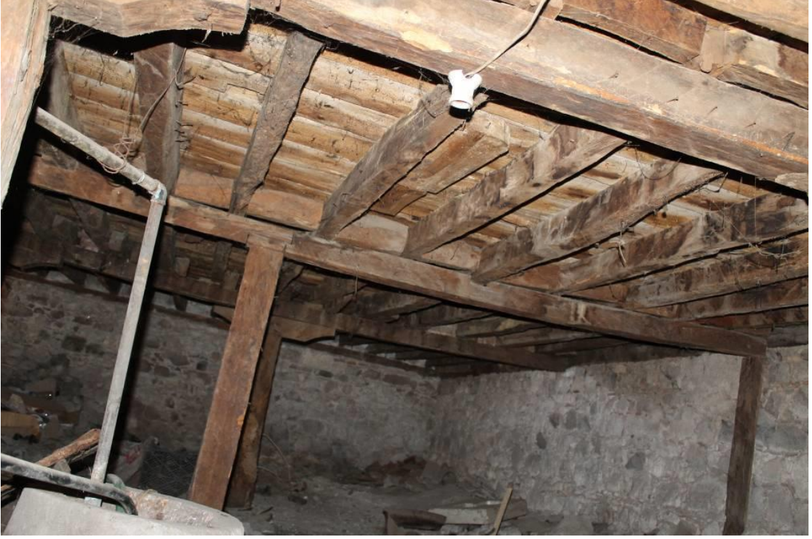
Şekil 6.96: 4 numaralı yapı bodrum kat fotoğraf.
