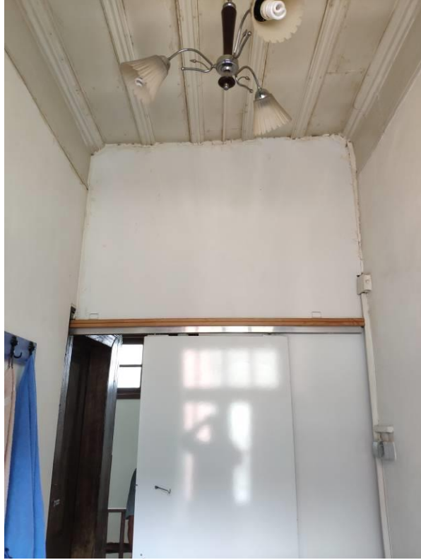
Şekil 6.369: 20 numaralı yapı 2. kat fotoğrafı.
