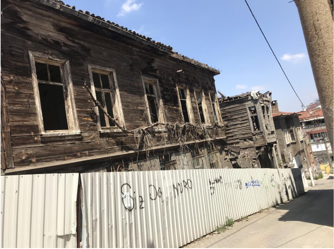
Şekil 6.90: 4 numaralı yapı sağ yan cephe fotoğrafı.
