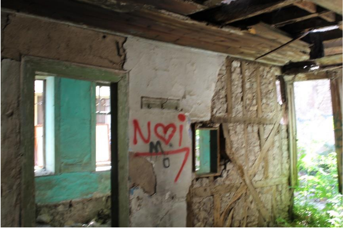
Şekil 6.55: 3 numaralı yapı zemin kat fotoğrafı.
