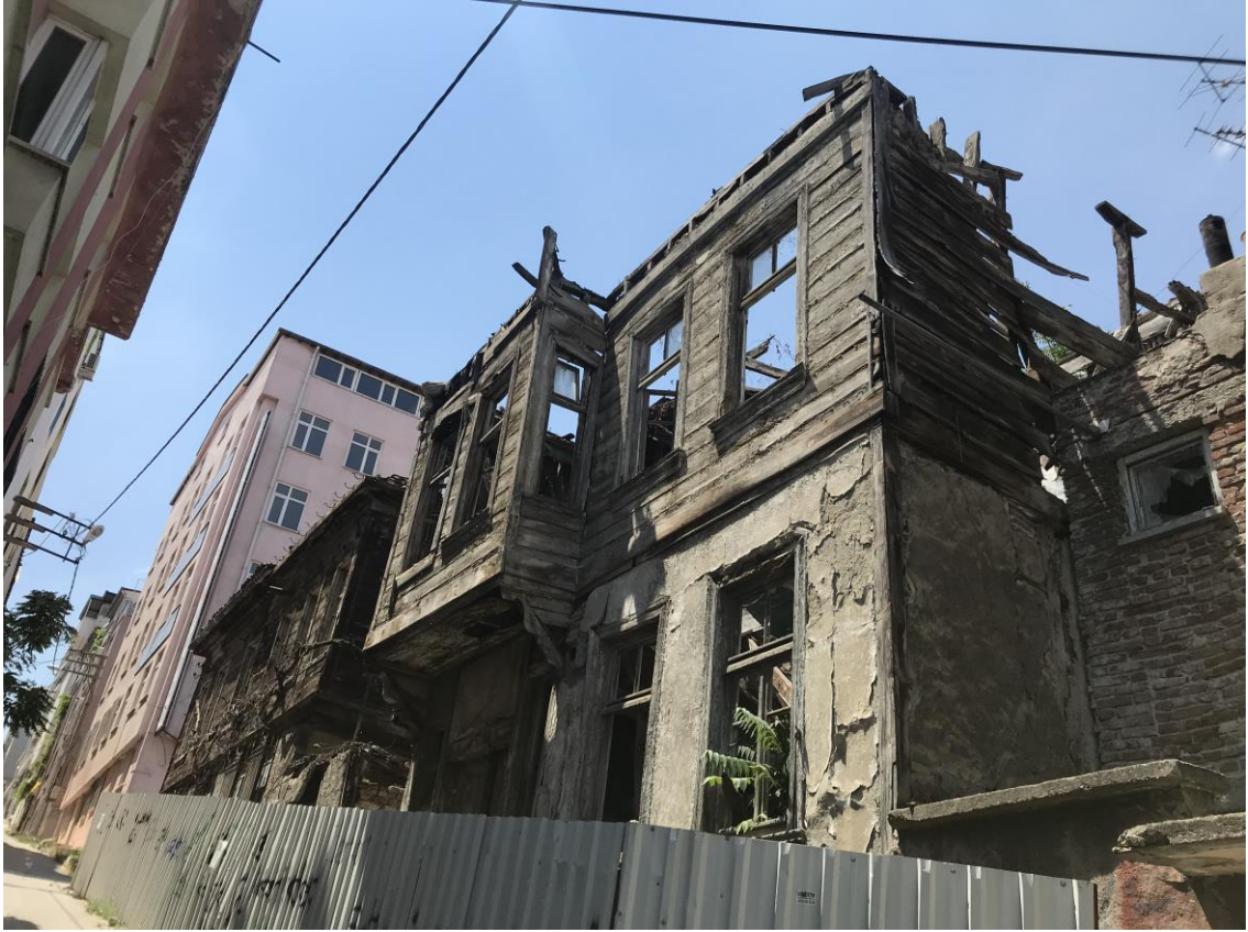
Şekil 6.134: 5 numaralı yapı ön cephe fotoğrafı.
