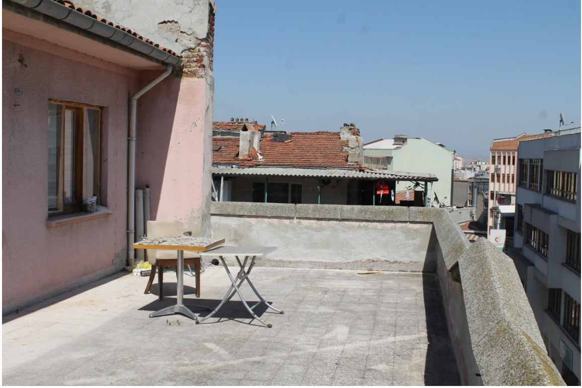
Şekil 6.223: 10 numaralı yapı teras fotoğrafı.
