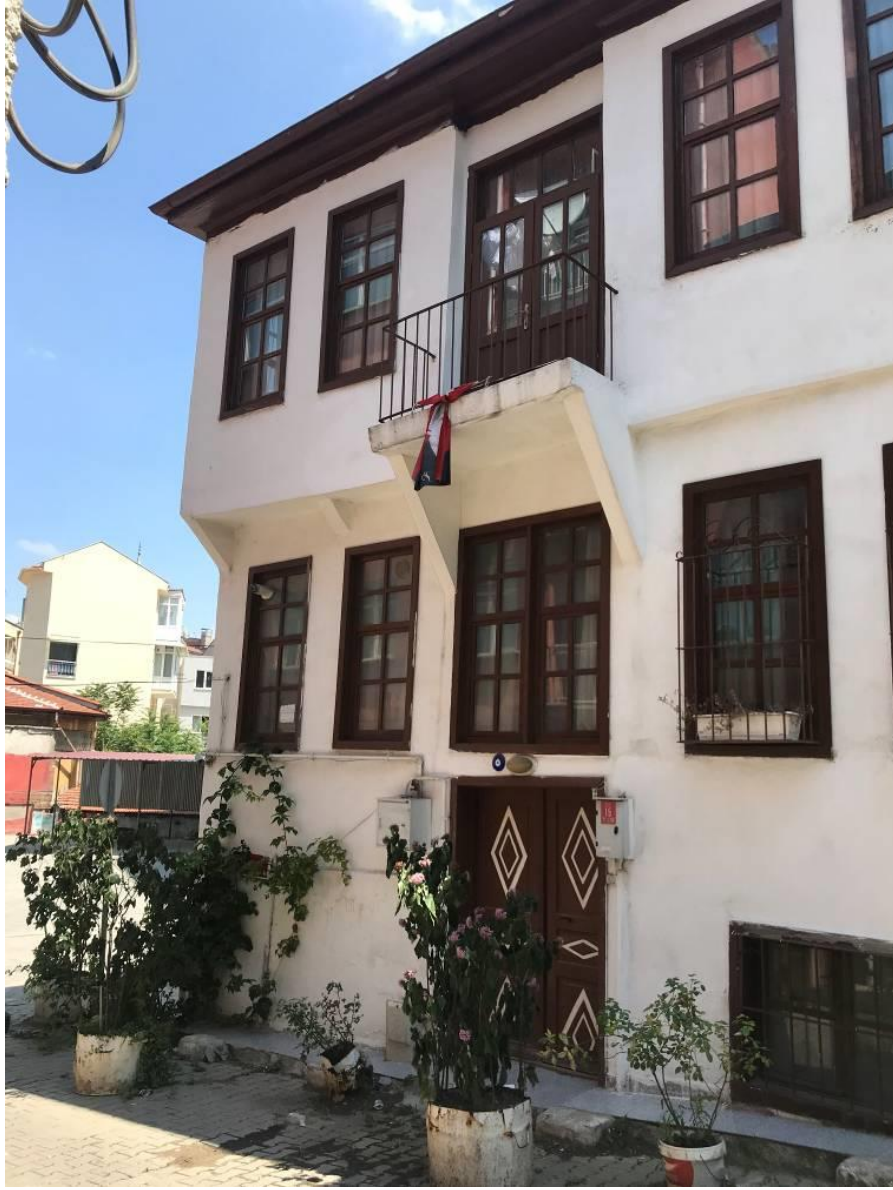
Şekil 6.357: 20 numaralı yapı ön cephe fotoğrafı.
