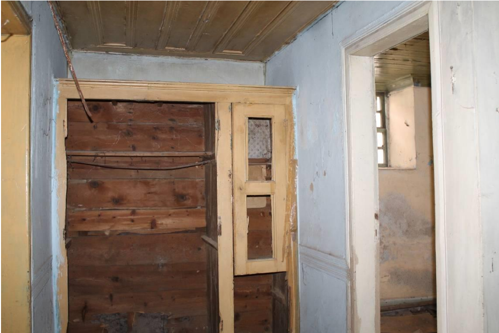
Şekil 6.99: 4 numaralı yapı zemin kat fotoğraf.
