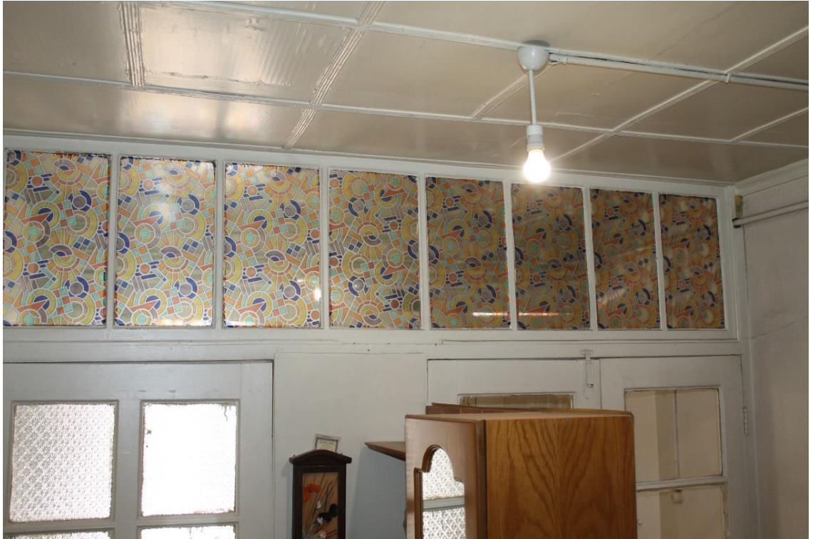
Şekil 6.174: 8 numaralı yapı bodrum kat fotoğrafı.
