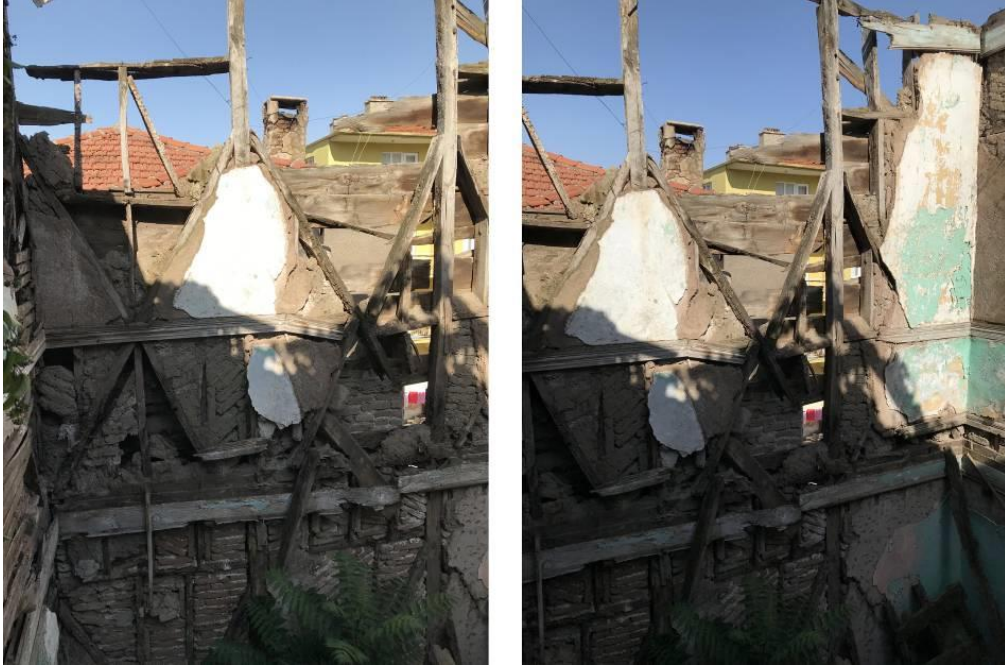
Şekil 6.145: 5 numaralı yapı 1. kat fotoğrafı.
