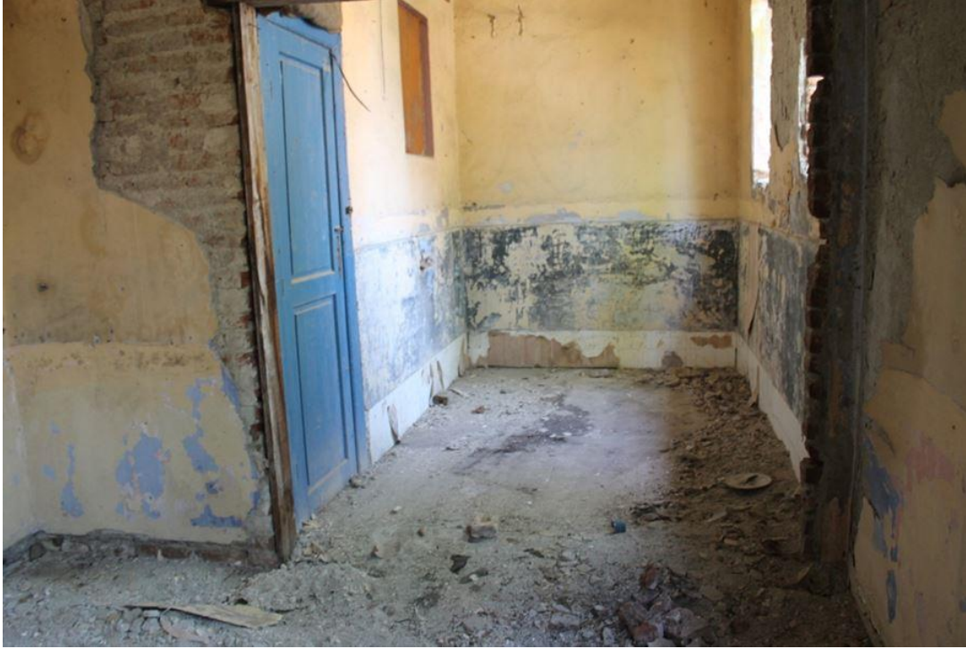
Şekil 6.285: 14 numaralı yapı zemin kat fotoğraf.
