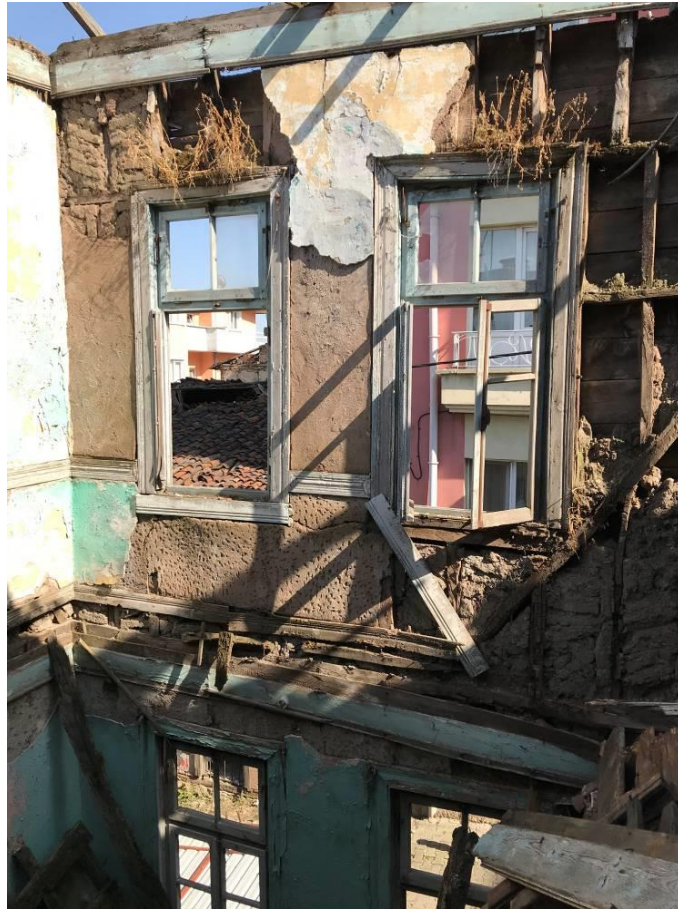
Şekil 6.144: 5 numaralı yapı 1. kat fotoğrafı.
