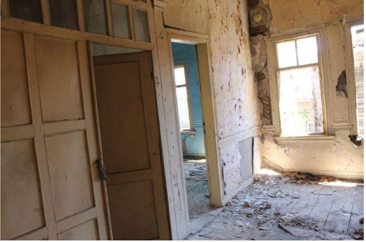
Şekil 6.103: 4 numaralı yapı 1. kat fotoğraf.
