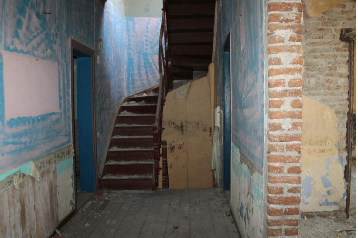
Şekil 6.287: 14 numaralı yapı 1. kat merdiven kovası fotoğrafı.
