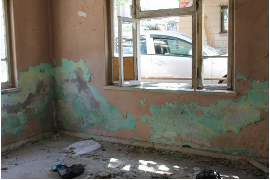
Şekil 6.323: 17 numaralı yapı zemin kat fotoğrafı.
