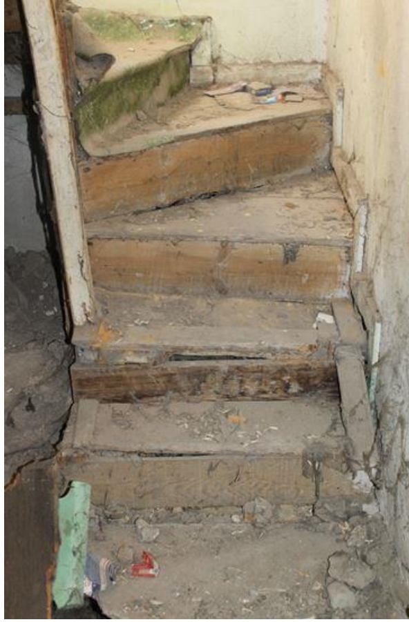
Şekil 6.415: 25 numaralı yapı zemin kat fotoğrafı.
