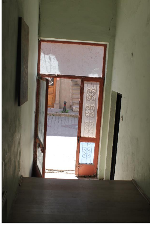
Şekil 6.215: 10 numaralı yapı zemin kat fotoğrafı.
