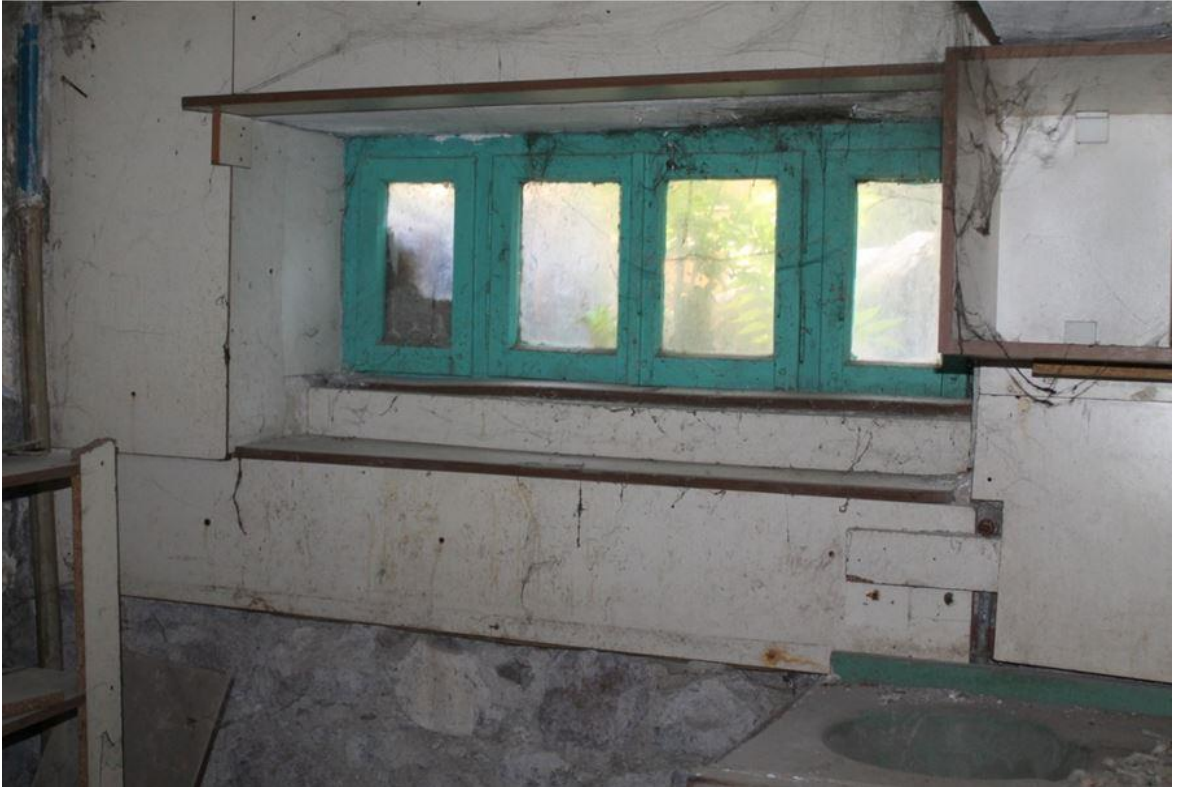
Şekil 6.281: 14 numaralı yapı bodrum kat fotoğrafı.
