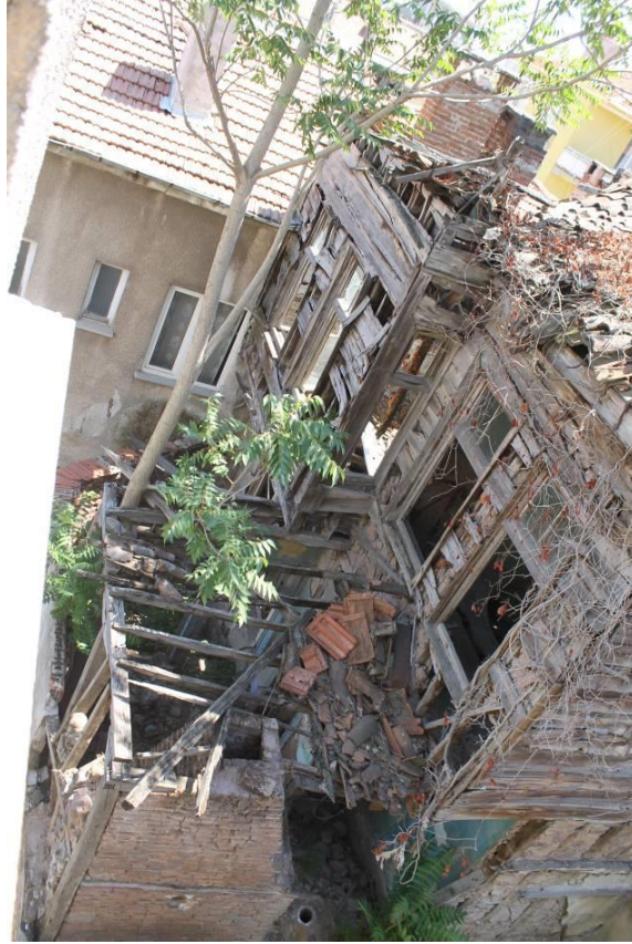
Şekil 6.138: 5 numaralı yapı sağ yan cephe fotoğrafı.
