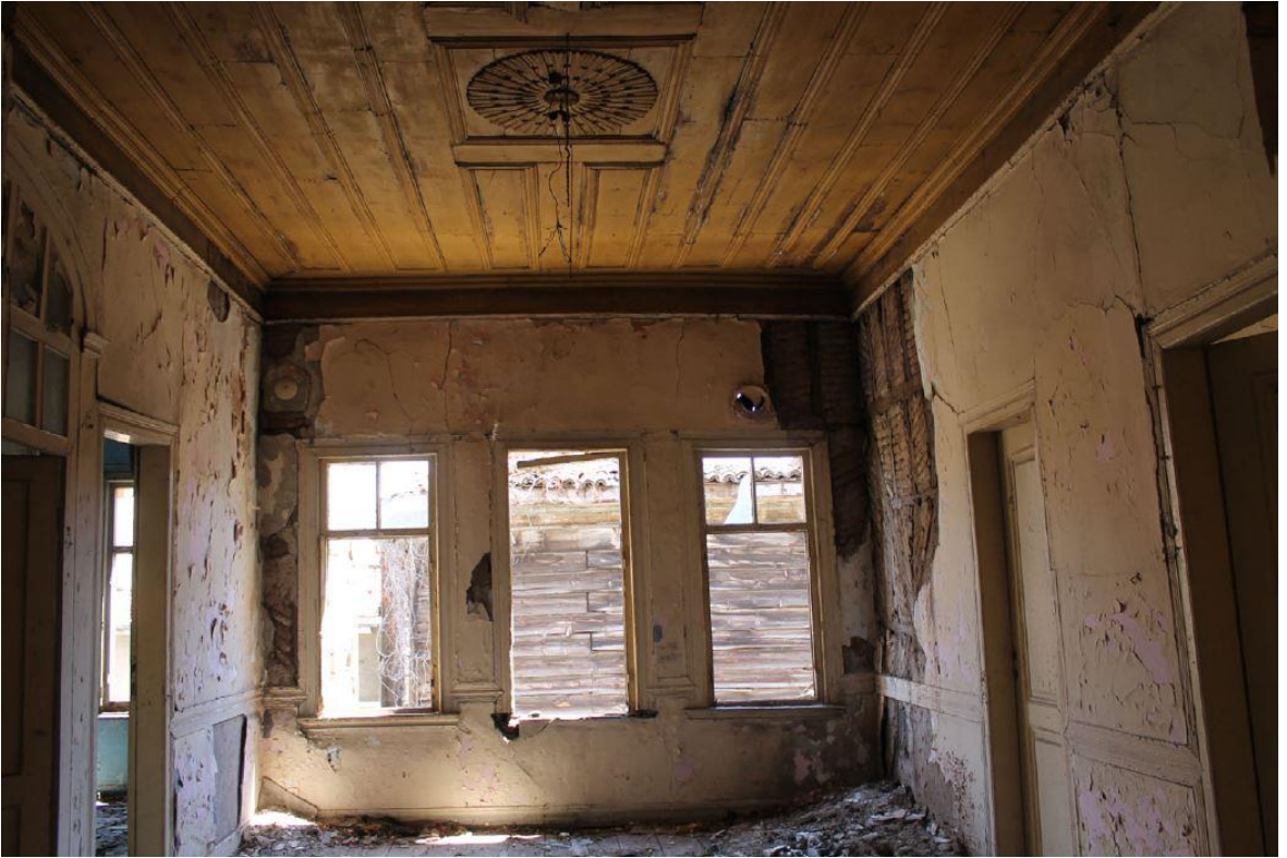
Şekil 6.104: 4 numaralı yapı 1. kat fotoğraf.
