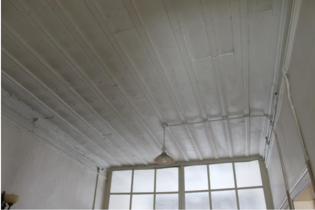
Şekil 6.180: 8 numaralı yapı 1. kat fotoğraf.
