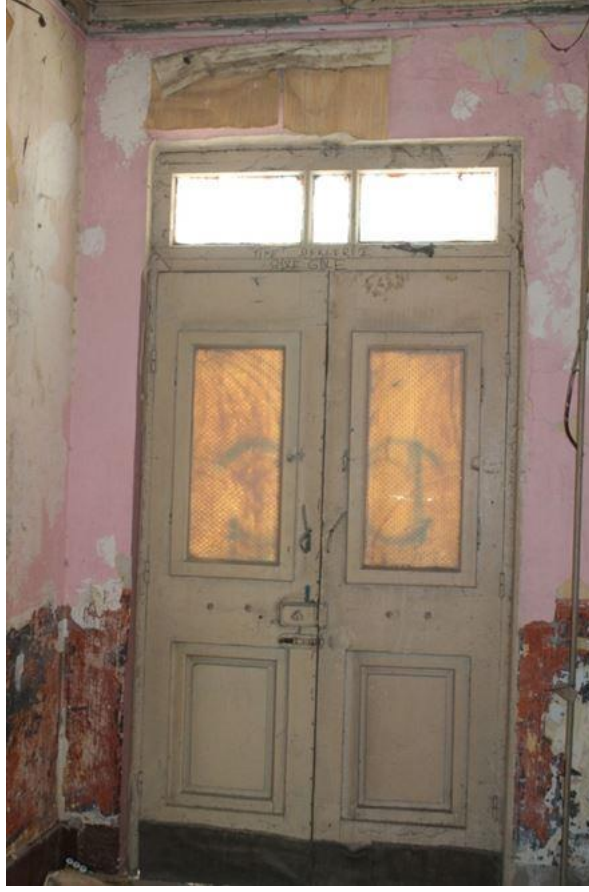
Şekil 6.282: 14 numaralı yapı zemin kat fotoğrafı.
