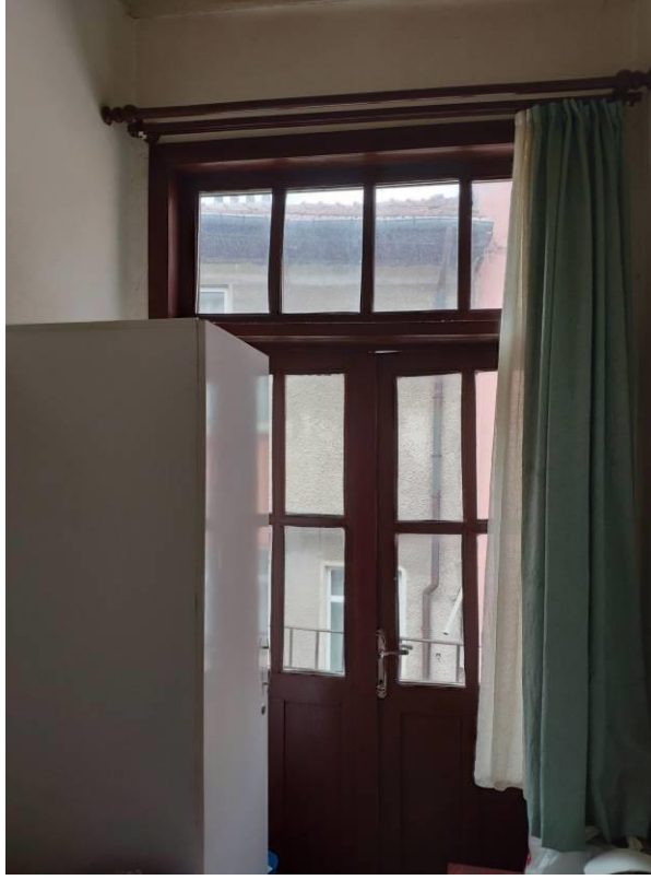
Şekil 6.368: 20 numaralı yapı 2. kat fotoğrafı.
