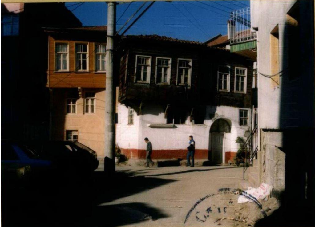
Şekil 6.394: 25 numaralı yapı arşiv fotoğrafı (Balıkesir Kültür Varlıklarını Koruma Bölge Kurulu Müdürlüğü arşivi).
