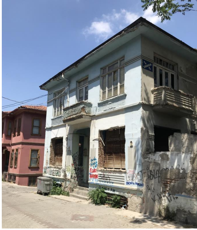
Şekil 6.276: 14 numaralı yapı ön cephe fotoğrafı.
