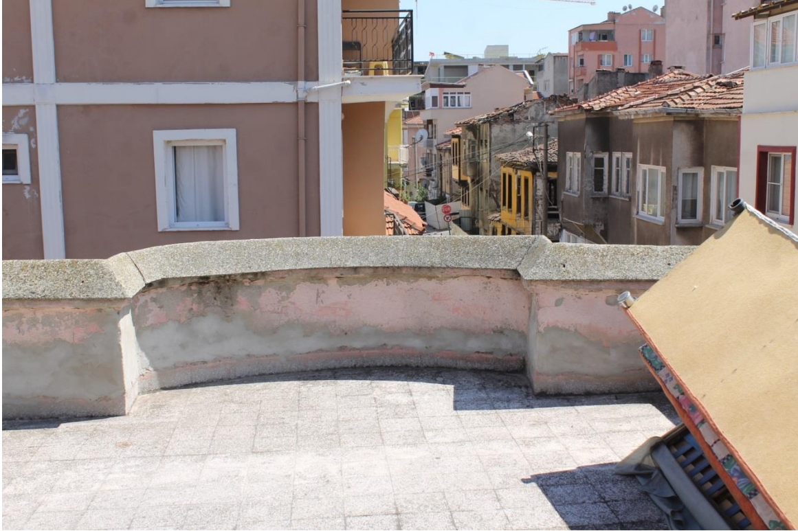
Şekil 6.224: 10 numaralı yapı teras fotoğrafı.
