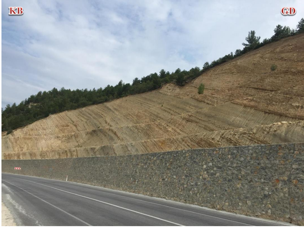
Şekil 3.8: Emet Formasyonu'nun Emet-Tavşanlı yolu yol yarmalarından görünümü (Wgs84: 39.421706 29.308648).
