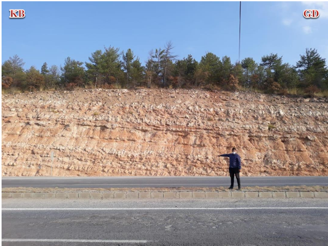
Şekil 3.9: Yataya yakın Emet Formasyonu'nun yol yarmalarından görünümü (Wgs84: 39.419144 29.313900).
