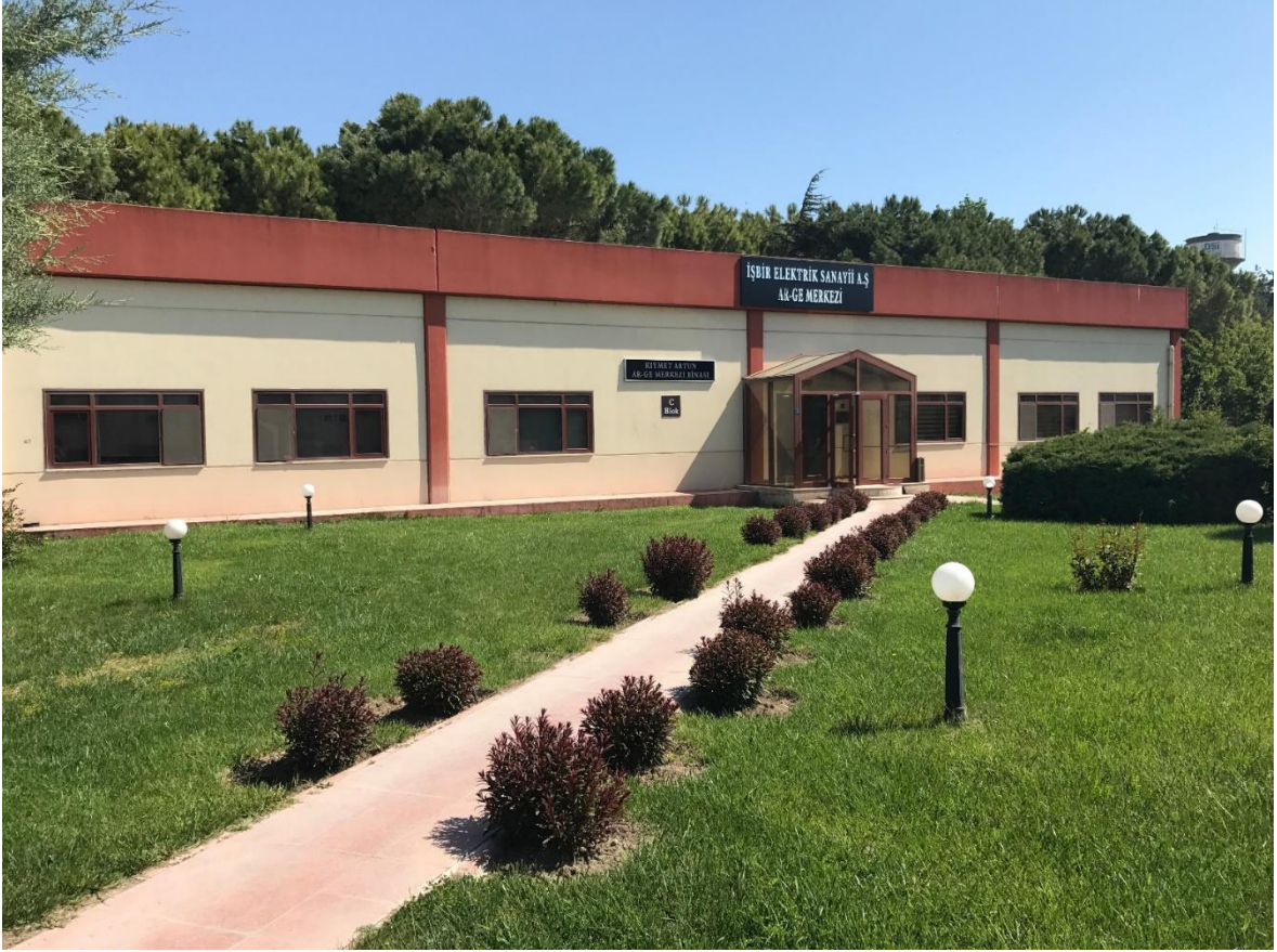
Şekil 5.1: İşbir Elektrik Sanayii A.Ş. AR-GE Merkezi.
