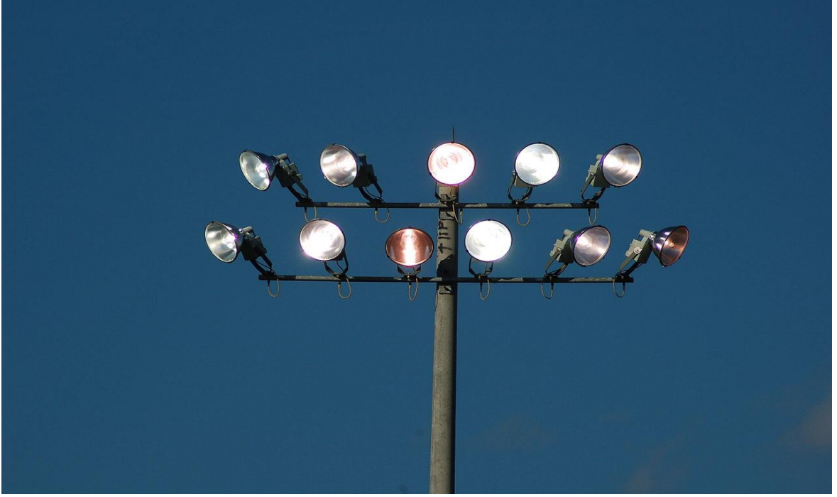
Şekil 1.3: Bir beysbol sahasını aydınlatmada kullanılan yüksek performanslı spot ışıkları ( https://www.wikiwand.com/en/Metal-halide_lamp ).
