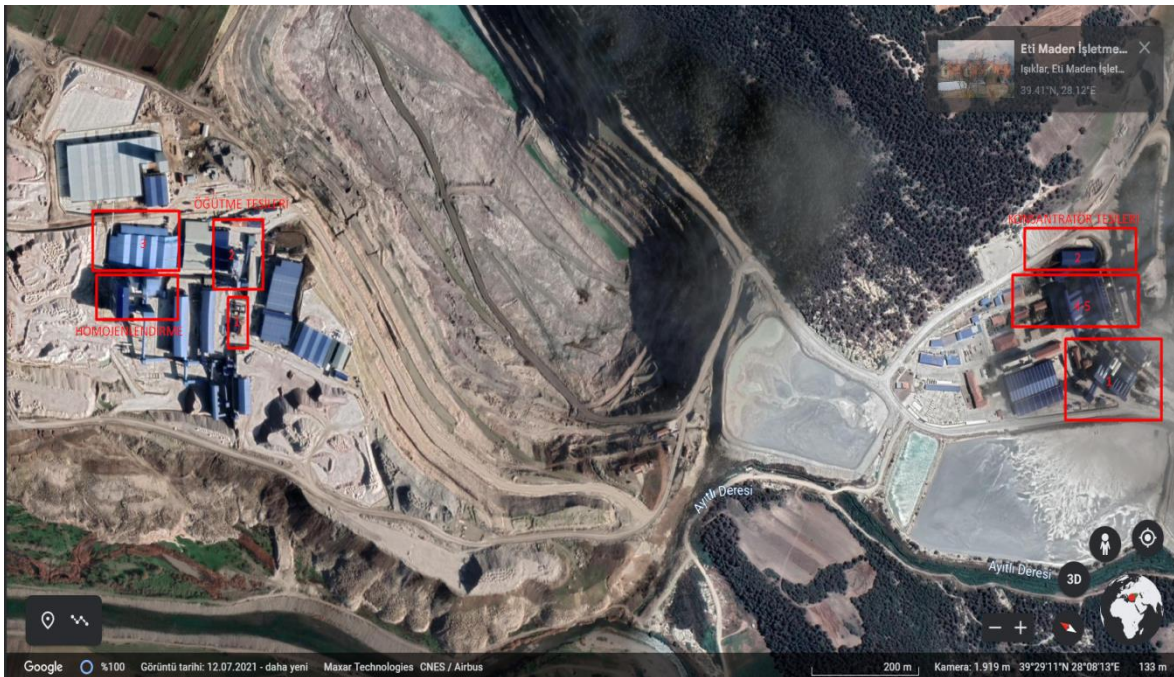
Şekil 1.2: Eti Maden Bigadiç Bor İşletme Müdürlüğü tesisleri görünümü.
