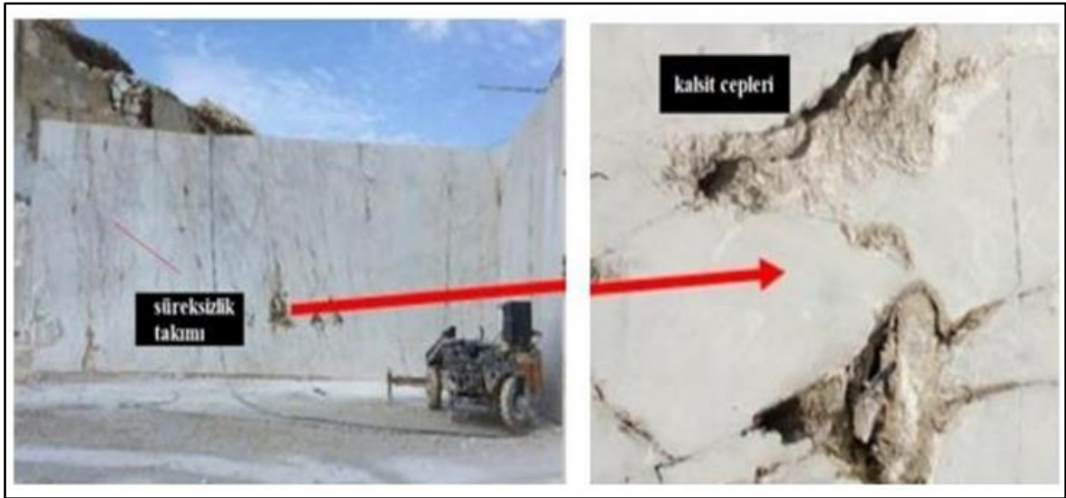
Şekil 3.13: Başalan ve civarındaki açık ocak şevlerinde gözlemlenen kalsit cepleri.
