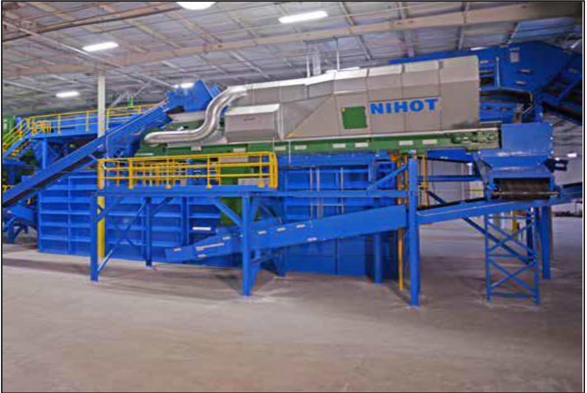
Şekil 4.10: Air Separator (Kırıcı)
