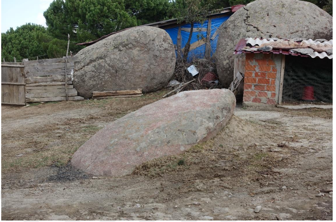
Şekil 37. Sahadaki Mevcut Granit Bloğu Bozulmadan KÜMESİN BİR DUVARI OLARAK KULLANILMASI ÖRNEĞİ
