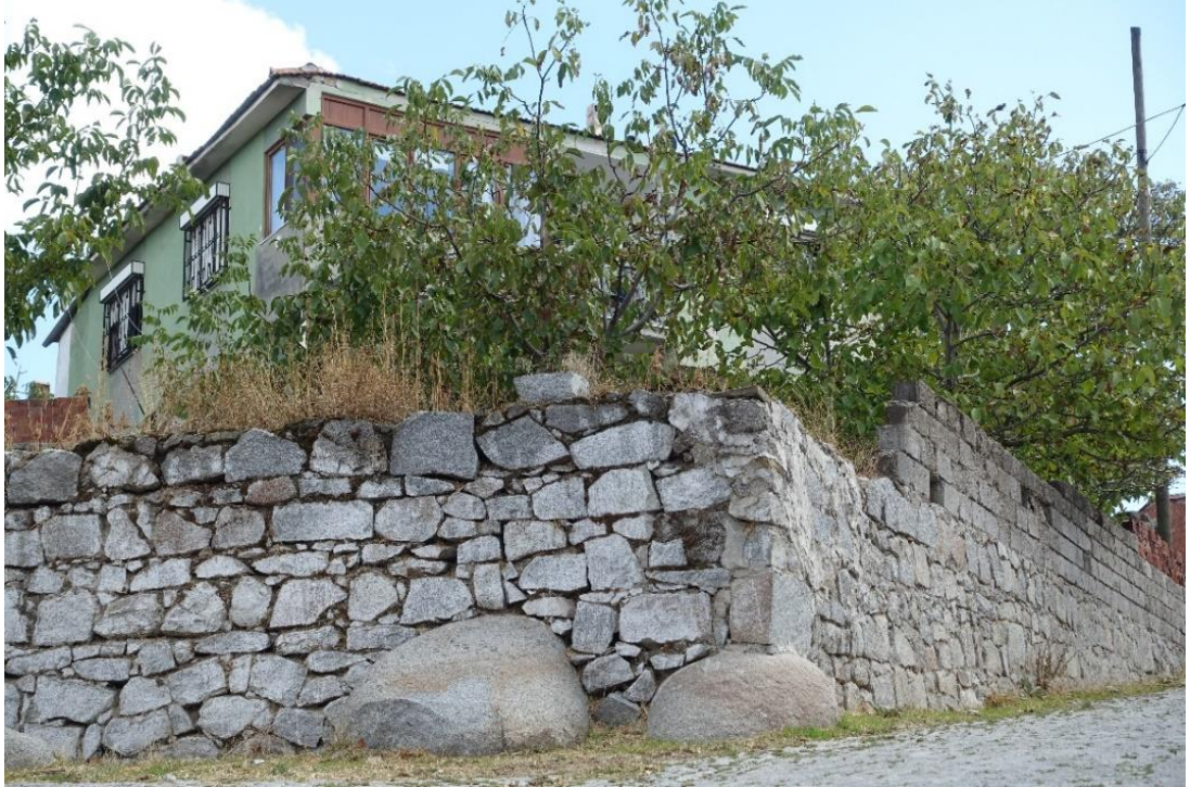
Şekil 38. Hacıbozlar Köyünde Mevcut Granit Bloklarının Yeri Sabit Tutularak Üzerine Yapı Malzemesi Olarak Yine Sahadan Elde Edilmiş Granitler İle Yapılmış Bahçe Duvarı Örneği
