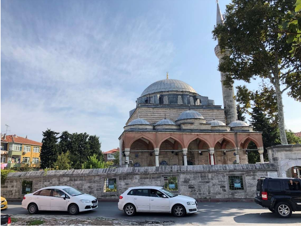
Şekil 4.21: Hadım İbrahim Paşa Camii dış cephe görüntüsü (Furkan Topal fotoğraf arşivinden)
