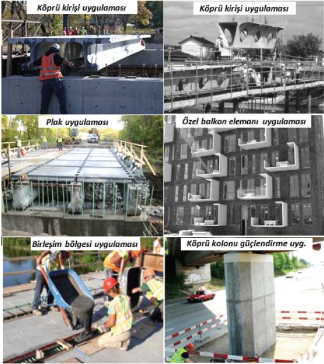
Şekil 3.7: Ultra yüksek performanslı lifli betonun uygulama alanları (Gültekin, 2020).
