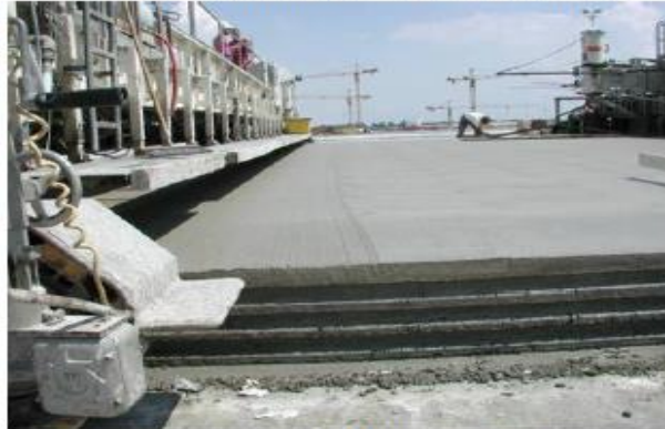
Kayar Kalıp Sistemi ile Rijit Üstyapı Uygulaması
