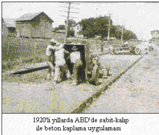
Şekil 2.3: 1920’li yıllarda sabit kalıp ile 1930’lu yıllarda mekanik olarak yapılan beton kaplama uygulamalarına örnekler (Tanyıldızı, 2010).
