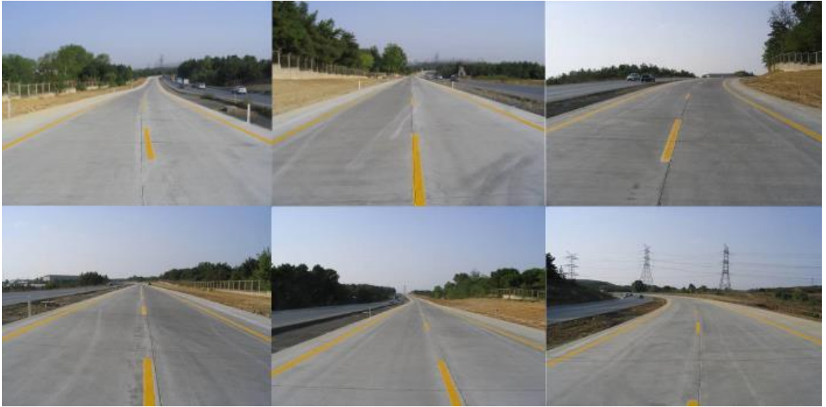
Şekil 2.7: Hasdal Kemberburgaz beton yol uygulaması.
