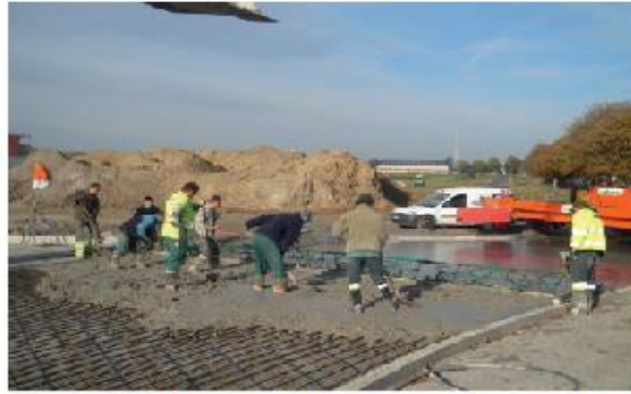
Sabit Kalıp Sistemi ile Beton Kaplama Uygulaması
