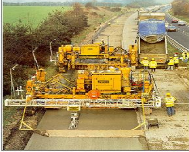
Kayar Kalıp Sistemi ile Rijit Üstyapı Uygulaması
