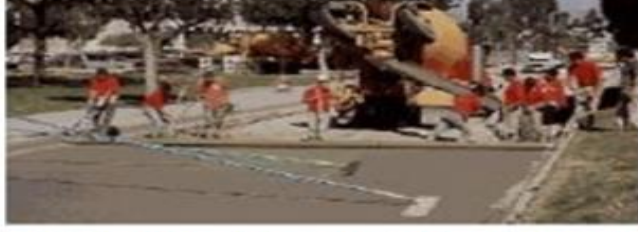
Sabit Kalıp Sistemi ile Beton Kaplama Uygulaması
