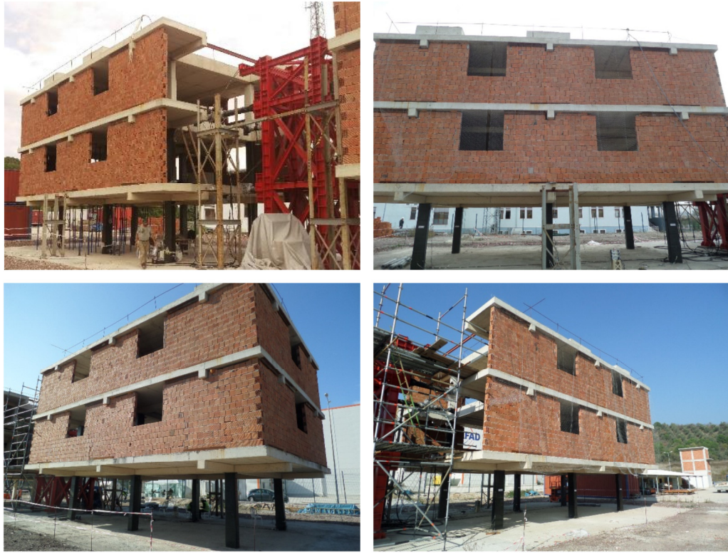
Şekil 3.12: Güçlendirilmiş test binası.
