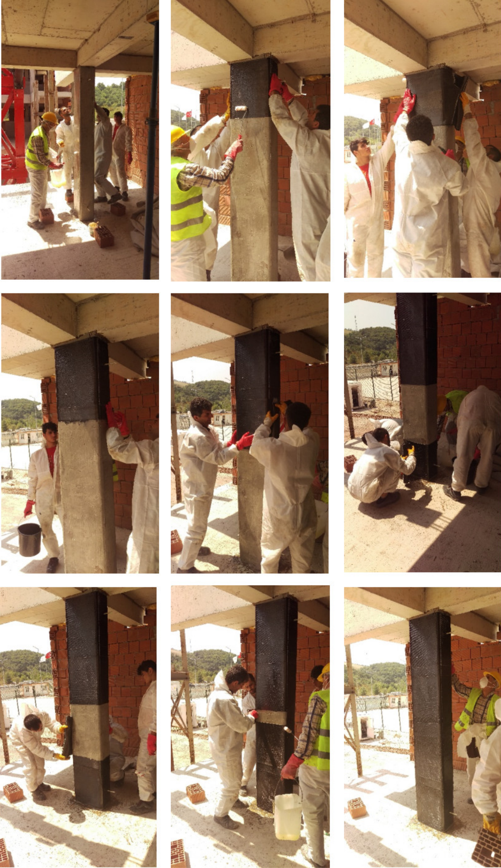
Şekil 3.28: LP sargılama ile kolon güçlendirmesi.
