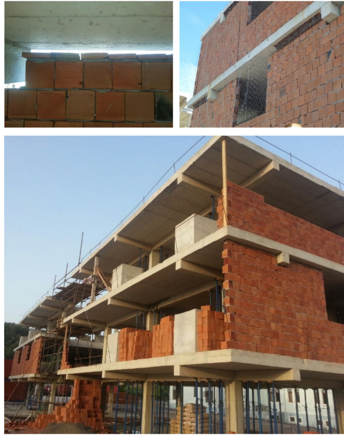
Şekil 3.19: Test binalarının ikinci ve üçüncü katlarında tuğla duvarların yerleşimi.
