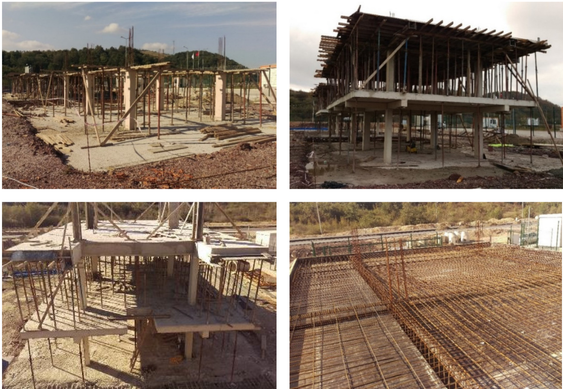
Şekil 3.8: Test binalarının inşaat sürecinin farklı aşamaları.
