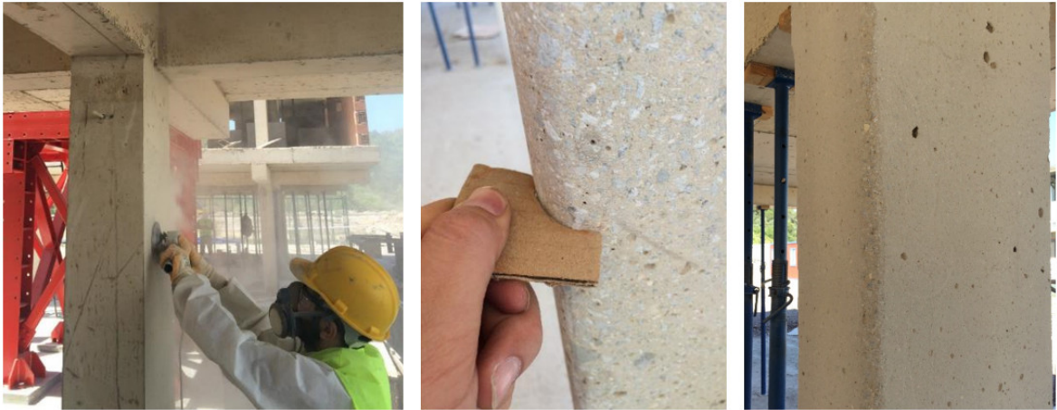
Şekil 3.25: Yüzey hazırlama işlemleri.
