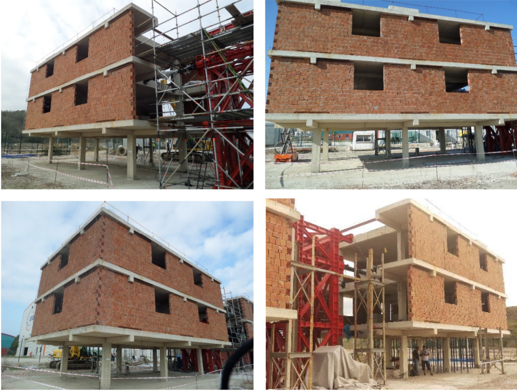
Şekil 3.11: Güçlendirilmemiş test binası.
