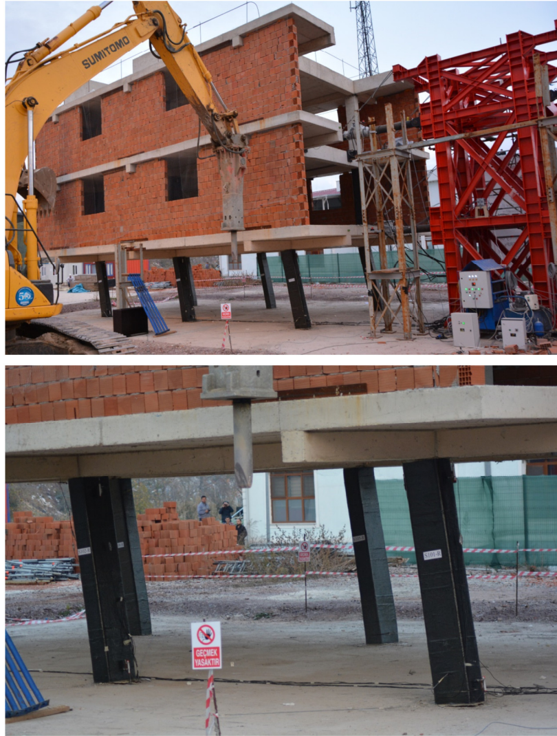
Şekil 3.51: Güçlendirilmiş test binasının deney sonu görünümüleri.
