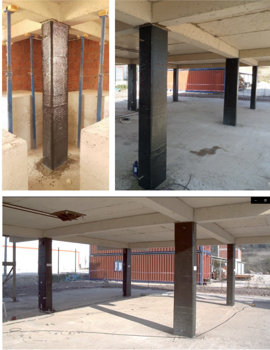
Şekil 3.29: LP ile sargılanarak güçlendirilmiş kolonlar.
