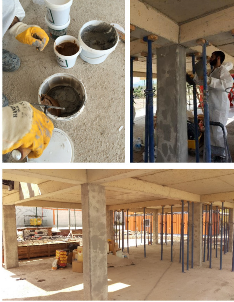
Şekil 3.26: Yüzey tamir işlemleri ve LP sargılamaya hazır kolonlar.
