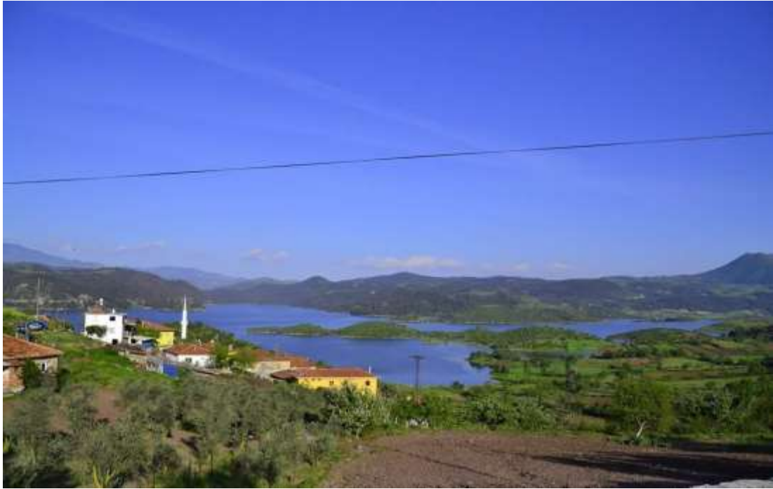
Fotoğraf 4. aygören Barajı
