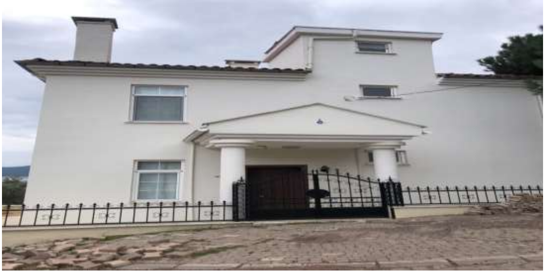
Fotoğraf 31. Çaygören Mahallesi'nde Baraj Kenarında Bir Dupleks Konut
