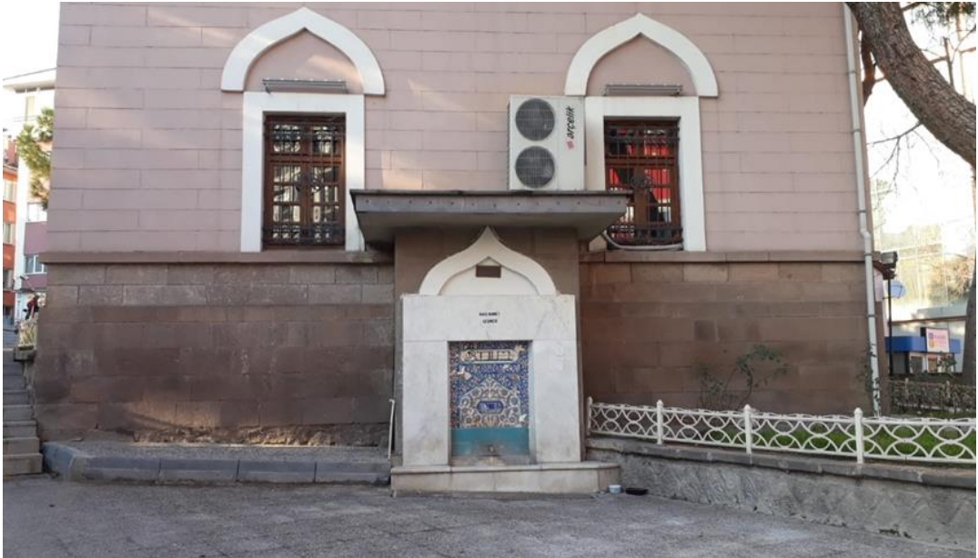
Hacı Ali Camii Duvarı
