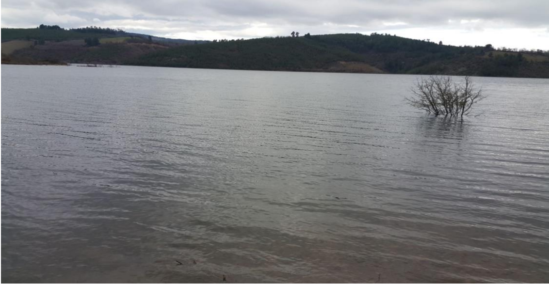
Şekil 2.4: Ardıçtepe Barajı ikinci istasyon görüntüsü
