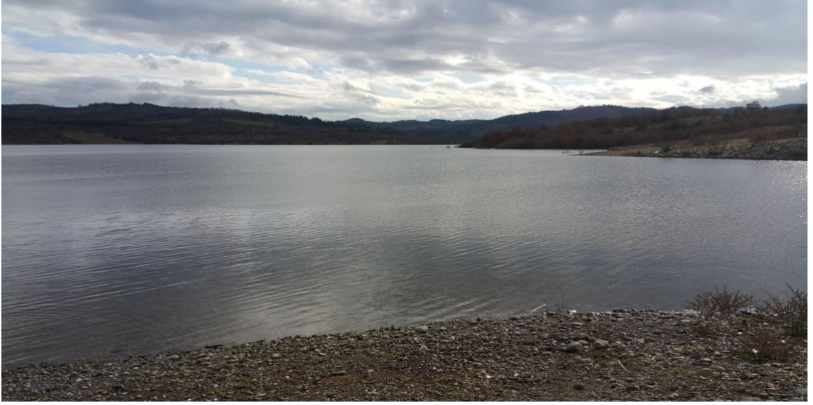
Şekil 2.5: Ardıçtepe Barajı üçüncü istasyon görüntüsü
