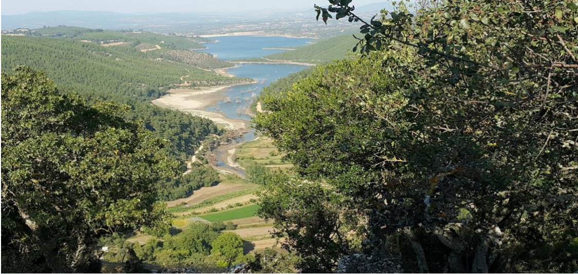
Şekil 2.1: Ardıçtepe Barajı genel görünümü
