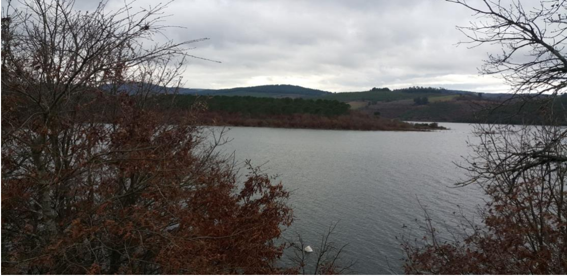
Şekil 2.3: Ardıçtepe Barajı birinci istasyon görüntüsü
