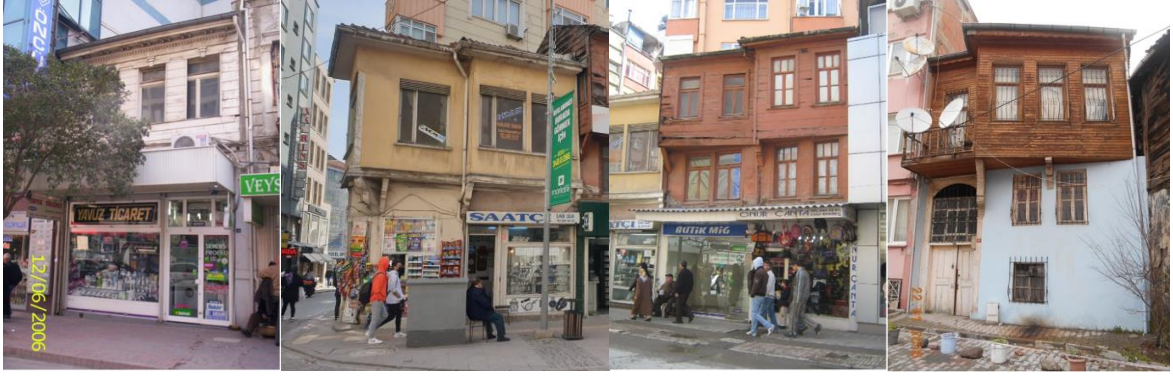
Resim 3.5: Tur Aksı Üzerinde Bulunan ve Onarımı Yapıldığı Taktirde Tura Dâhil Edilebilecek Yapılar
