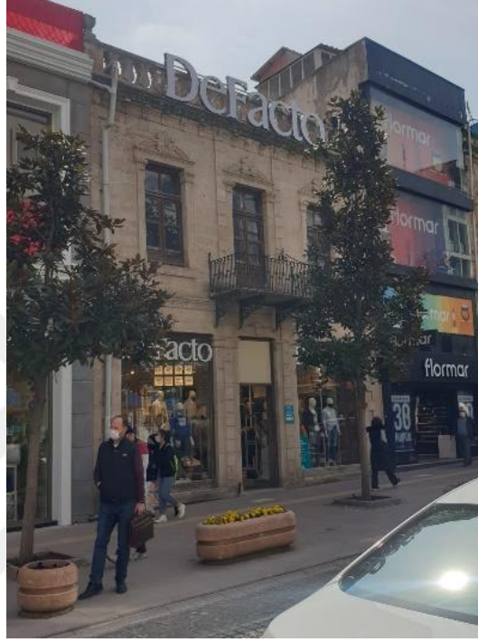
Resim 3.21: Eski Balıkesir Palas Binası
