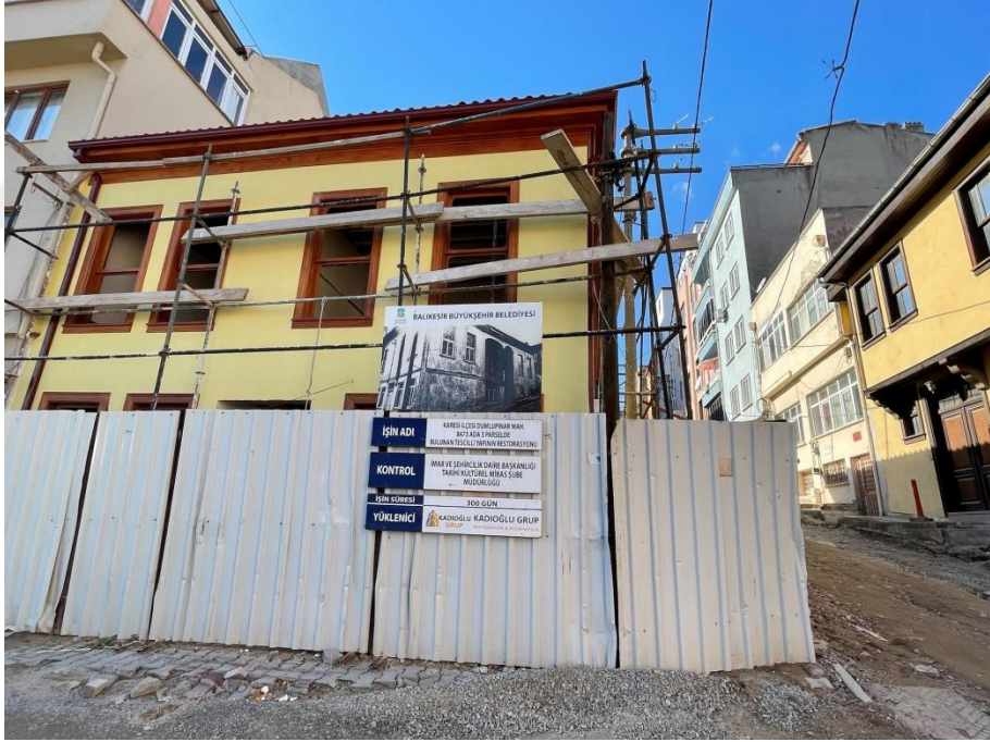
Şekil 70. Balıkesir Büyükşehir Belediyesi Tarafından Restorasyon İşlemi Devam Eden Bir Yapı
