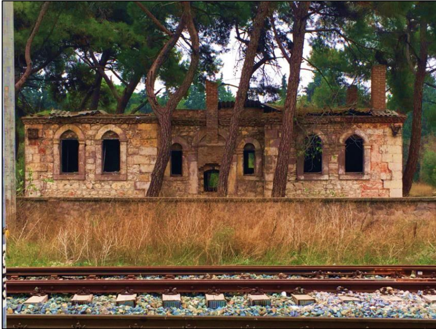
Şekil 51. Gaziosmanpaşa Mahallesi’nde Bulunan Terk Edilmiş Tren İstasyonundan Bir Görünüm.
