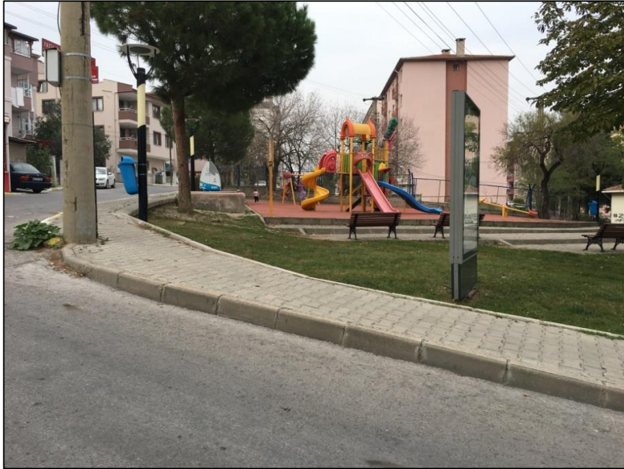
Şekil 36. Sütlice Mahallesi'nde Yol Kenarında Koruma Bariyerleri Bulunmayan Çocuk Parkı
