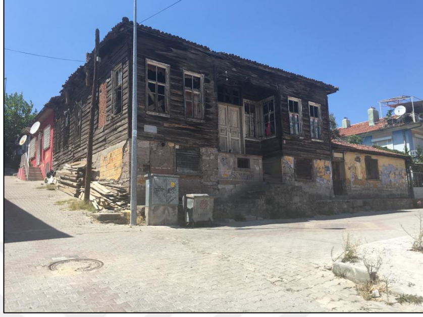
Şekil 55. Aygören Mahallesi'nde Metruk Bir Yapıdan Görünüm
