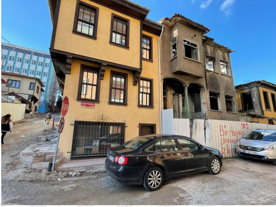
Şekil 69. Restorasyon İşlemiyle Onarılan ve Herhangi Bir İşlemlerle Onarılmayan İki Yapı
