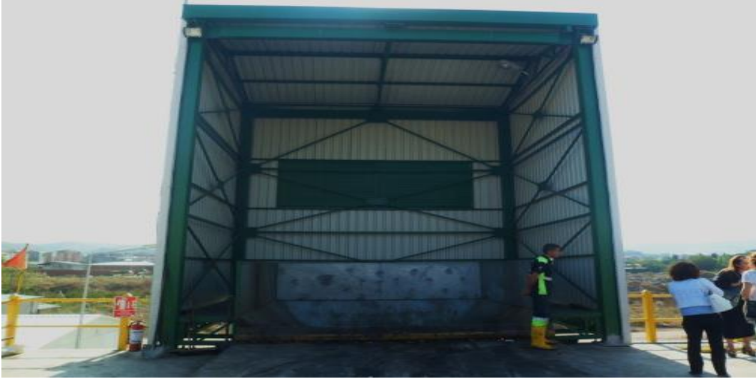
Şekil 3.4: Susurluk transfer istasyonu bunkeri
