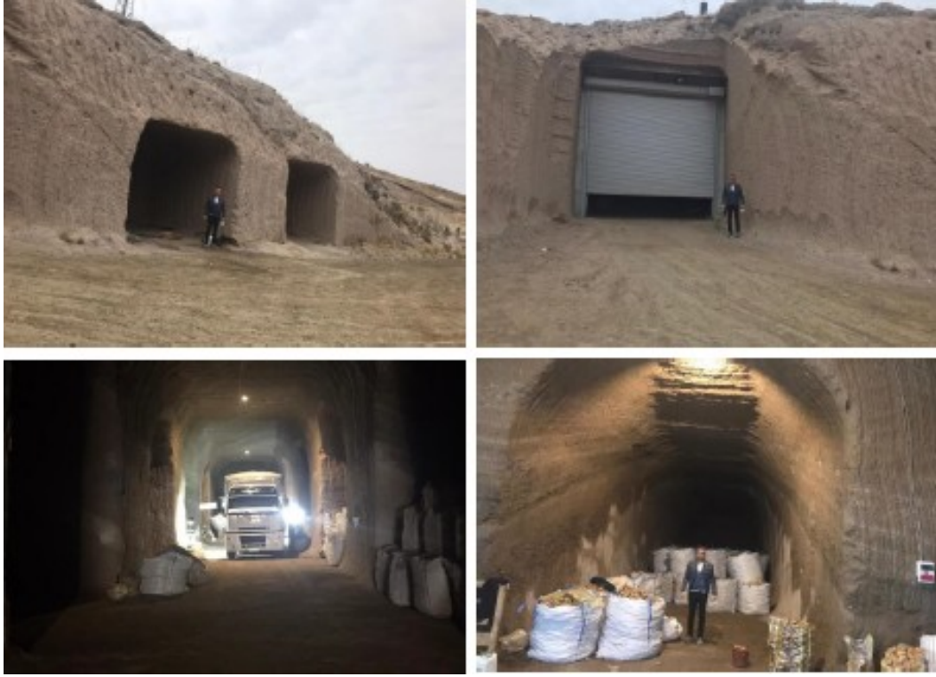
Foto 1. Akin Köyü'nde Yer Alan, Miyosen'e Ait Akin Tuf Üyesinde Bulunan, İnsan Yapımı, Doğal Patates Soğuk Hava Depoları (Kaynak: Orijinal).
