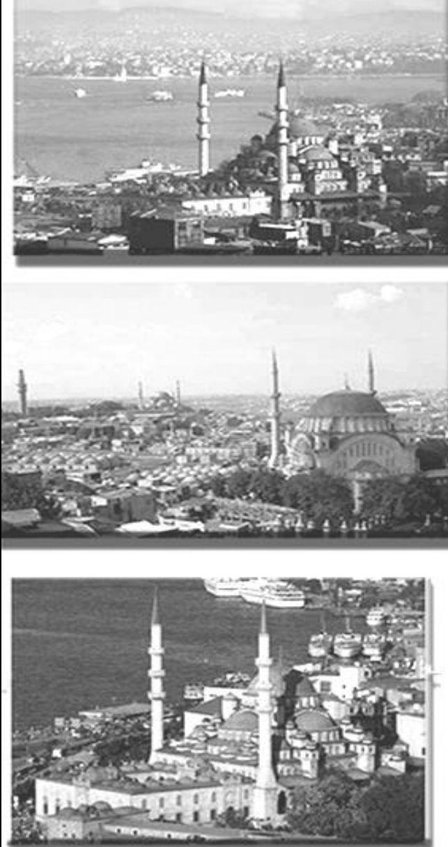
Yapının Olduđu Bölgenin Günümüze Ait Panoramik Görüntüleri (Dor İnşaat Arşivi).
