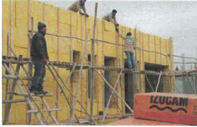
Resim 2.4: Gaziantep Yeşil Ev dış duvar ısı yalıtım uygulaması [41].
