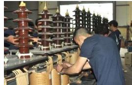
Şekil 25. Aktif Kısım Bağlantılarının Yapılması
