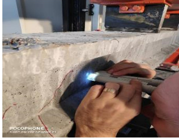
Şekil 3.12: Çatlak genişliğinin ölçülmesi.
