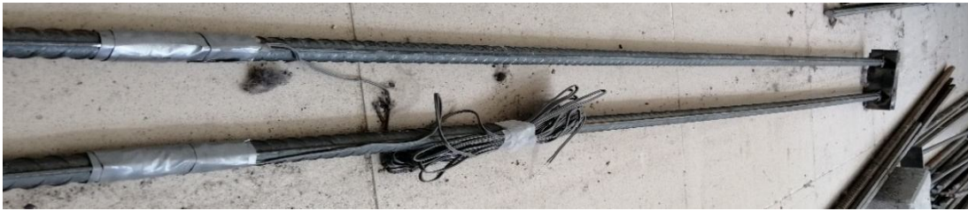
Şekil 2.6: Donatıların hazırlanması.
