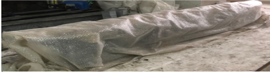
Şekil 2.11: Kirişlerin döküm sonrası korunması.
