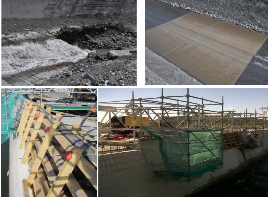
Şekil 1.13: UYPLB'nin onarım ve takviye elemanı olarak kullanımı.
