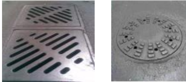
Şekil 1.15: Türkiye'de üretilen yağmur suyu ızgaraları ve rögar kapakları (Taşdemir ve diğ., 2007).
