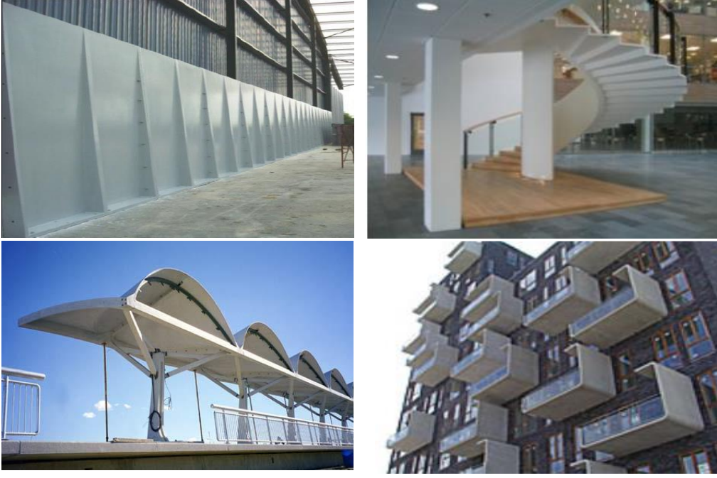
Şekil 1.12: İnce kesitli kabuk örneği ve balkon elemanı uygulamaları (Fehling ve diğ., 2014)
