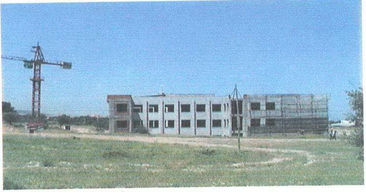
ŞEKİL B.3 : Poliklinik Bloğu Güney Cephesi
