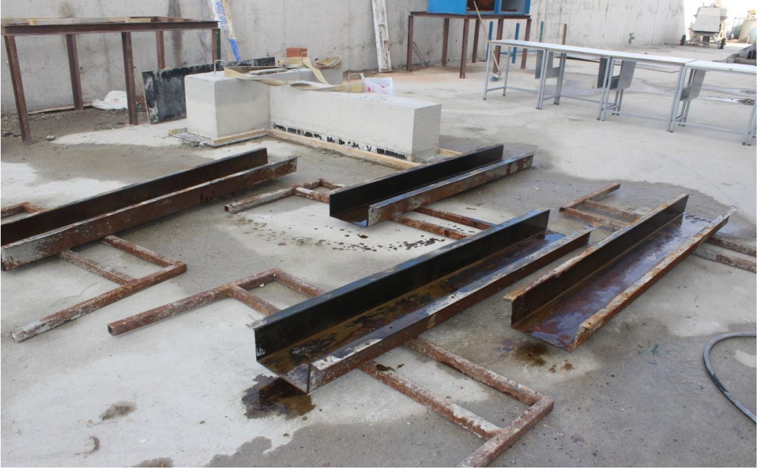
Şekil 3.17: Kolon saç kalıpları
