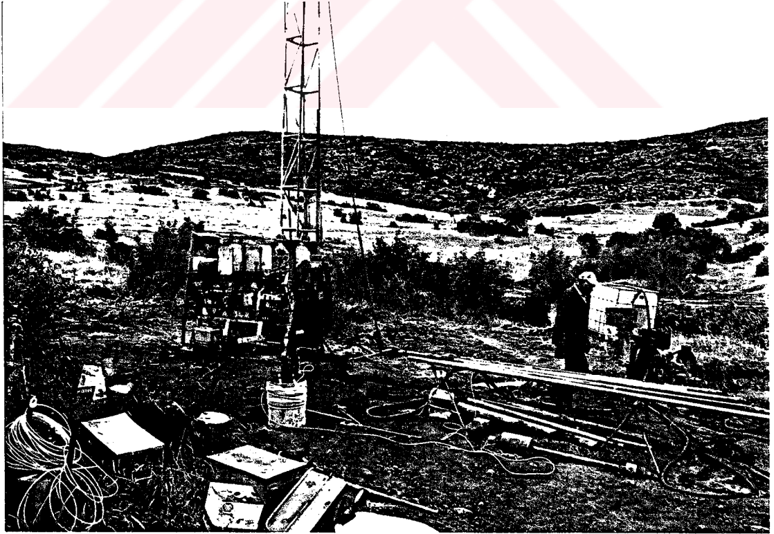
Şekil 7.4 Balıkesir Düzenli Katı Atık Sahasında Sondaj Çalışması.
