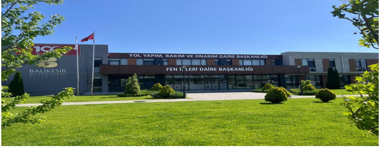
Şekil 2.1: Çalışma yapılan bina dış cephe
