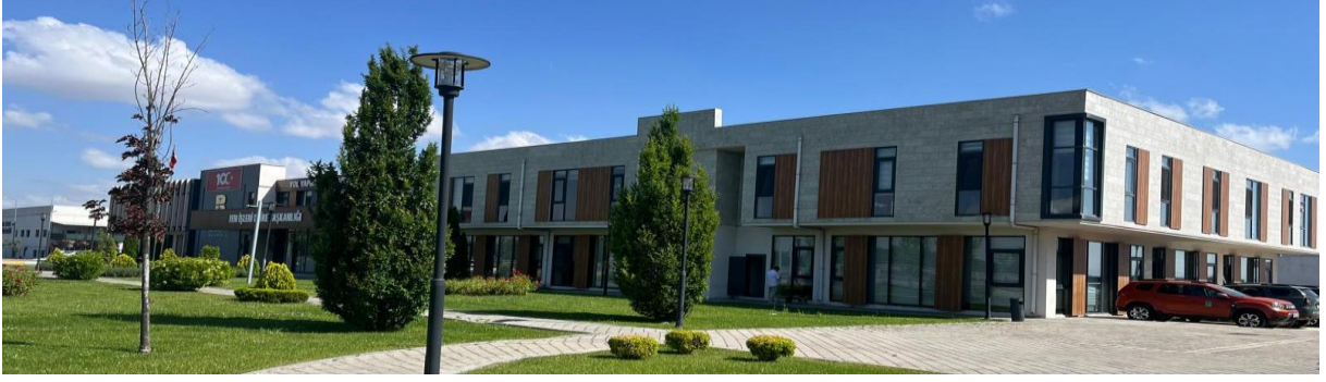
Şekil 2.3: Bina dış cephe pencere görüntüsü
