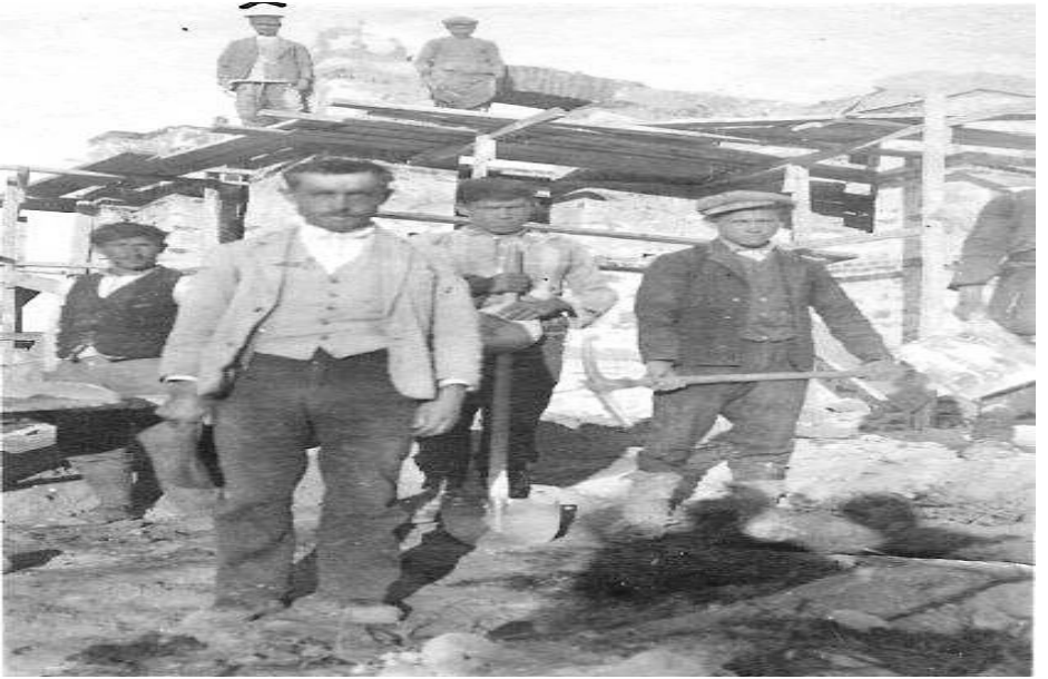
Resim 8. Uludağ (Büyük) Otel inşaatı, 1931 (Bursa Kütüphanesi'nden Ender Uzer arşivi)
