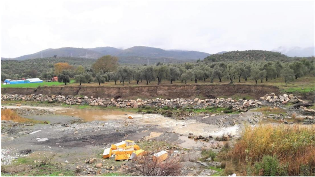
Foto 22: Şarköy'ün güneydoğusunda akarsuyun taşkın yatağında kıyı erozyonunun zeytinliklere zarar vermesinden dolayı taşlarla suni bir set yapılmıştır.
