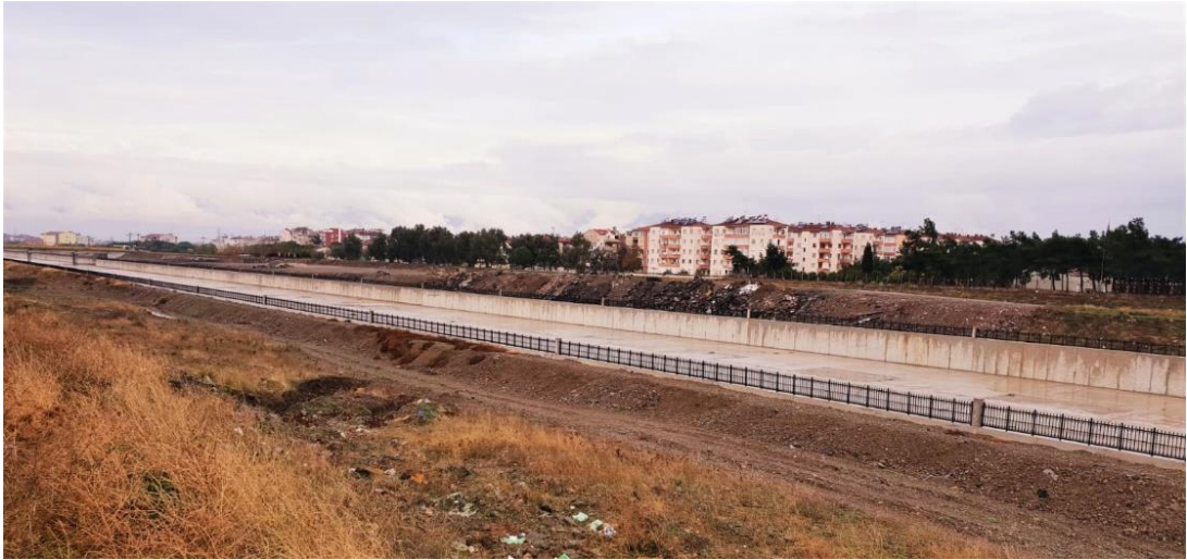
Foto 25: Cumhuriyet Mahallesi'nin kuzeydoğusunda, akarsuyun taşkın yatağı üzerine yapılan beton kanal.
