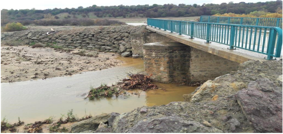
Foto 24: Tahtacı yerleşmesi yolu üzerindeki köprü. Köprünün ayakları suyun kinetik enerjisini azaltmak için kavisli yapılmıştır.
