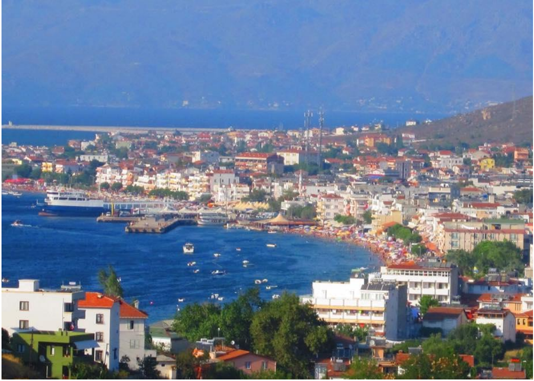
Foto 16: Avşa Yerleşmesinde Yer Alan Feribot Terminali ( Fotoğraf Güneyden Kuzeye Doğru Çekilmiştir.).
