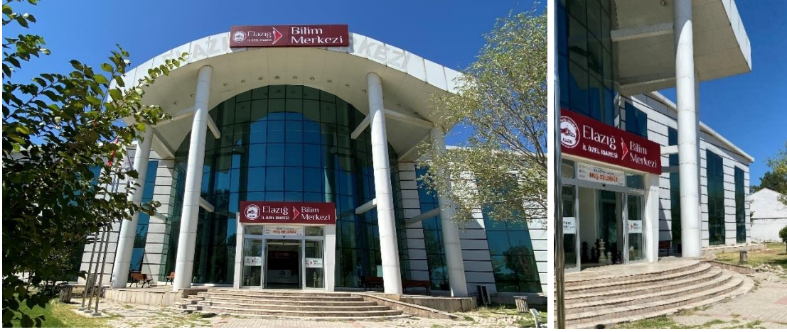
Şekil 7.22: Elazığ Bilim Merkezi Giriş Cephesi (yazar arşivi).
