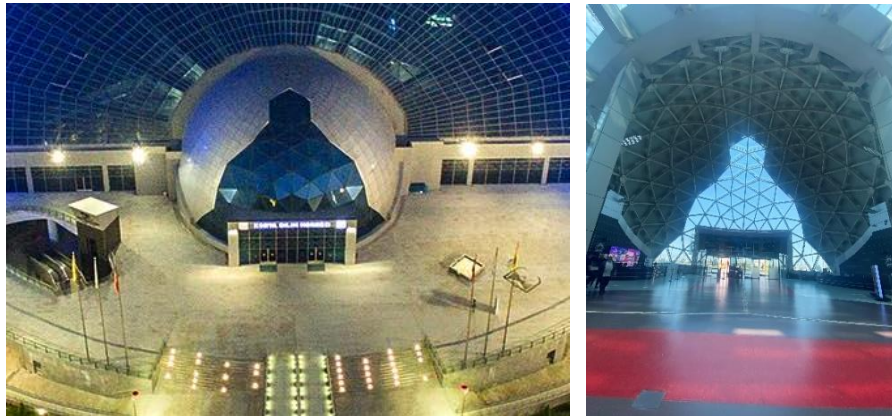
Şekil 7.10: Konya Bilim Merkezi giriş kapısı dışarıdan görünüşü (Konya Büyükşehir Belediyesi, tarih yok), giriş kapısı içeriden görünüşü (yazar arşivi).
