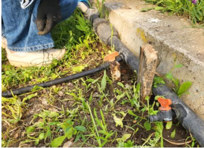
11. Su kaynağının vanasını açar
